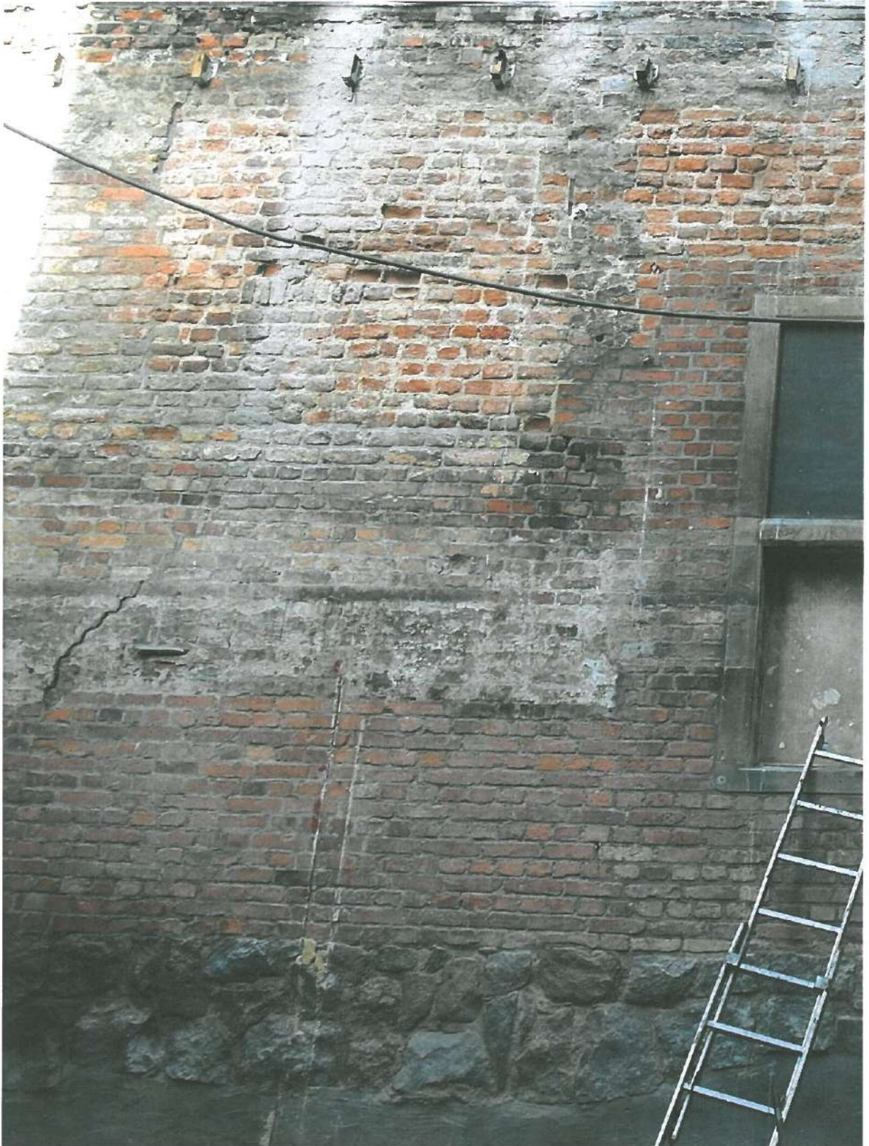
Fot.nr 12 Gdańsk, Stara Apteka –elewacja południowa. Fragment ściany parteru przylegającej do muru kurtynowego przed konserwacją, luty 2015r., fot. E. Przebirowska
