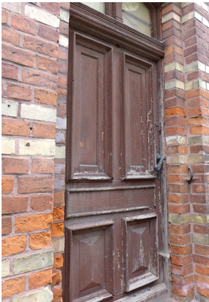
Fot. 29. Olsztyn, budynek przy ul. Prawocheńskiego 2, elewacja szczytowa – zachodnia. Widok ogólny na pierwotną stolarkę drzwiową. Widoczna zachowana klamka oraz podłużny szyld.
