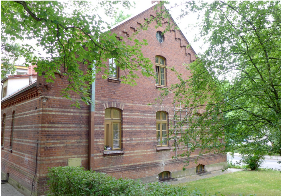
Fot. 15. Olsztyn, budynek przy ul. Prawocheńskiego 2, elewacja szczytowa wschodnia – widok ogólny.
