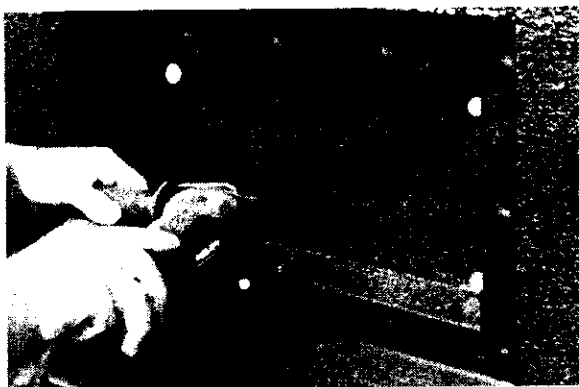
Fot. 7 Cięcie betonu szlifierką kątową
