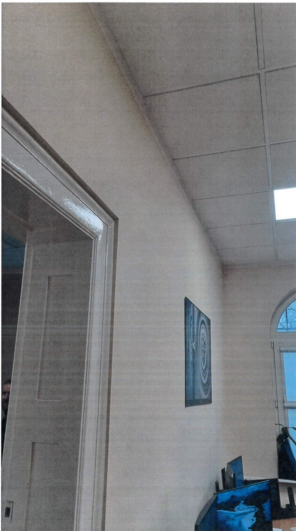
Widok ściany będącej przedmiotem opinii
