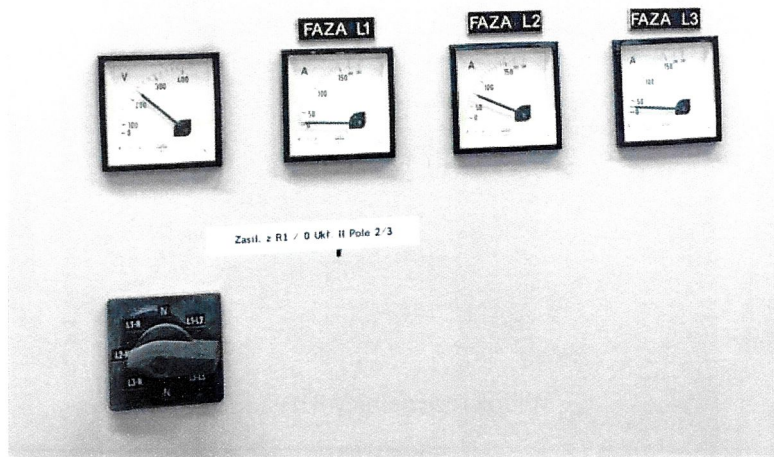
Widok Pola 2 rozdzielnicy R10-4 – fragment.
