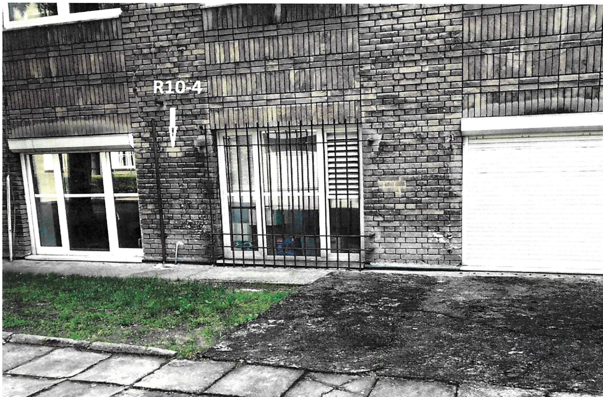
Rys. 5. Prezentacja lokalizacji rozdzielnic R10-4 w budynku Wydziału Elektrotechniki od strony zachodniej
