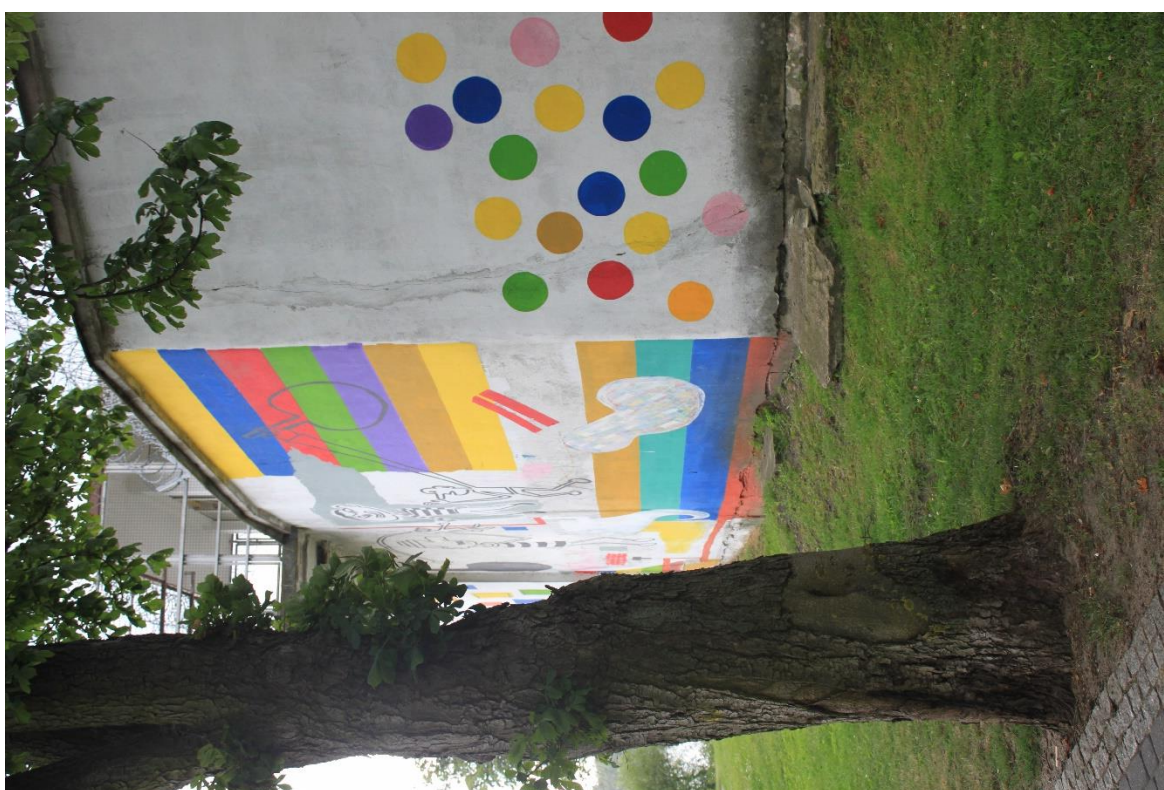
Fot. Nr 23, 24. Areszt Śledczy z1900 roku, mur obejmujący obszar więzienia, stan zachowania w 2019 r. Fragment muru od strony jeziora, mural zasłaniający wielokrotnie naprawiane tynki. Na górnej fotografii widoczna wieża strażnicza, betonowy podest osadzony na dwuteownikach, powiększony z dwóch stron dolewkami. W osi wieży mur jest cofnięty o 5-6cm. Obróbka blacharska osłania gzyms okapnikowy. Spękania muru związane z ruchami podłoża oraz zdylatowaniem się sztywnego ogrodzenia. Widoczne betonowe, wylwane elementy, niewiadomego pochodzenia leżące wzdłuż muru. Brak regularnego ukształtowania terenu wokół ogrodzenia umożliwiającego odpływ wody opadowej. Drzewo w sąsiedztwie może być także przyczyną niszczenia fundamentów ogrodzenia. Pochodzi ono z czasów budowy więzienia.
