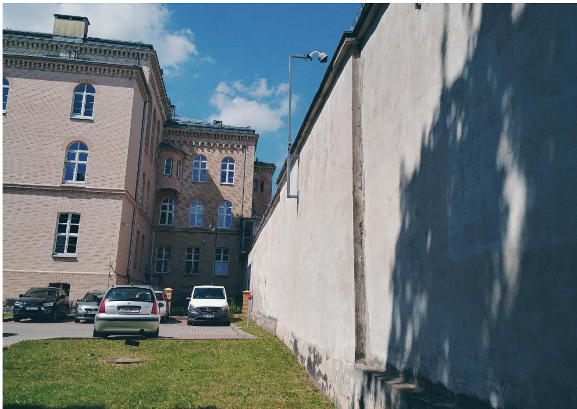
Fot. Nr 1. Areszt Śledczy z1900 roku, mur obejmujący obszar więzienia, stan zachowania w 2019 r. Mur pokryty silnym, cementowym tynkiem, zatartym na szorstko, widoczny fundament wys. 35cm do 45cm w kierunku narożnika od strony jeziora Domowe Małe, część fundamentowa pokryta mikroorganizmami, uskok w licu muru o długości około 4,5m szerokość występu do 10cm, korona muru nakryta nakrywą cementową z kapinosem. W koronie zamontowane druty ochronne zabezpieczające. Fot. wyk. Szymon Konecko, lipiec 2019r.
