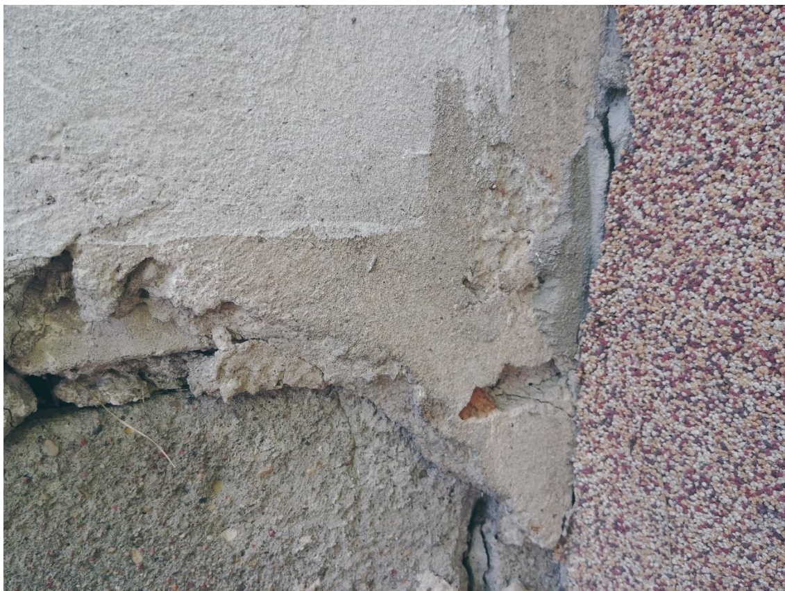
Fot. Nr 39, 40. Areszt Śledczy z 1900 roku, mur obejmujący obszar więzienia, stan zachowania w 2019 r. Widok ogólny w kierunku jeziora ostatniego fragmentu muru od strony północno-zachodniej, połączonego z budynkiem. Ostatni odcinek muru współcześnie, uskokowo nadbudowany przy pomocy dużych bloczków silikatowych na które zatarto równomiernie klej do styropianu. Poniżej styki muru z cegły silikatowej, leżących na wylewanym fundamencie z leżącymi na nich tynkami i zachodzącym współczesnym tynkiem akrylowym wypełniaczem jaki położono na docieplenie budynku więzienia.
