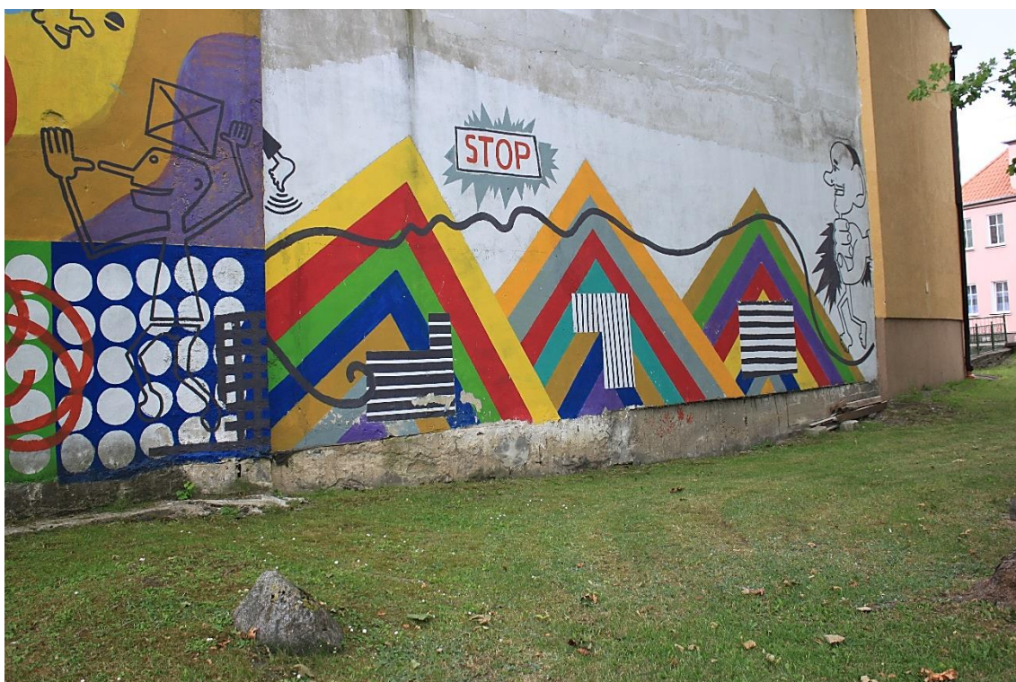
Fot. Nr 32, 33. Areszt Śledczy z 1900 roku, mur obejmujący obszar więzienia, stan zachowania w 2019 r. Widok ogólny fragmentu muru od strony północno-zachodniej. Mural zasłaniający wielokrotnie naprawiane tynki ogrodzenia. Wystająca betonowa ława o nieregularnej powierzchni jest zniszczona, pokryta glonami. Zauważalne jest odcinkowe wykonywanie fundamentu. Utrzymujące się zawilgocone ściany powoduje niszczenie cienkowarstwowych ostatnich zatarć związanych z odnowieniem podłoża i pomalowaniem muralu. Widoczne łuszczenie się wierzchnich warstw. Ostatni odcinek muru nadbudowany współcześnie przy pomocy dużych bloczków silikatowych.
