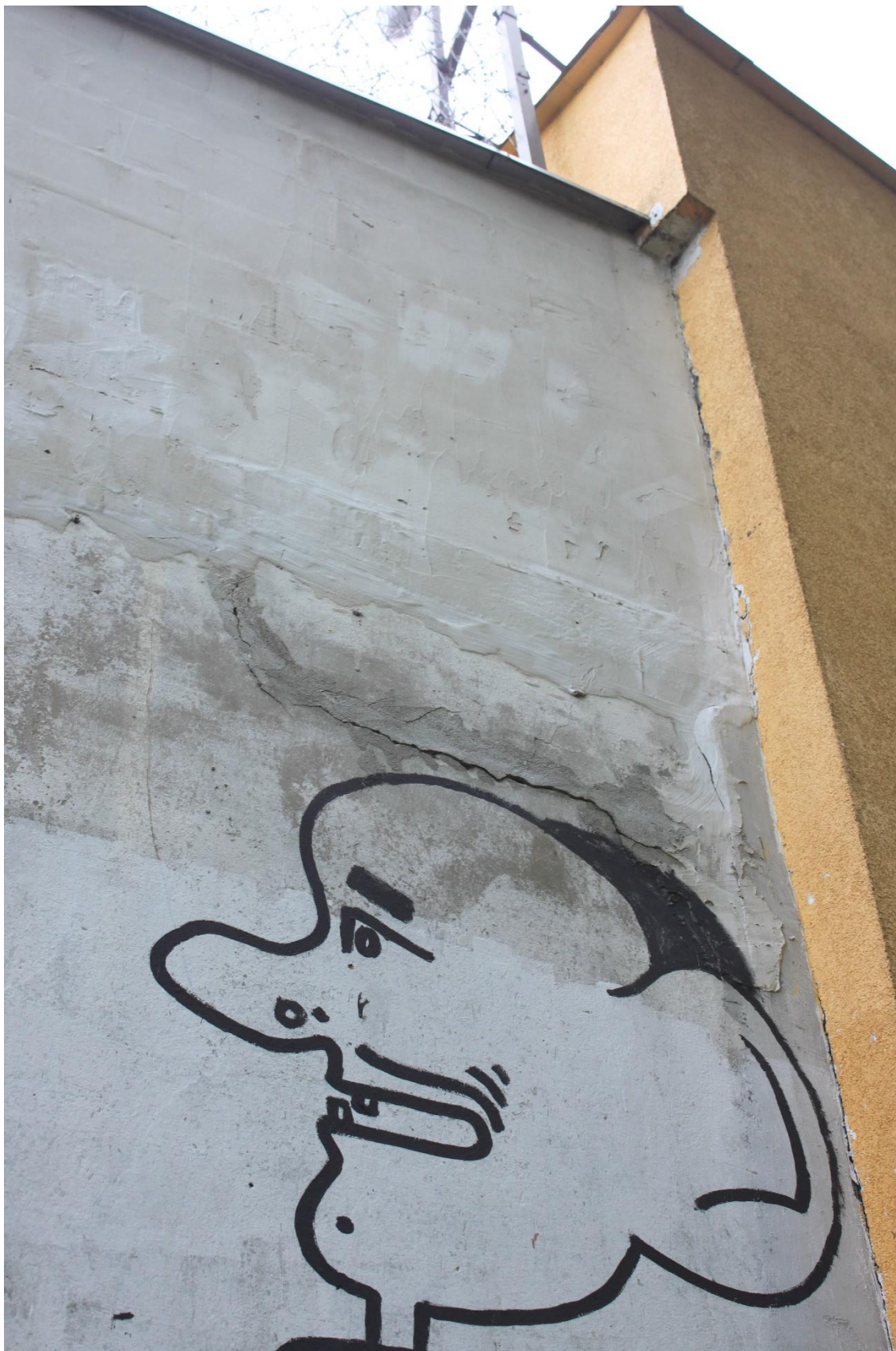
Fot. Nr 38. Areszt Śledczy z1900 roku, mur obejmujący obszar więzienia, stan zachowania w 2019 r. Widok ogólny ostatni fragment muru od strony północno-zachodniej połączony z budynkiem. Ostatni odcinek muru współcześnie, uskokowo nadbudowany przy pomocy dużych bloczków silikatowych na które zatarto równomiernie współczesny tynk cementowy i klej do styropianu.
