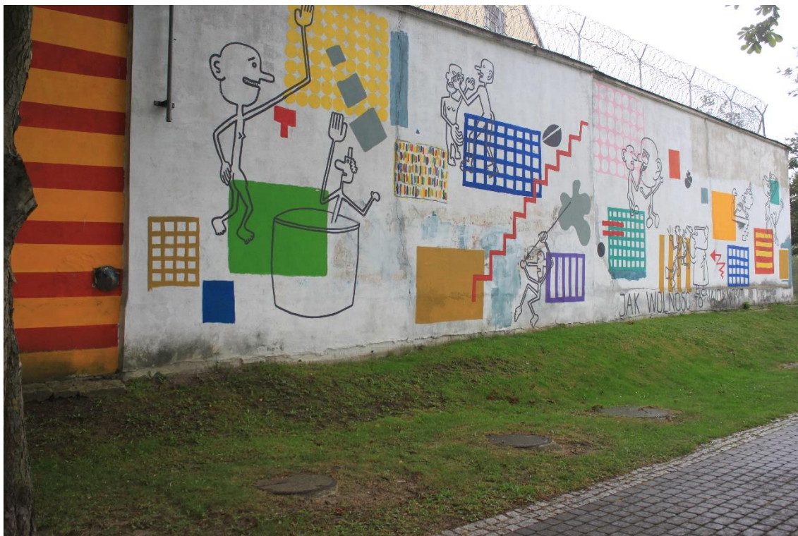
Fot. Nr 11, 12. Areszt Śledczy z1900 roku, mur obejmujący obszar więzienia, stan zachowania w 2019 r. Fragment muru od strony jeziora, mural zastępujący wielokrotnie naprawiane tynki. Wzdłuż muru i chodnika biegnącego tuż przy brzegu jeziora, studzienki kanalizacyjne.
