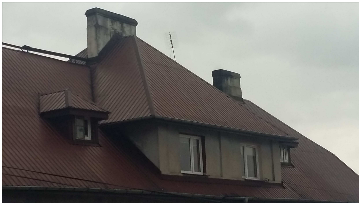
6. LUKARNA OD STRONY ZACHODNIEJ BUDYNKU
