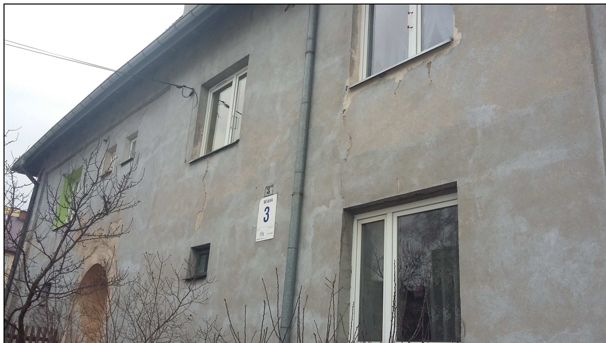
10. FRAGMENT ELEWACJI PÓŁNOCNO-WSCHODNIEJ BUDYNKU
