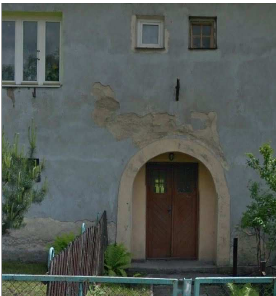
9. JEDNO Z WEJŚĆ (OD STRONY ZACHODNIEJ) DO KLATKI SCHODOWEJ
