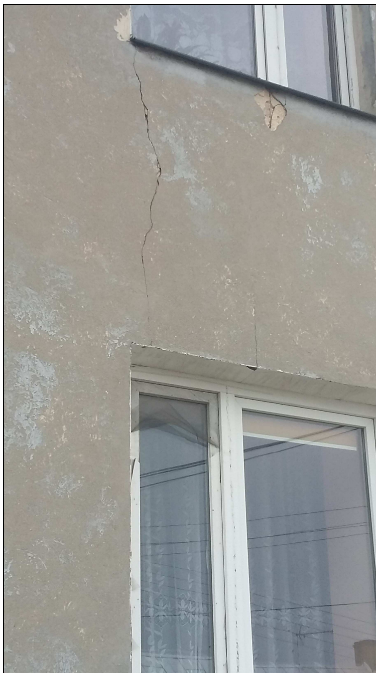
11. LUKARNY OD STRONY PÓŁNOCNO-WSCHODNIEJ BUDYNKU
