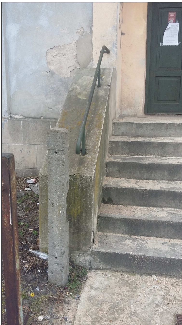
12. JEDNO Z WEJŚĆ (OD STRONY ZACHODNIEJ) DO KLATKI SCHODOWEJ
