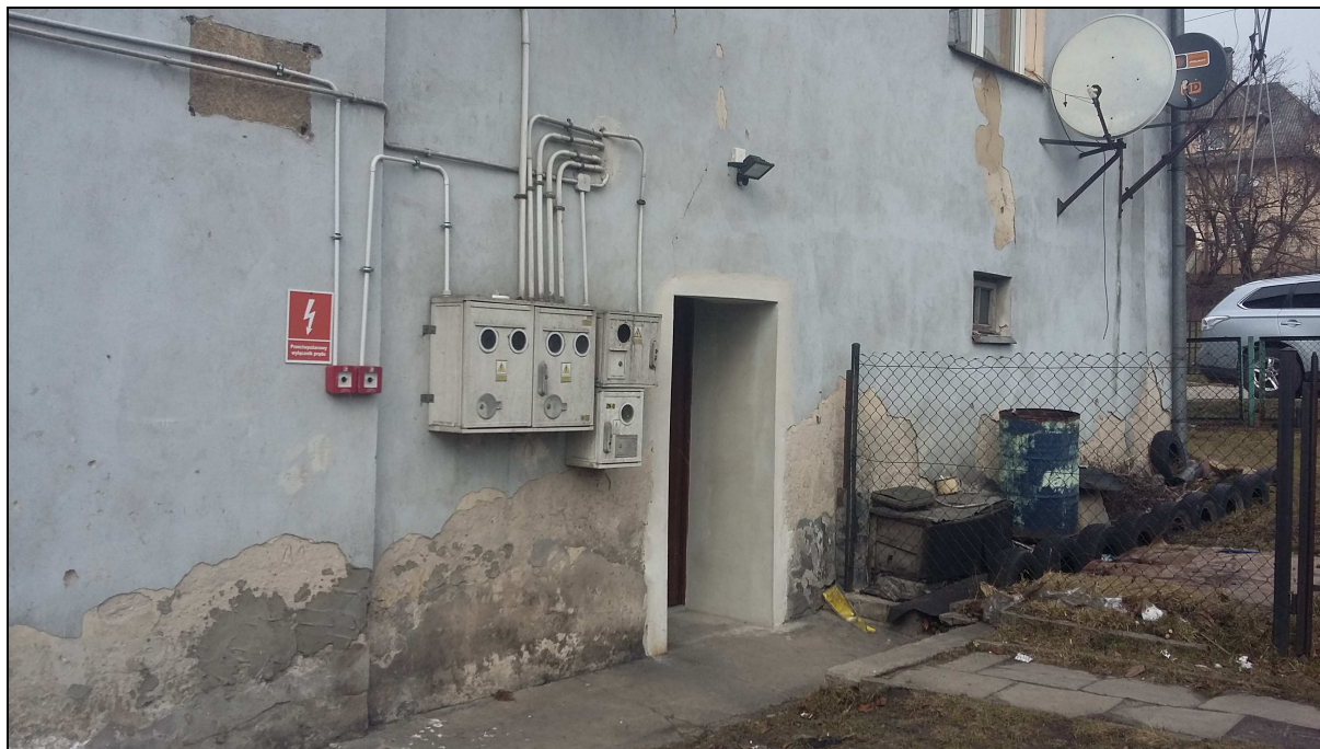
8. JEDNO Z WEJŚĆ (OD STRONY WSCHODNIEJ) DO KLATKI SCHODOWEJ
