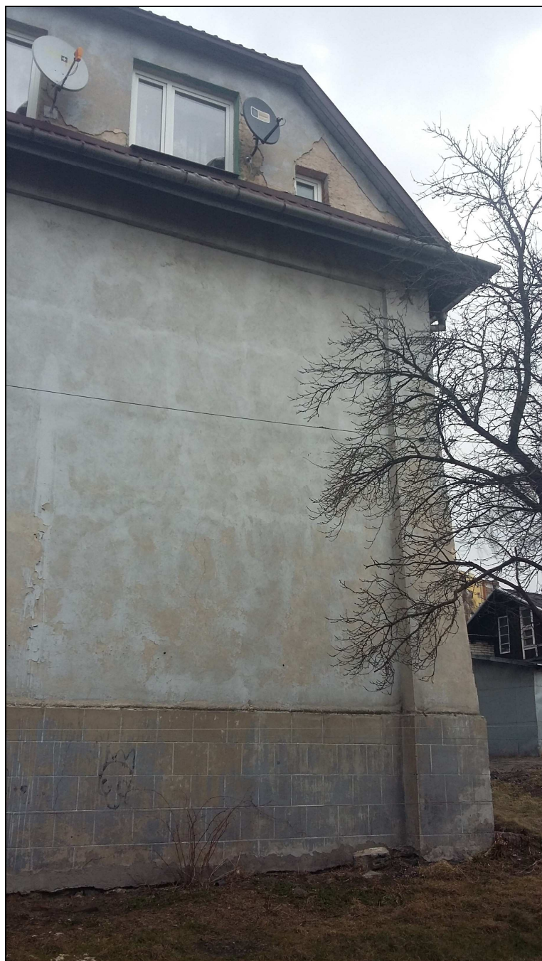
4. ELEWACJA BUDYNKU WIELORODZINNEGO PRZY UL. WIDOK 3 - OD STRONY POŁUDNIOWEJ
