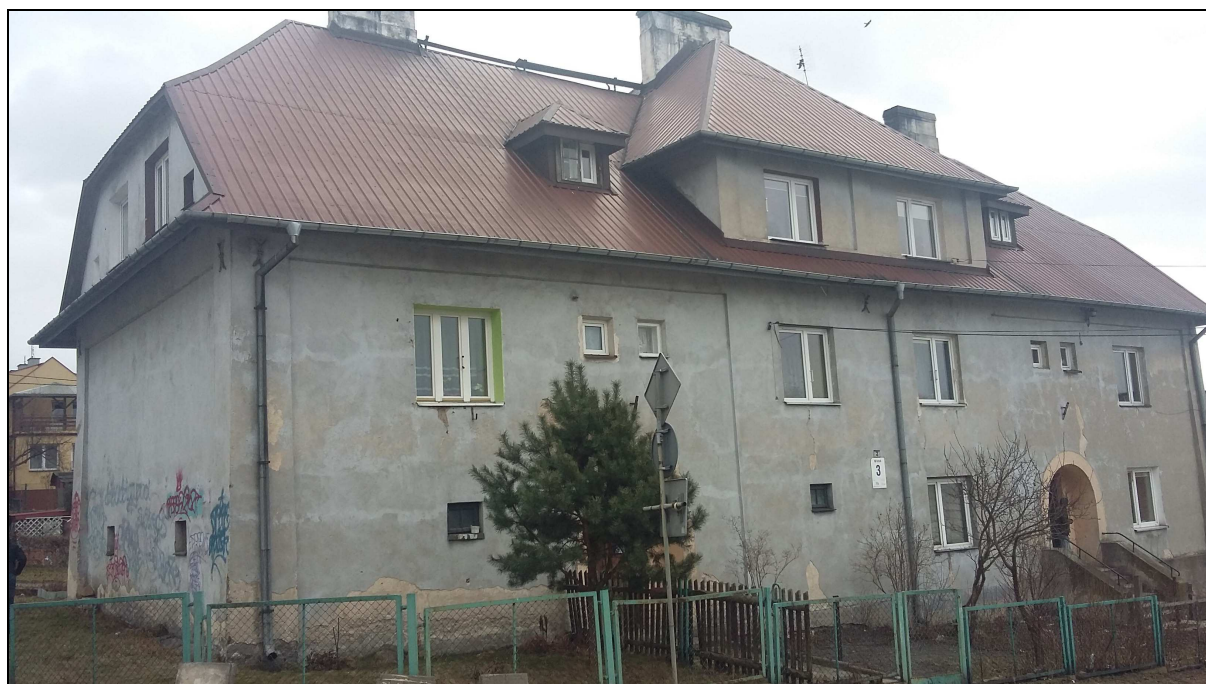
2. ELEWACJA BUDYNKU WIELORODZINNEGO PRZY UL. WIDOK 3 - OD STRONY ZACHODNIEJ
