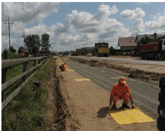
Rozmieszczenie tacek pomiarowych
