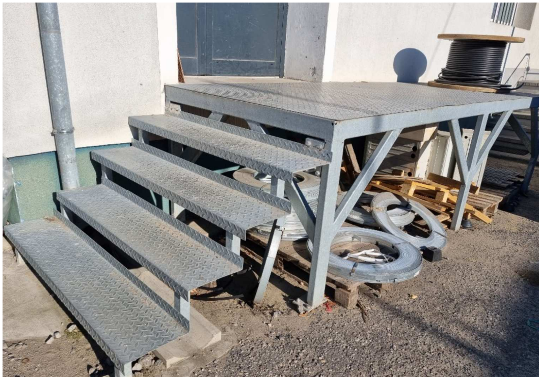
Przykładowe schody z rampą ze stali ocynkowanej
