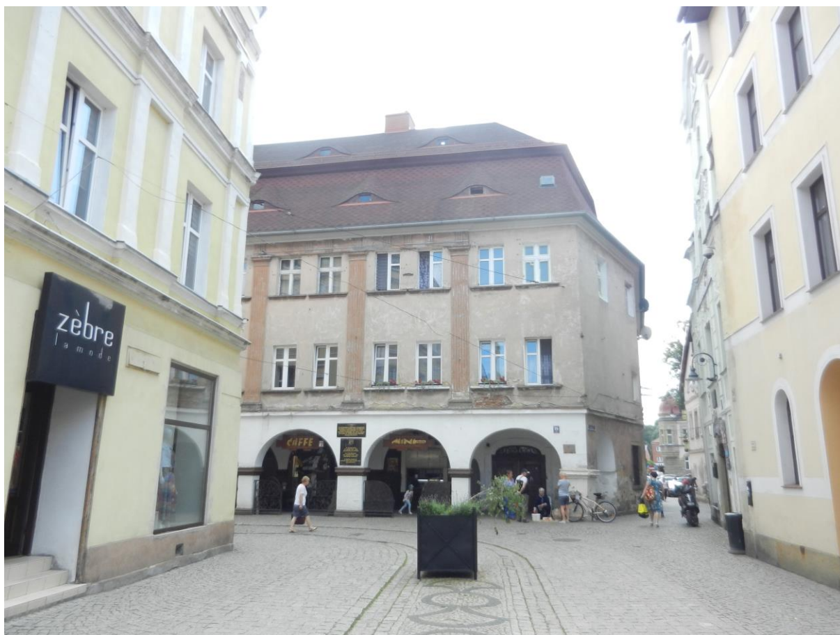
Aktualna fotografia budynku
