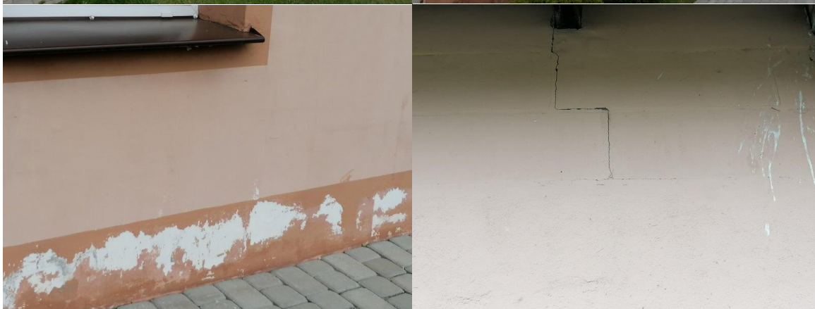
Widok elewacji c.d.
