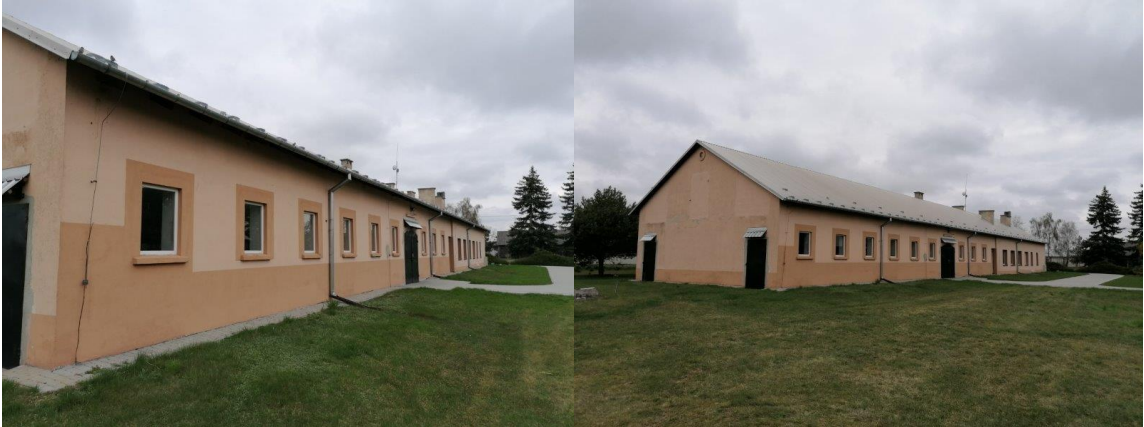
Widok elewacji c.d.
