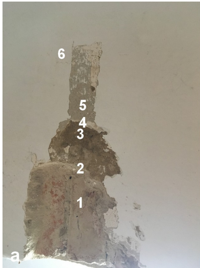
Fot. 14. a) Odkrywka nr 5, 1 – mur ceglany, 1817, 2-3 - tynk wapienno-piaskowy w dwóch różnobarwnych warstwach, 1817, 4 – pobiału wapienna, 1817, 5 – naprawa tynkarska z białym przemalowaniem, II poł XX w., 6 – obecne przemalowanie; b) Stan techniczny rur spustowych
