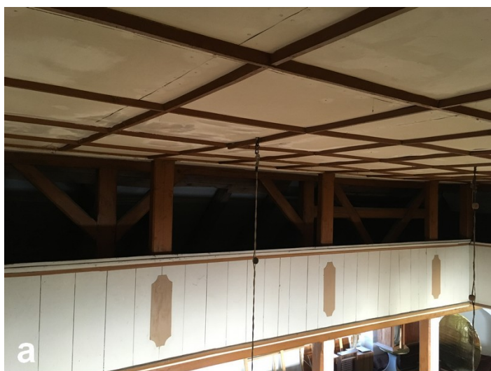
Fot. 18. a) Maskowany płytami pilśniowymi drewniany strop i górna kondygnacja empory z litą deskową balustradą ozdobioną wtórnie plicinami wyciętymi z płyty pilśniowej b) Odkrywka nr 6 na balustradzie jak wyżej 1 – drewno, 1817 2 – szara warstwa malarska, 1817 3 – przemalowanie II połowa XX w. 4 – przemalowanie z końca XX w.
