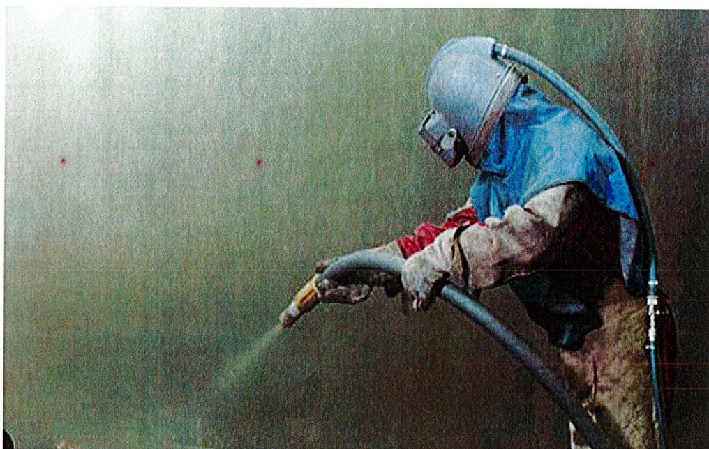
Rys. 2. Czyszczenie mechaniczne - piaskowanie.
