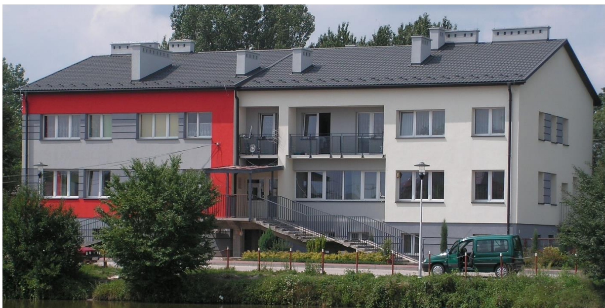
Zdjęcie poglądowe – konstrukcja dachu
