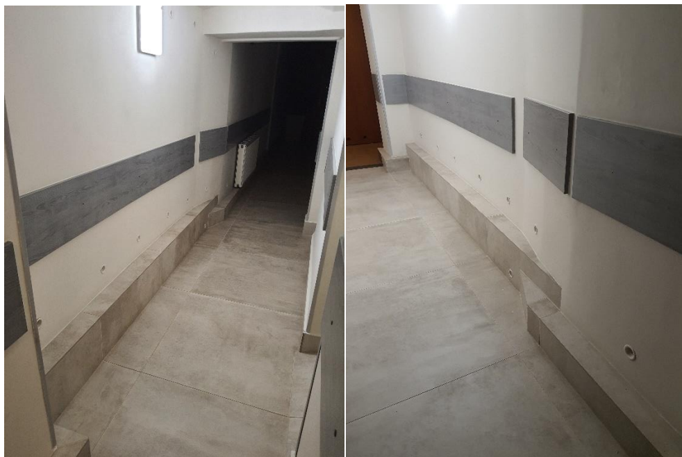
Fot. 73, 74 Parter budynku, korytarz – po lewej ściana północna ponad ściana piwniczną. Ściana zabudowana płytami g-k, ponad cokolikiem widoczne otwory wentylacyjne.
