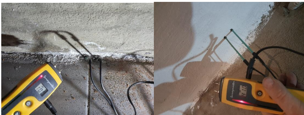
Fot. 39, 40 Ściana północna – faseta na połączeniu z posadzką, pomiar wilgotności strukturalnej przy użyciu sond wgłębnych (Protimeter SurveyMaster SM, krzywa kalibracji wg miernika karbidowego CM-Gerat), wynik: >21% - narożnik bardzo silnie zawilgocony. Po prawej: analogiczny pomiar wilgotności strukturalnej sklepienia ceglanego, wynik: 13% - sklepienie silnie zawilgocone.
