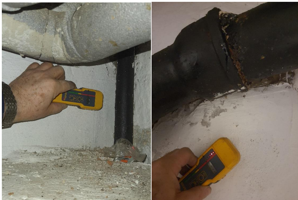
Fot. 59, 60 Ściana południowa: pomiar wilgotności strukturalnej przy użyciu sondy radiowej (Protimeter SurveyMaster SM, krzywa kalibracji wg miernika karbidowego CM-Gerat): na wysokości ok. +0,2m ppp, wynik 8% - ściana zawilgożona. Po prawej: ściana zachodnia w części cokołowej, wynik: 20% - ściana bardzo silnie zawilgożona.
