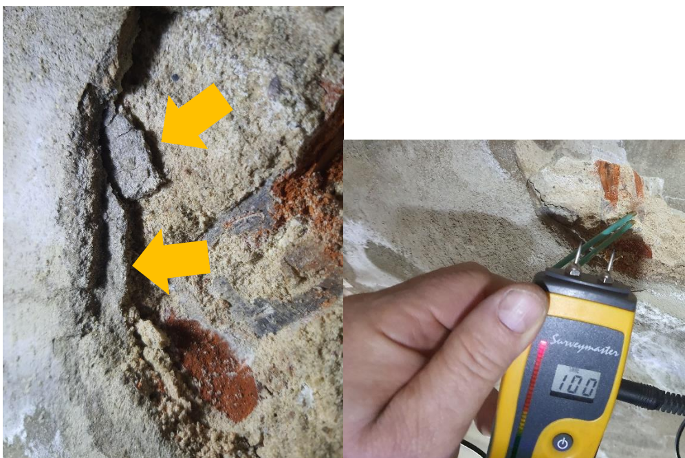
Fot. 13, 14 Odkrywka na ścianie północnej: pierwsza warstwa wyprawy z zaprawy cementowej ułożona na tynku cem-wap. Po prawej: pomiar wilgotności
