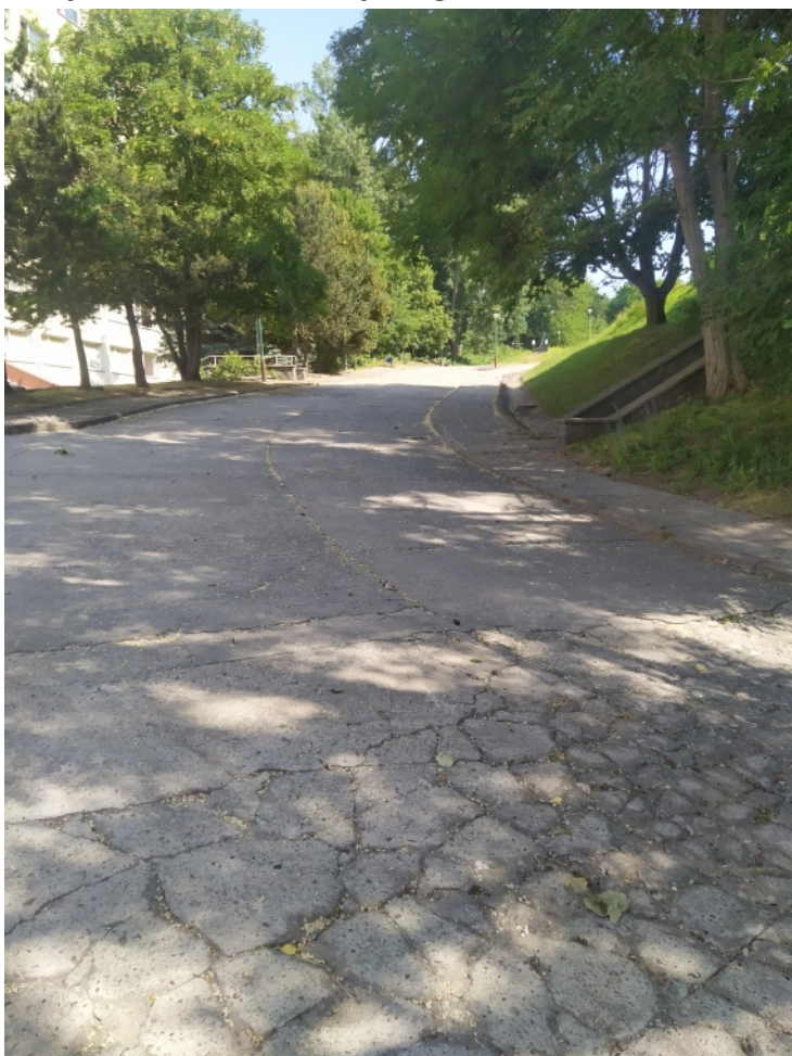
3. Nawierzchnia ist. betonowa drogi do remontu
