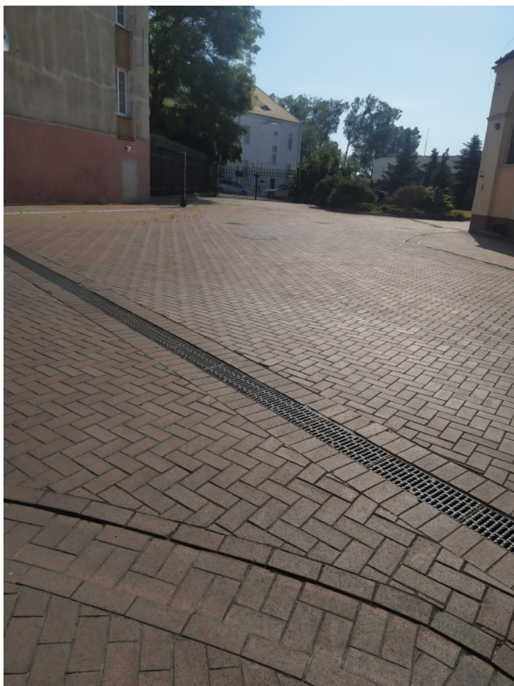
1. Nawierzchnia ist. z klinkieru na dziedzińcu w rejonie remontowanej drogi
