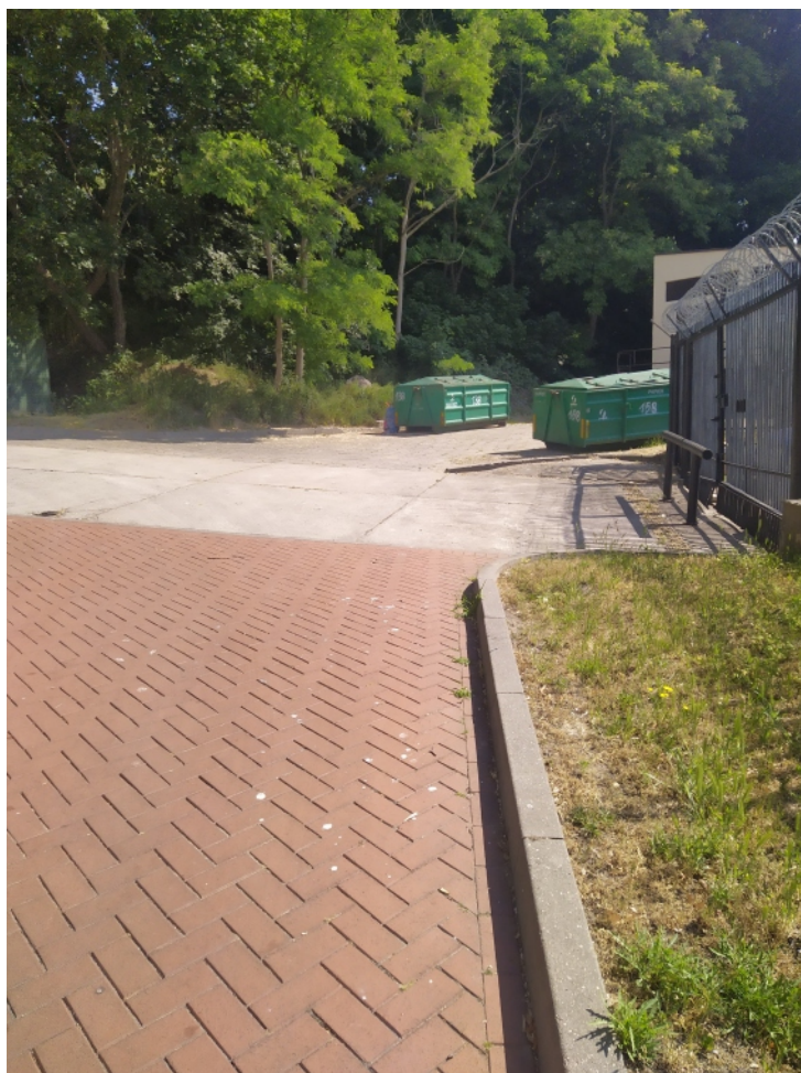
2. Nawierzchnia ist. z kostki na styku z początkiem drogi do remontu
