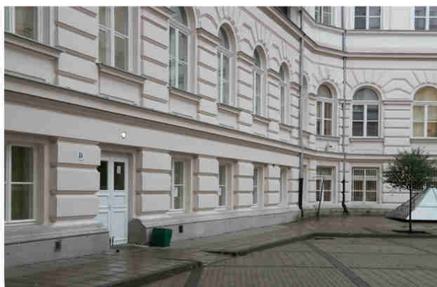
Pochylnia umożliwiająca znalezienie się na poziomie krawężnika
