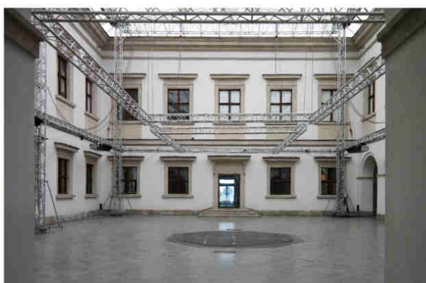
Dostępna strefa atrium, możliwość dowolnego kształtowania przestrzeni
