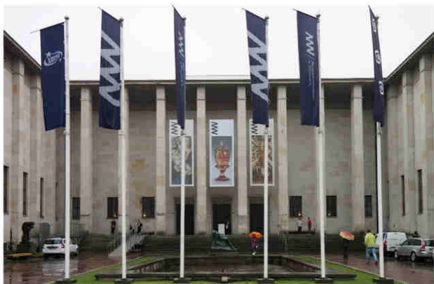
Zastosowanie podnośnika oraz pochylni, której konstrukcja nie niszczy schodów zabytkowego budynku. Drzwi wejściowe automatyczne, bez progów
