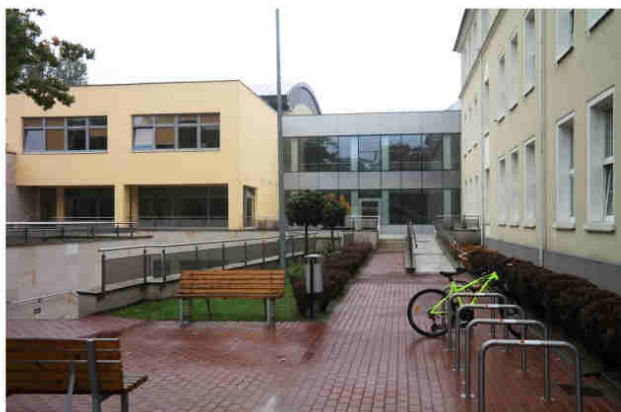
Wejście główne zlokalizowane od strony wewnętrznego dziedzińca, miejsce bezpieczne. Pochylnia prowadząca do wejścia głównego
