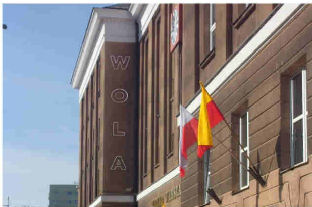
Neon na fasadzie głównej wspomagający identyfikację obiektu
