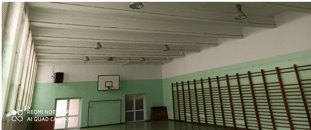
fot 1. Pomieszczenie [sala gimnastyczna] bez adaptacji akustycznej – stan istniejący.
