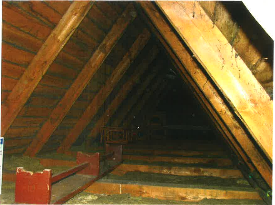
Fot. 5. Widok konstrukcji dachu
