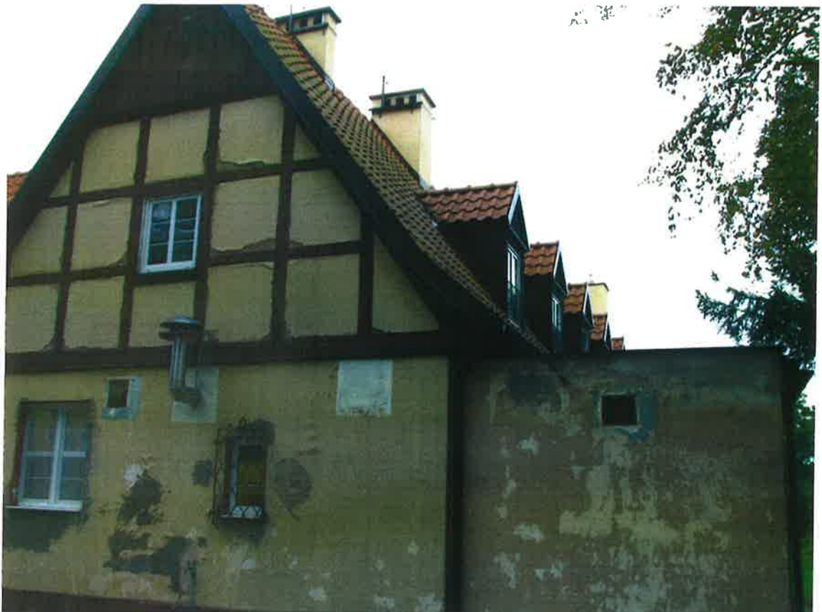
Fot. 4. Widok od szczytu dach wysoki
