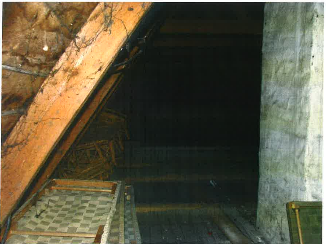
Fot. 6. Widok konstrukcji dachu
