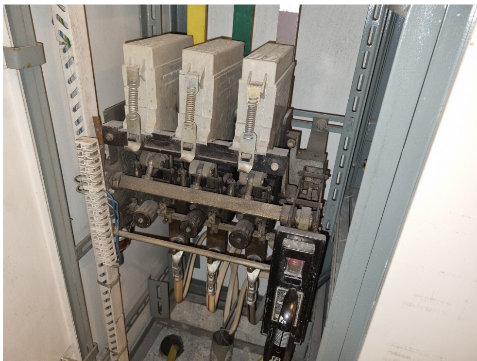
Fot. 4Pole zasilające – wyłącznik APU.
