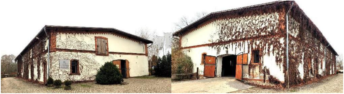
Rys. 1 Elewacja ólnocna i południowa budynku stajni.
