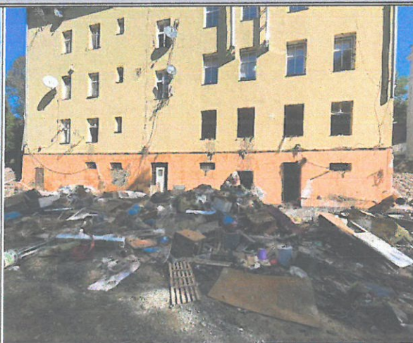
Fot. 2 Widok elewacji podwórzowej – elewacja zachodnia
