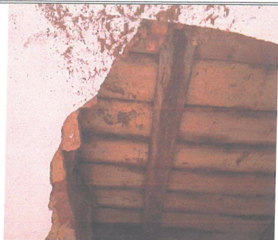
Fot. 10 Widok 2 pozostałości zawalonego sklepienia nad piwnicą. Widoczne legary oraz podłoga drewniana parteru
