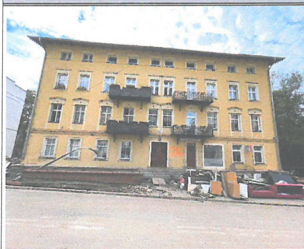
Fot. 1 Widok elewacji frontowej – elewacja wschodnia
