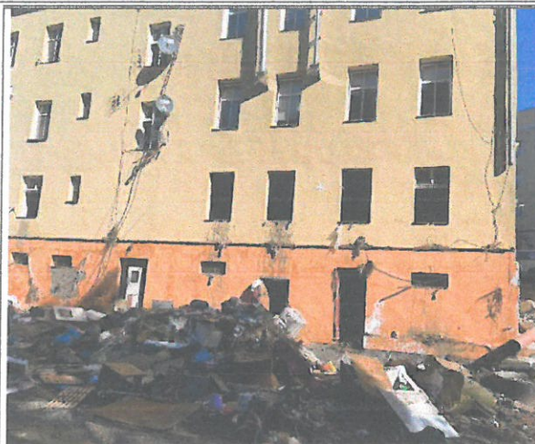
Fot. 3 Widok 2 elewacji podwórzowej – elewacja zachodnia
