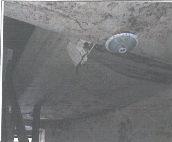
Fot. 15 Widok stropu nad piwnicą. Strop drewniany w strefie komunikacyjnej
