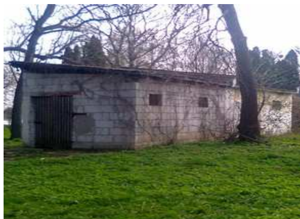
Zdj. nr 5 – Budynek „barak”
