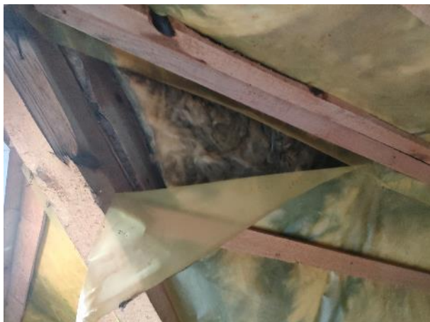
Fot. 36. Zawilgocenie dachu.
