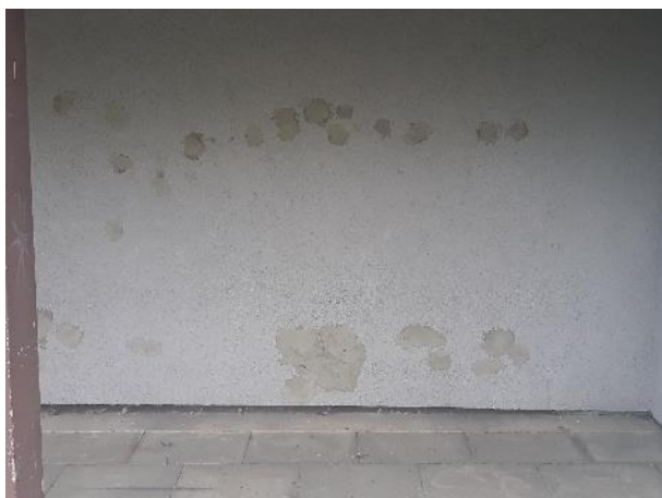
Fot. 30. Uszkodzenie tynku zewnętrznego.
