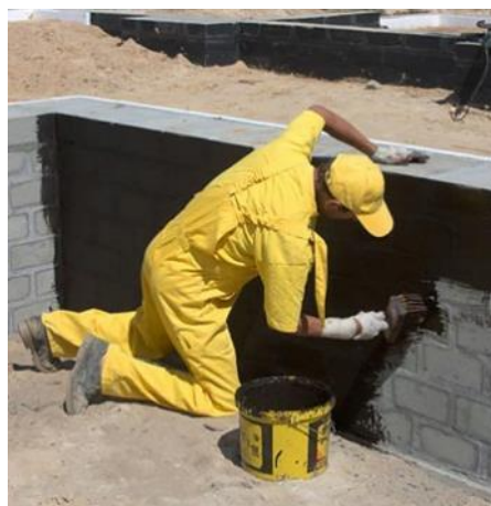
Fot. 54. Wykonanie izolacji pionowej.
