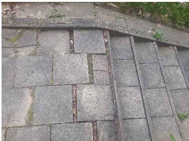
Fot. 24. Schody zewnętrzne - uszkodzenia.
