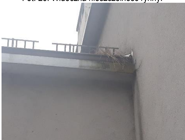
Fot. 28. Widoczne zanieczyszczenie rynny.
