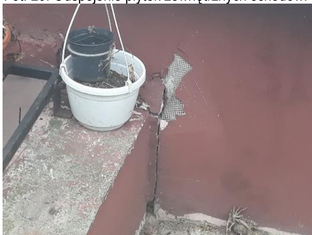
Fot. 22. Uszkodzenia tynku zewnętrznego.
