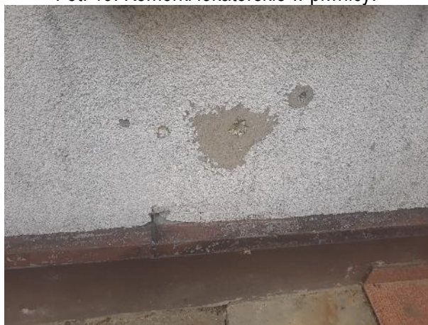
Fot. 21. Uszkodzenia tynku zewnętrznego.
