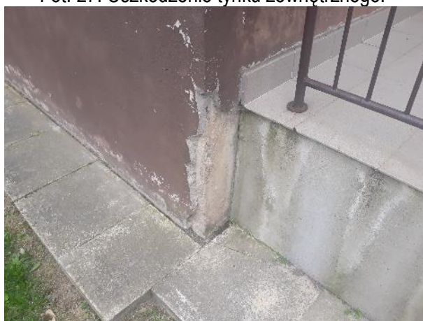
Fot. 29. Uszkodzenie tynku zewnętrznego.
