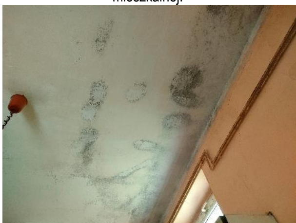
Fot. 43. Wnętrze budynku – zagrzybienie w części mieszkalnej.
