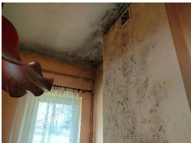
Fot. 41. Wnętrze budynku – zagrzybienie w części mieszkalnej.
