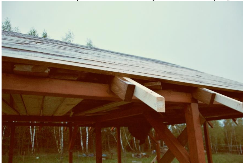
Fot. 57. Szczegół wydłużenia połaci dachowej
