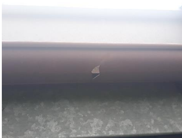
Fot. 31. Uszkodzenie rynny.
