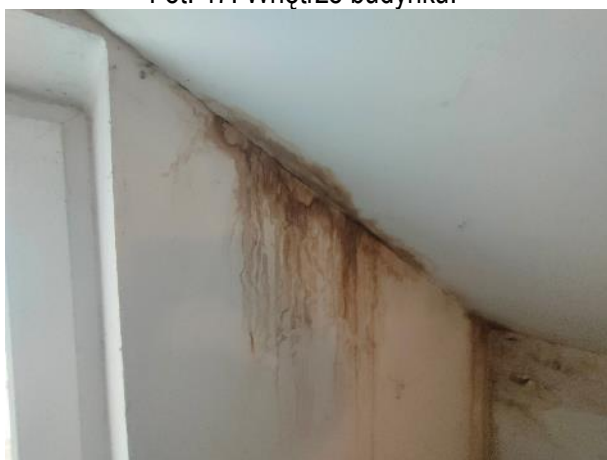
Fot. 49. Wnętrze budynku - zawilgocenie.
