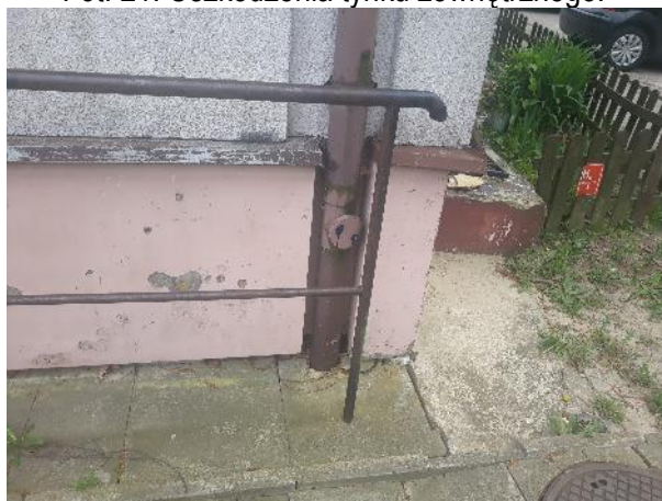
Fot. 23. Nieszczelność rury spustowej.
