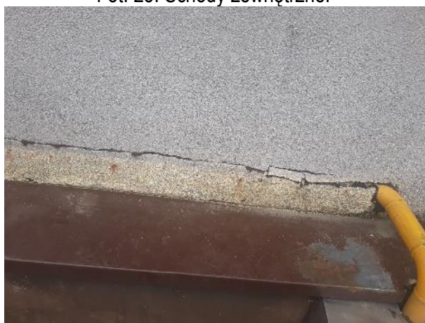
Fot. 27. Uszkodzenie tynku zewnętrznego.
