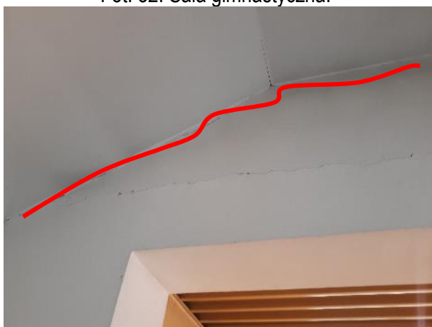
Fot. 34. Zarysowanie tynku wewnętrznego.
