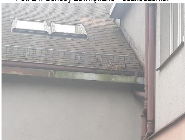
Fot. 26. Widoczna nieszczelność rynny.
