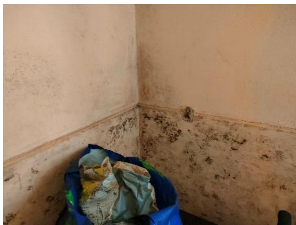
Fot. 42. Wnętrze budynku – zagrzybienie w części mieszkalnej.
