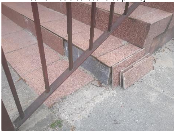
Fot. 20. Odspojenie płytek zewnętrznych schodów.
