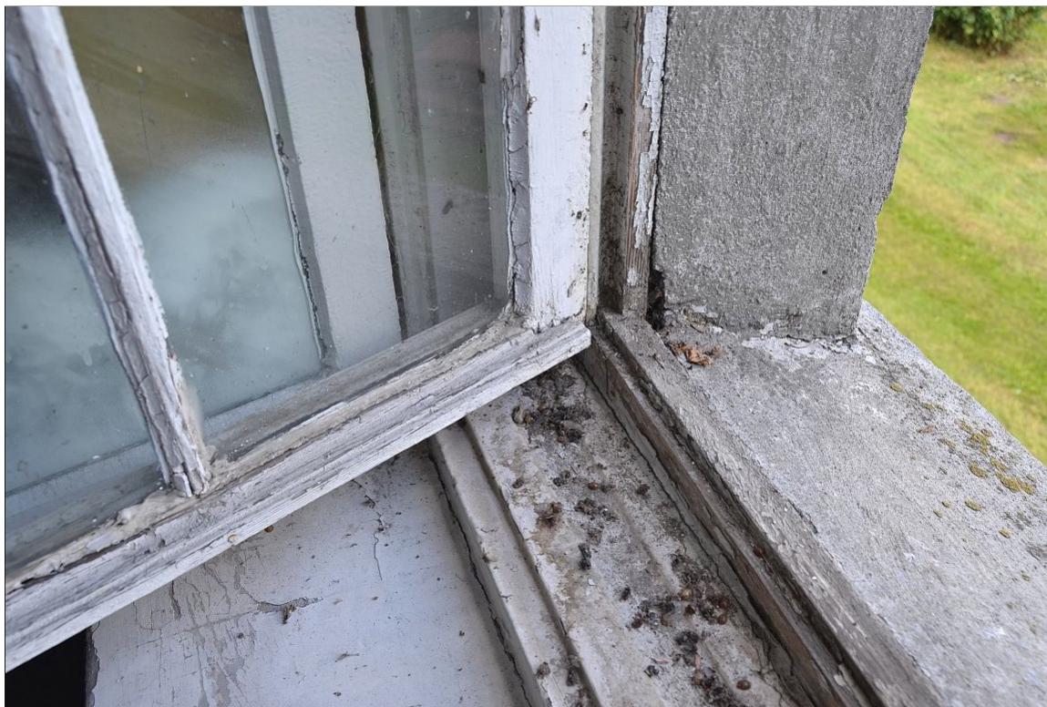
II. 11 Pławin, budynek dawnego dworu
