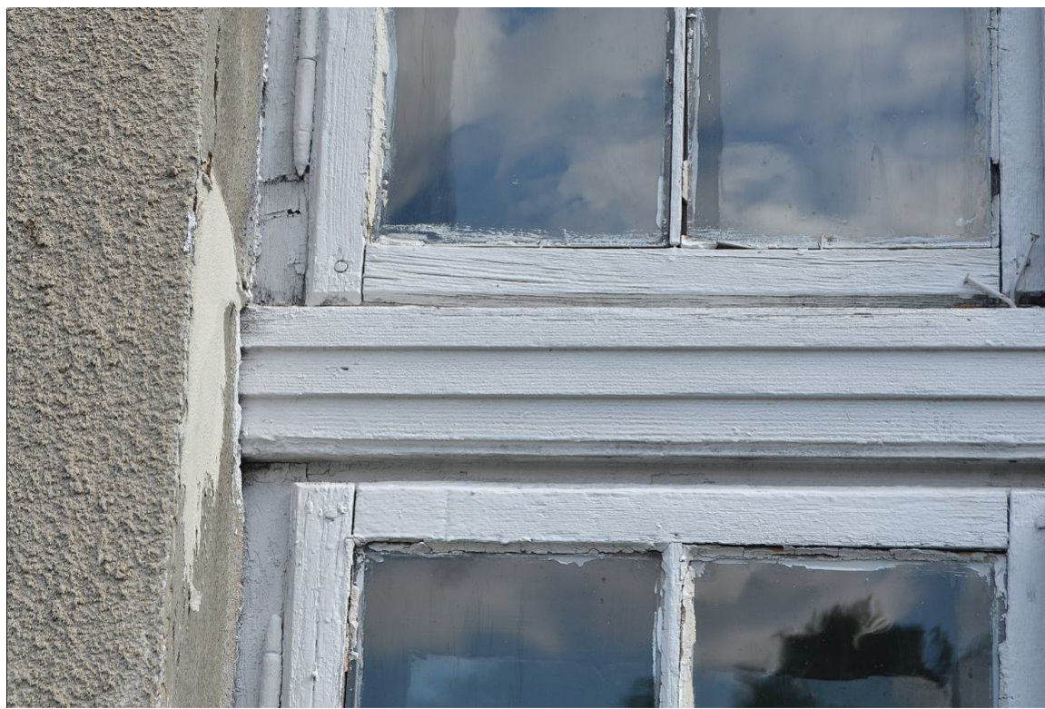
II. 30 Pławin, budynek dawnego dworu
