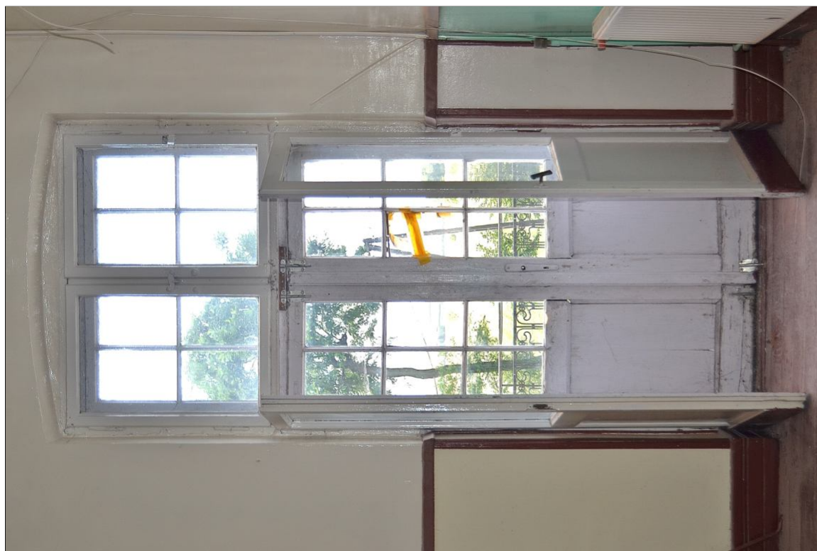
II. 39 Pławin, budynek dawnego dworu - drzwi balkonowe TYP D/I – pierwotna stolarka okienna, rewers
