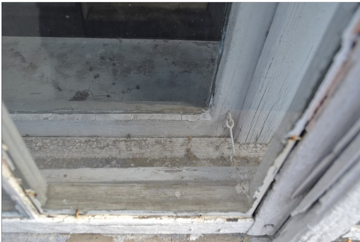
II. 31 Pławin, budynek dawnego dworu
