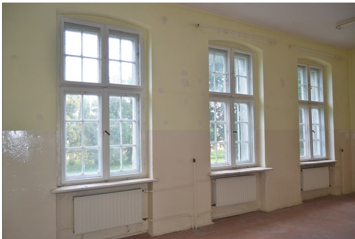
II. 7 Pławin, budynek dawnego dworu, I piętro
