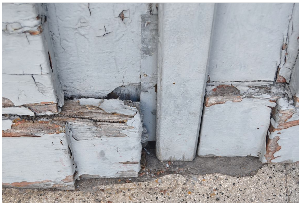
II. 64 Pławin, budynek dawnego dworu
