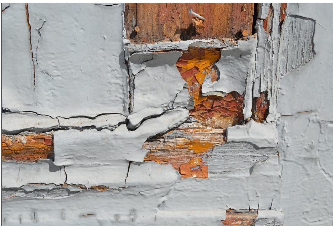
II. 66 Pławin, budynek dawnego dworu
