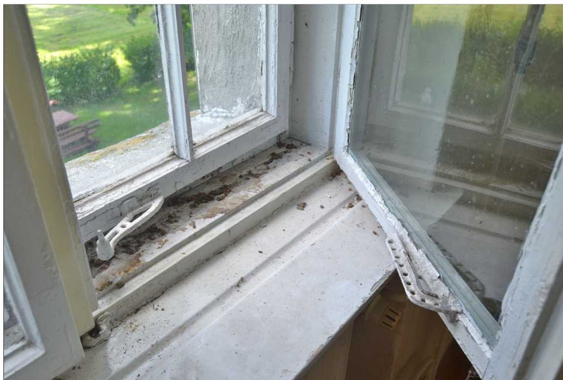
II. 21 Pławin, budynek dawnego dworu
