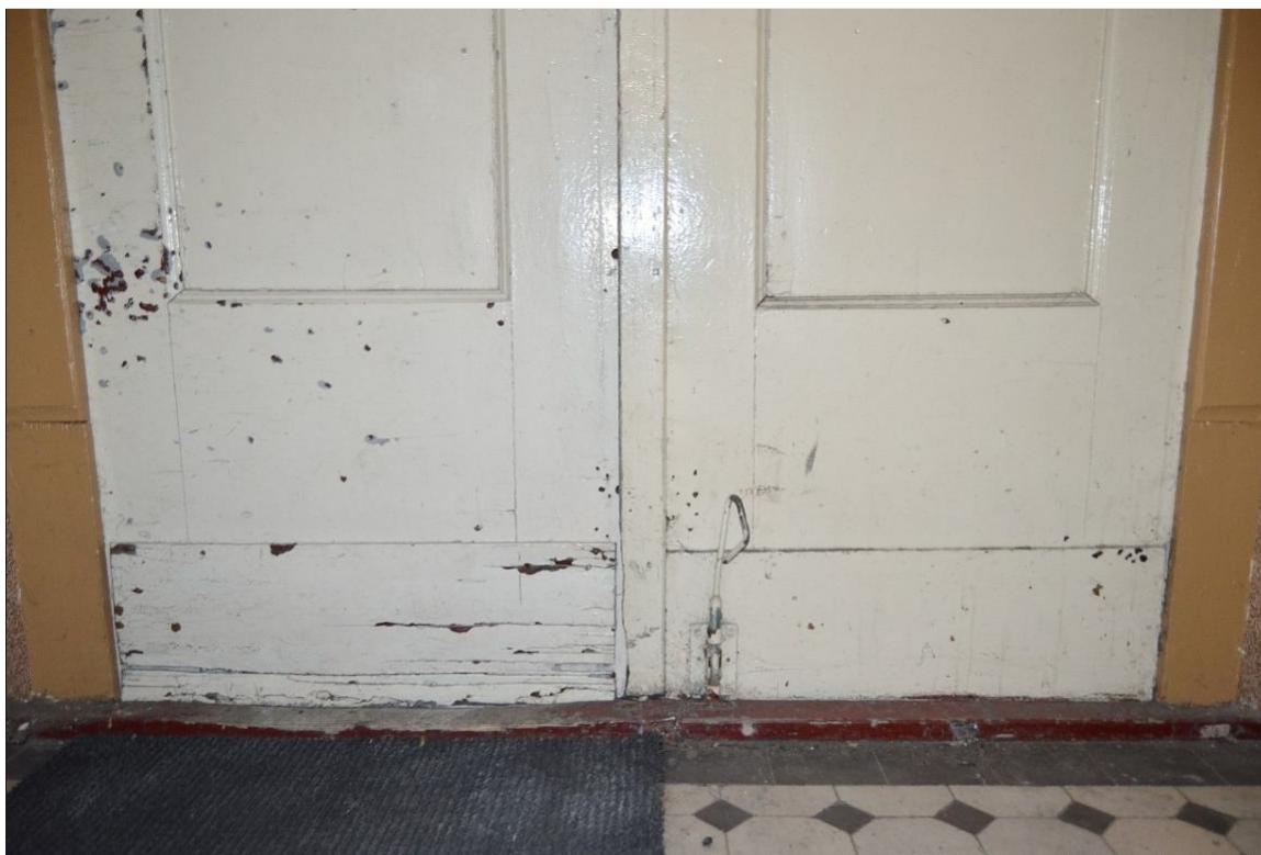
II. 76 Pławin, budynek dawnego dworu
