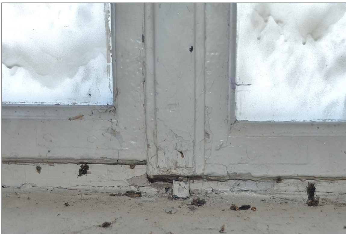
II. 17 Pławin, budynek dawnego dworu
