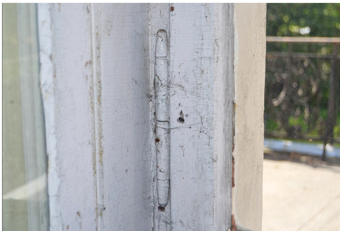
II. 52 Pławin, budynek dawnego dworu
