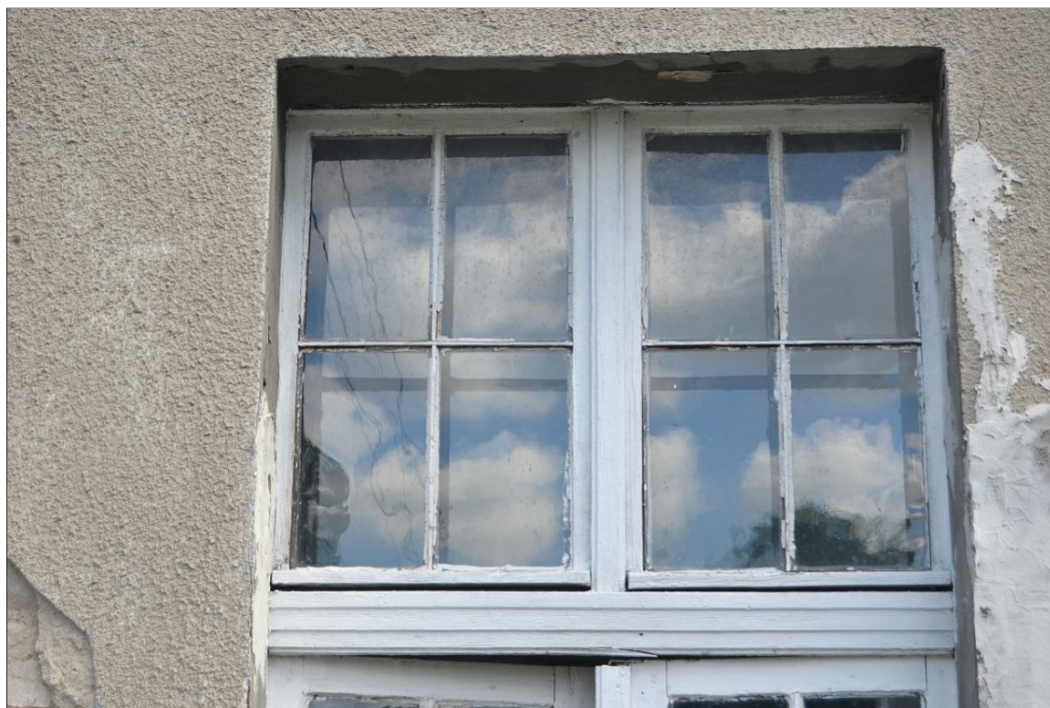
II. 41 Pławin, budynek dawnego dworu
