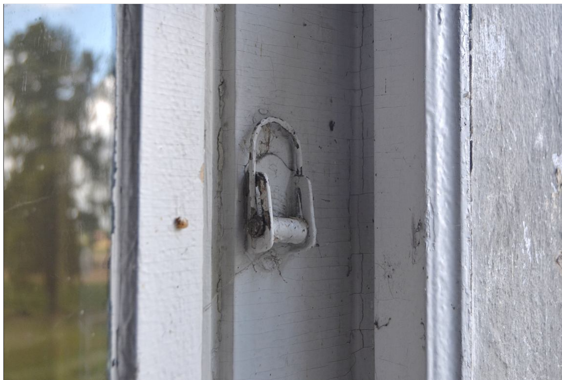
II. 22 Pławin, budynek dawnego dworu
