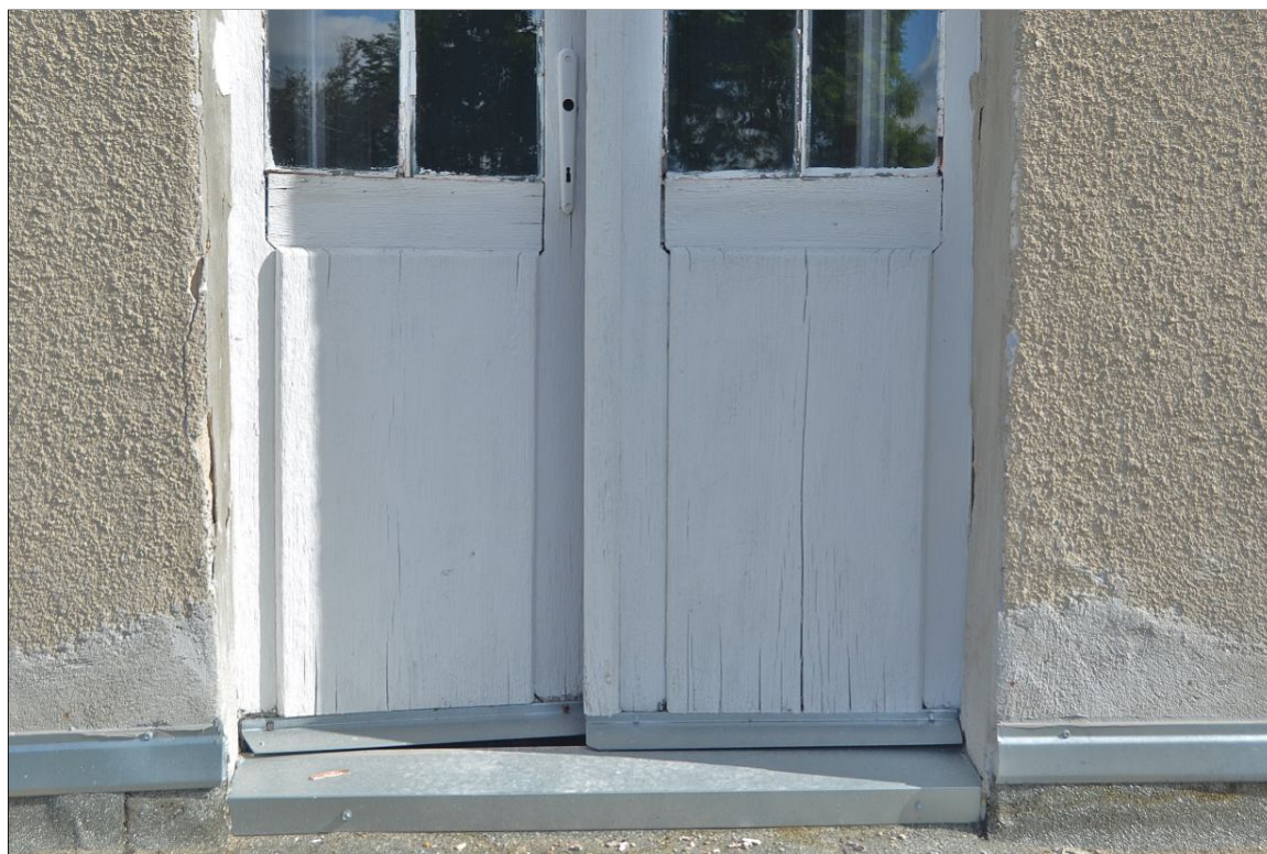
II. 43 Pławin, budynek dawnego dworu
