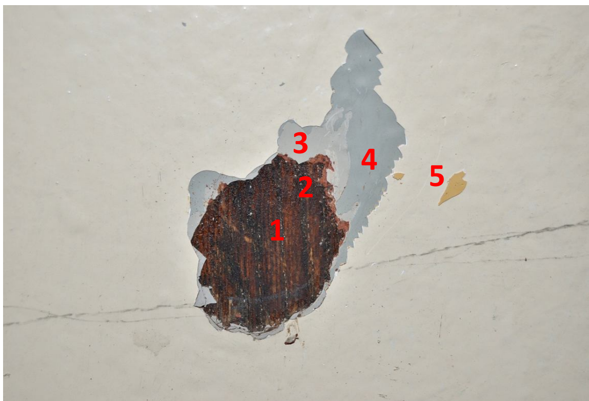
II. 78 Pławin, budynek dawnego dworu
