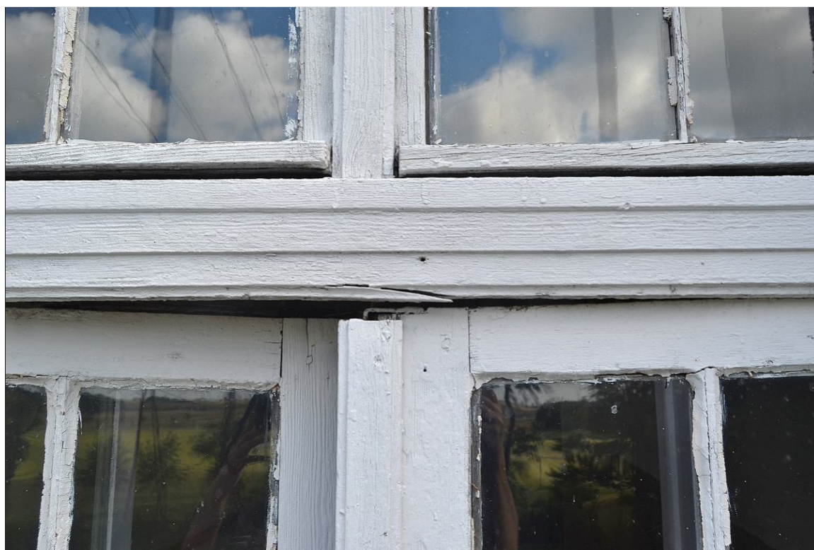
II. 42 Pławin, budynek dawnego dworu
