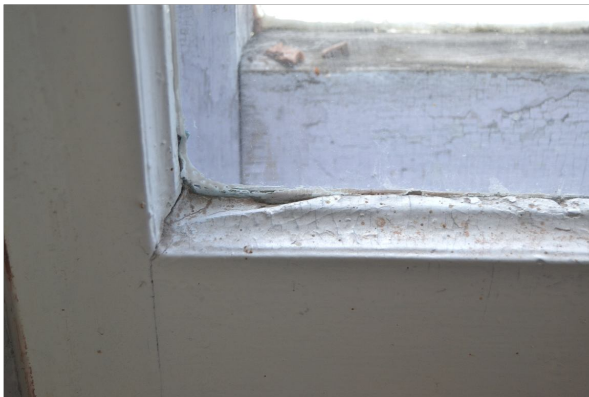
II. 51 Pławin, budynek dawnego dworu
