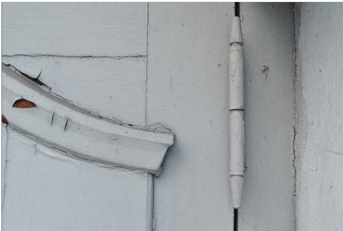
II. 69 Pławin, budynek dawnego dworu
