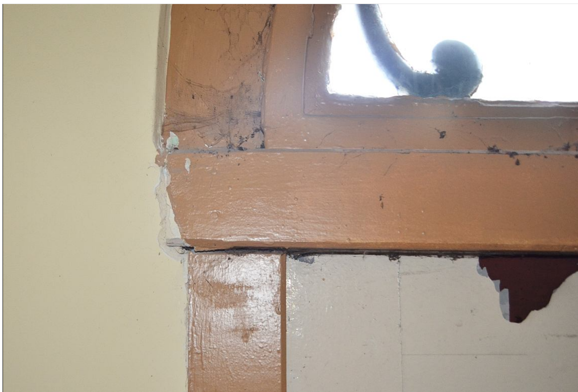
II. 68 Pławin, budynek dawnego dworu
