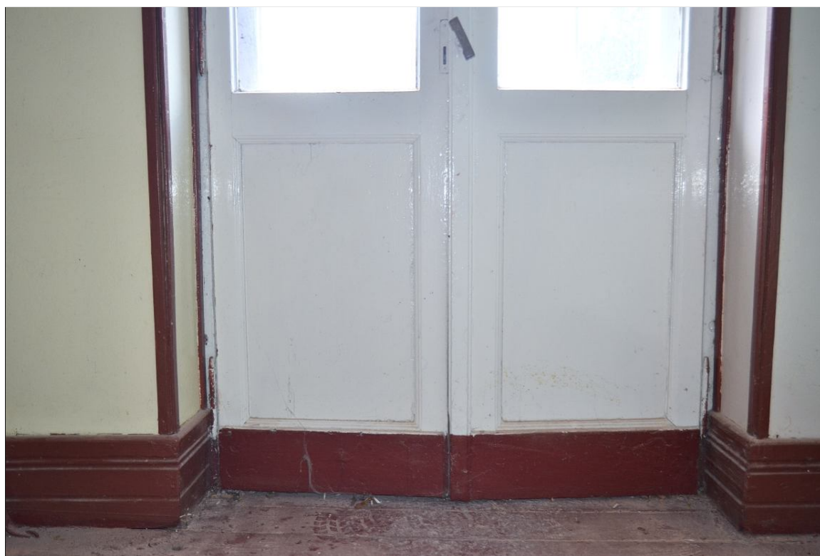
II. 50 Pławin, budynek dawnego dworu
