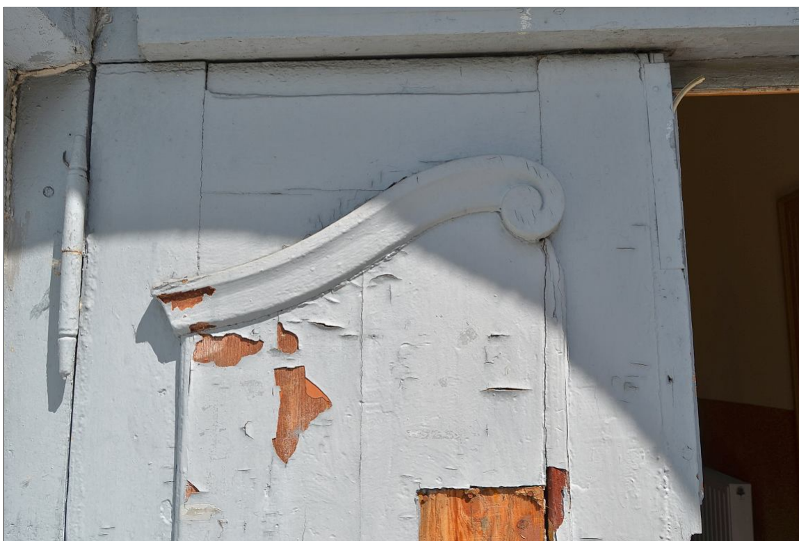
II. 62 Pławin, budynek dawnego dworu
