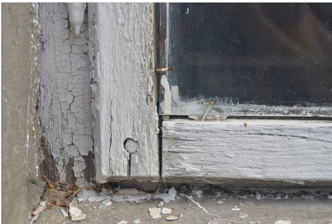
II. 33 Pławin, budynek dawnego dworu
