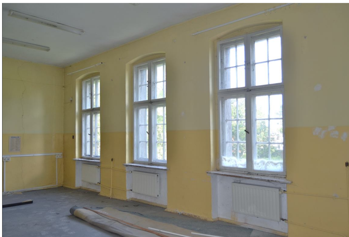
II. 8 Pławin, budynek dawnego dworu, I piętro
