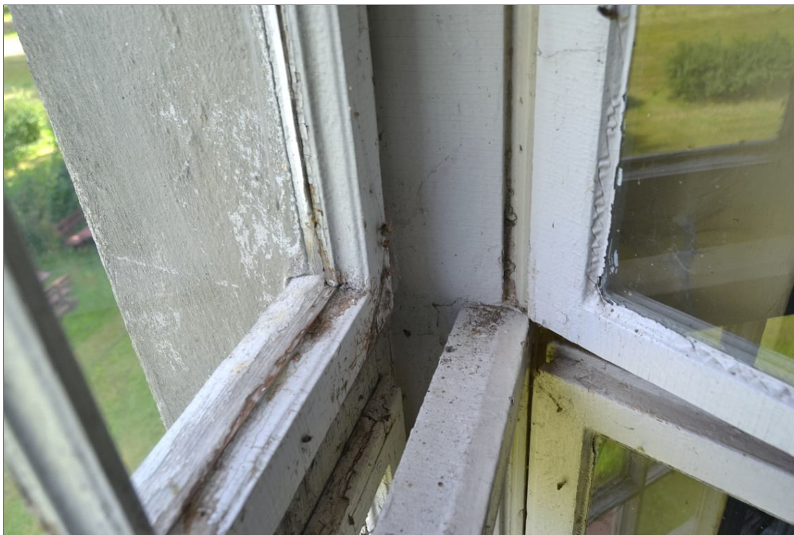
II. 13 Pławin, budynek dawnego dworu
