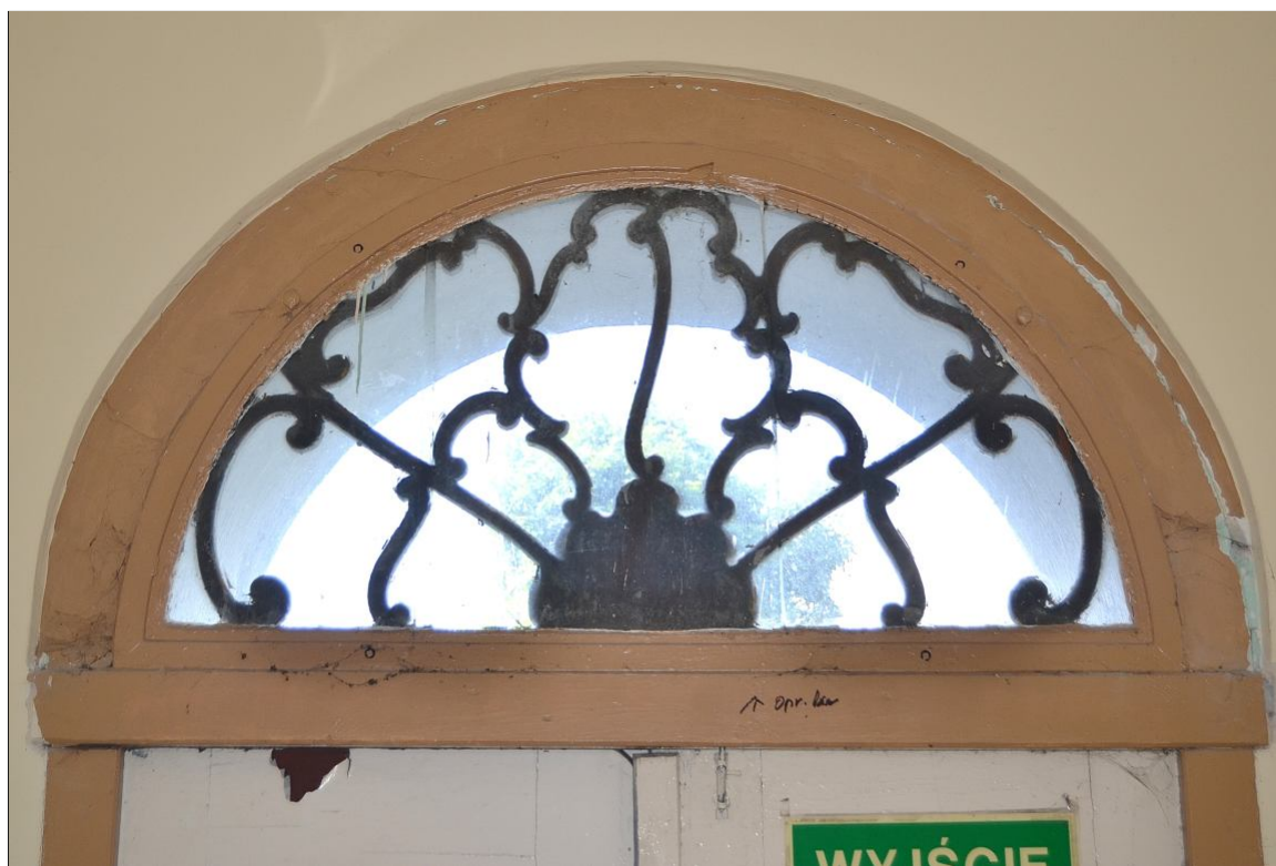
II. 58 Pławin, budynek dawnego dworu
