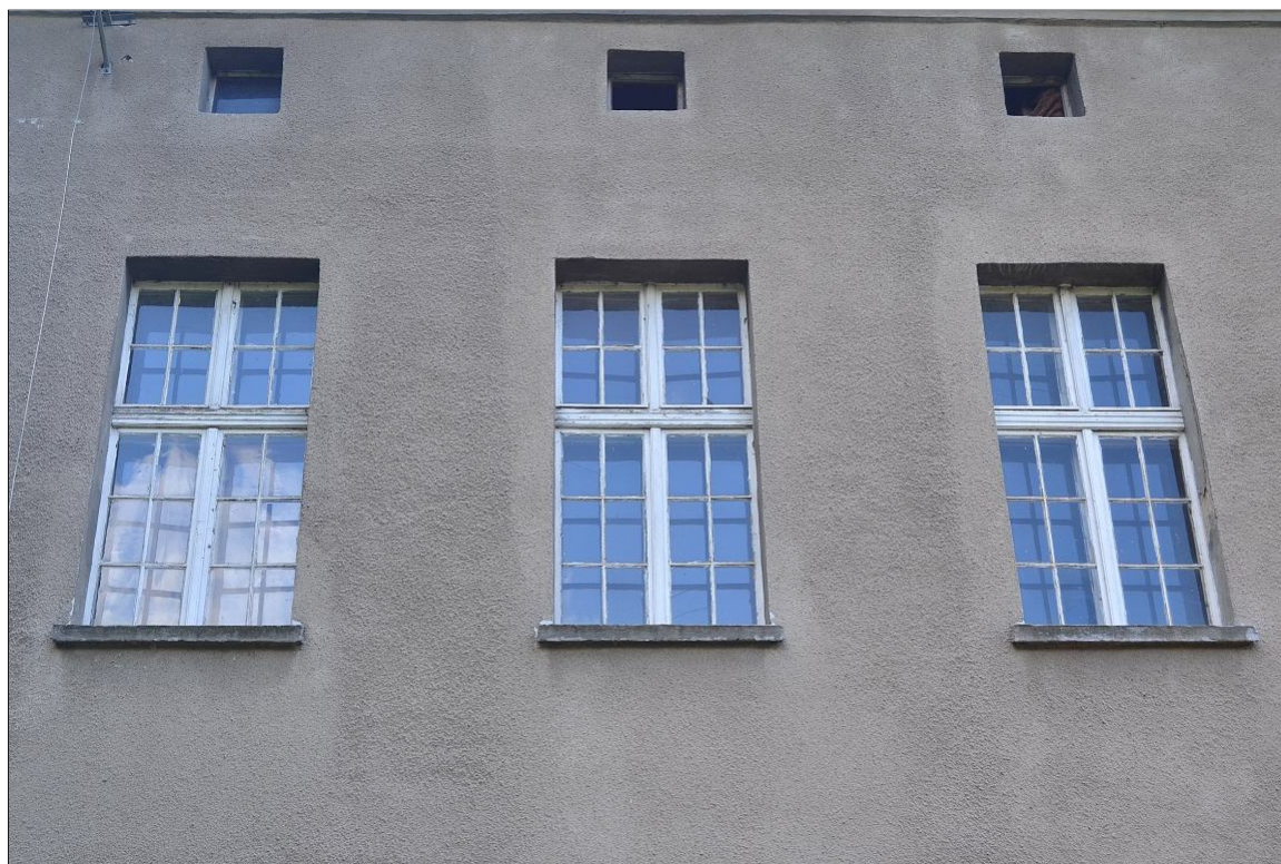
II. 5 Pławin, budynek dawnego dworu, elewacja tylna, I piętro - okno TYP O/II – widok na awers pierwotnej stolarki okiennej
