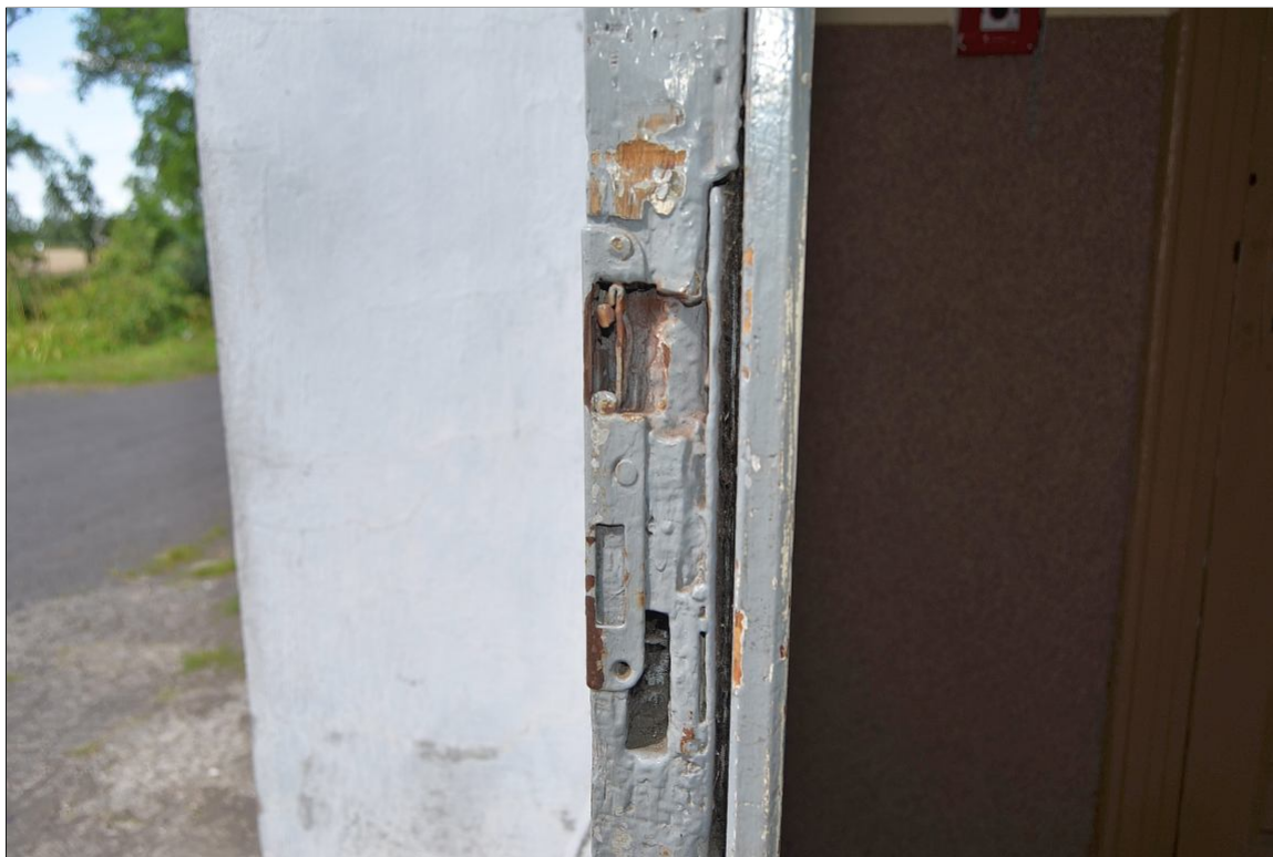
II. 75 Pławin, budynek dawnego dworu
