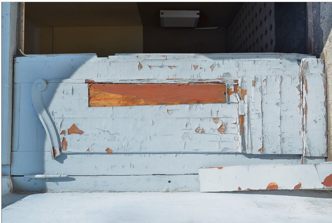
II. 59 Pławin, budynek dawnego dworu
