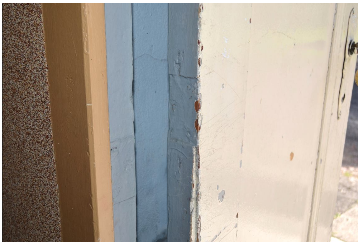
II. 74 Pławin, budynek dawnego dworu
