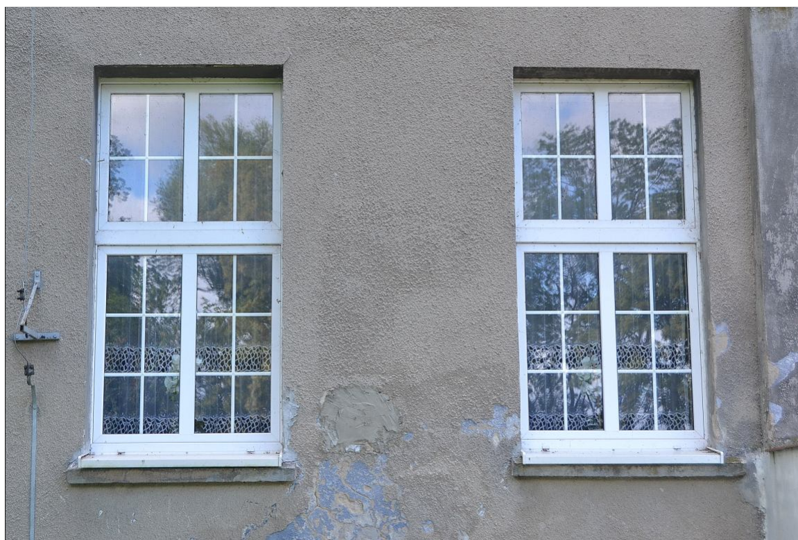
II. 6 Pławin, budynek dawnego dworu, elewacja tylna, parter - okno TYP O/II – widok na awers wtórnej stolarki okiennej jednoramowej
