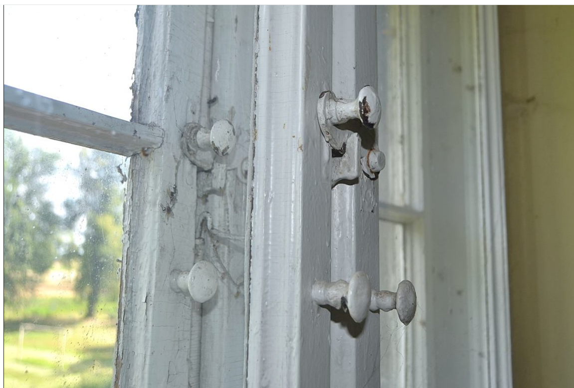
II. 24 Pławin, budynek dawnego dworu
