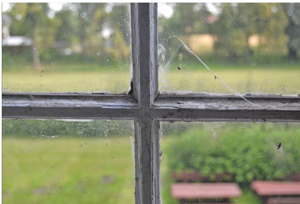
II. 20 Pławin, budynek dawnego dworu
