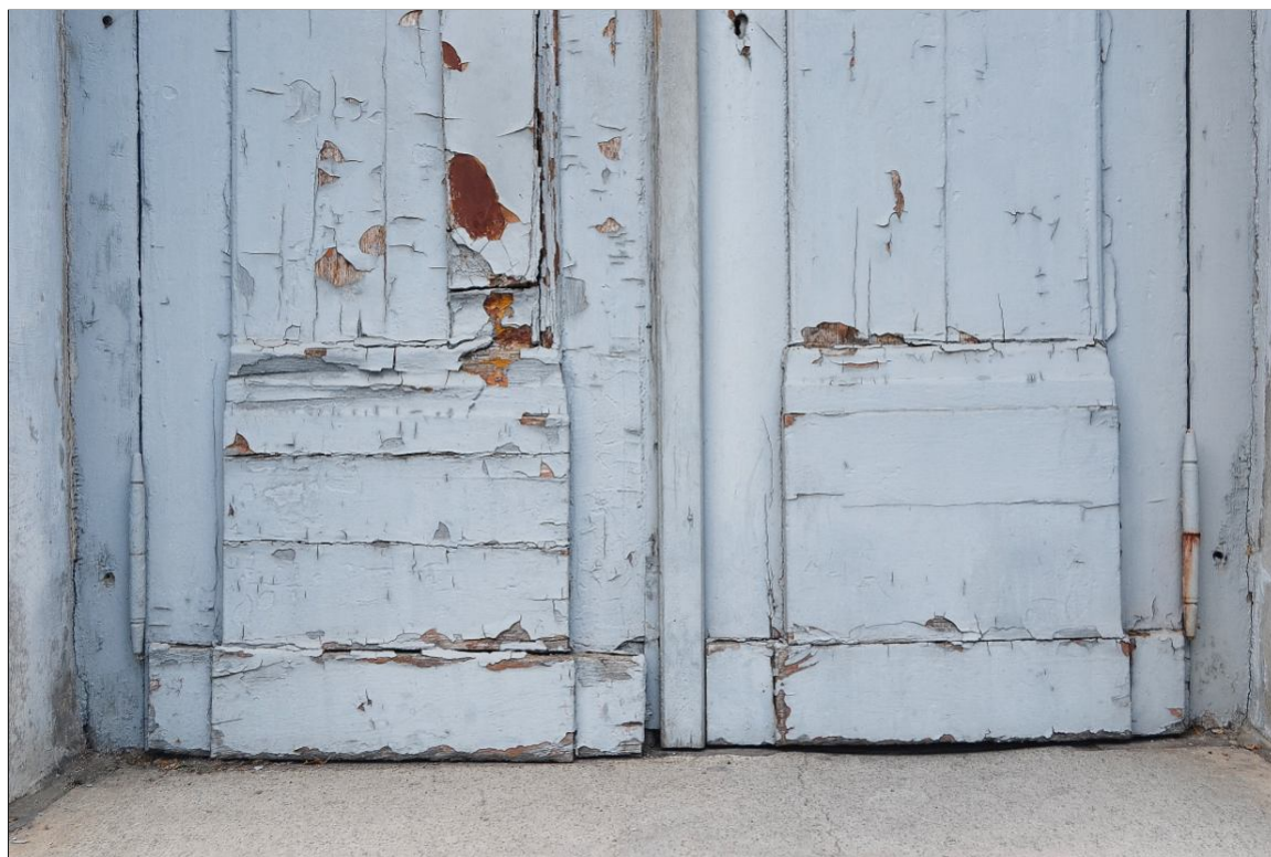
II. 63 Pławin, budynek dawnego dworu
