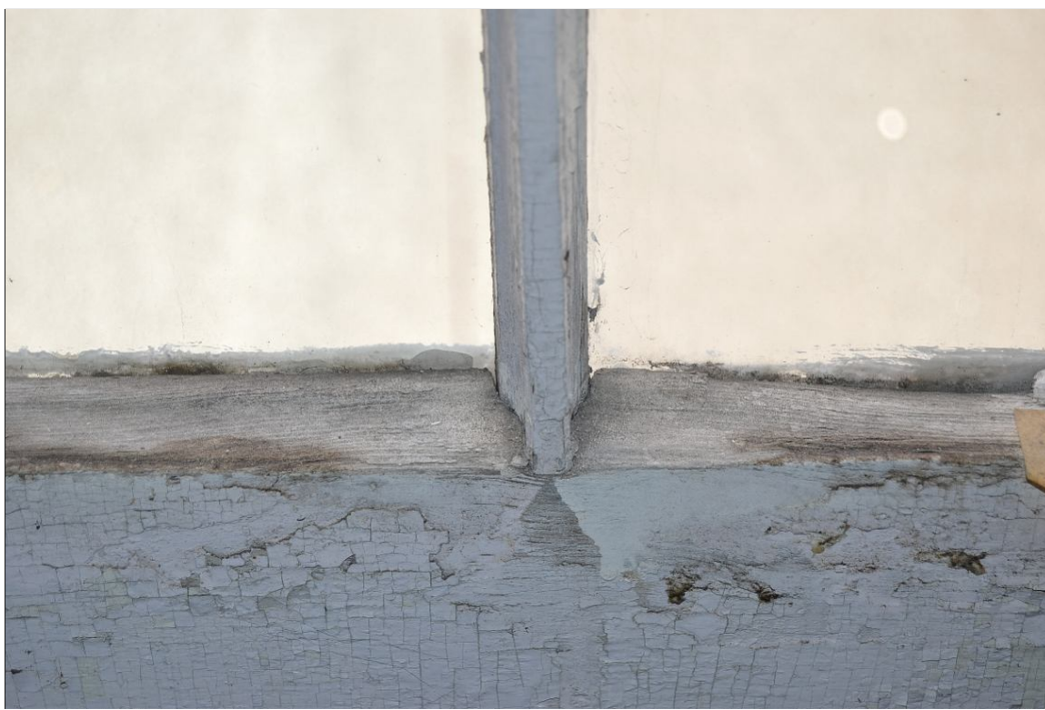
II. 48 Pławin, budynek dawnego dworu
