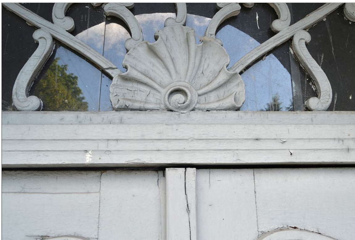
II. 61 Pławin, budynek dawnego dworu
