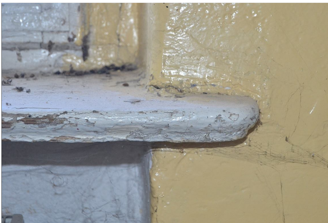
II. 18 Pławin, budynek dawnego dworu
