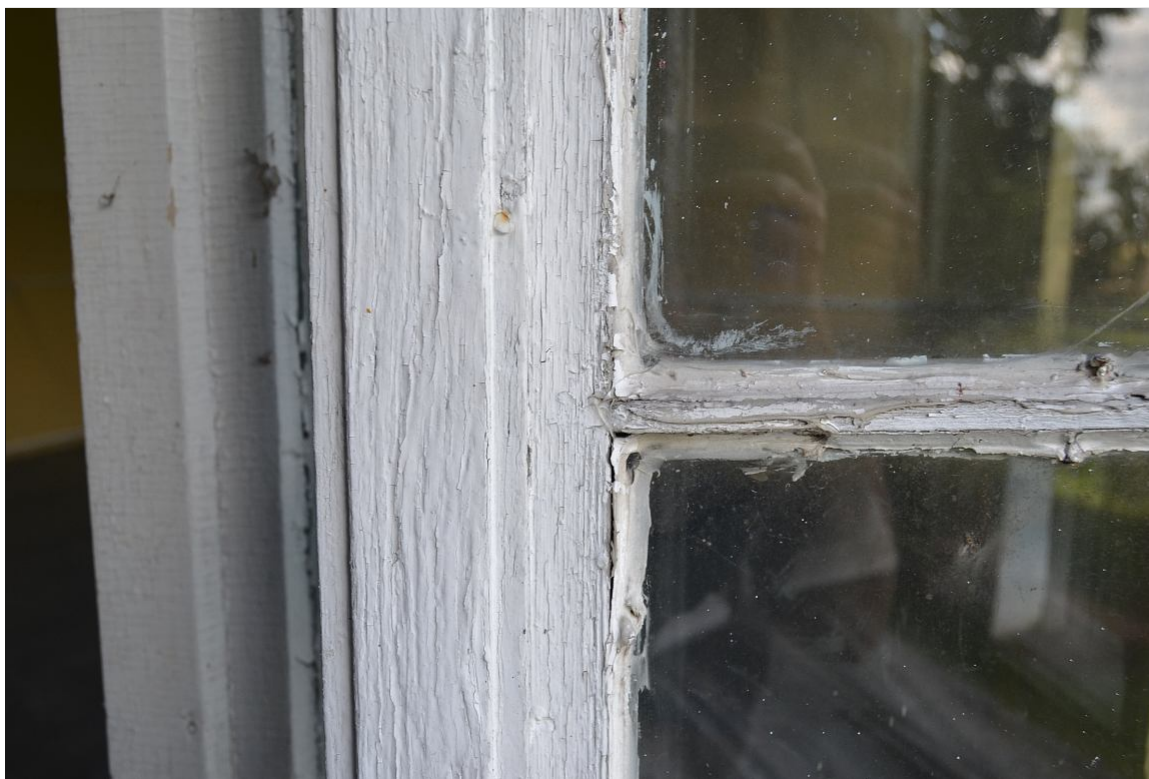
II. 16 Pławin, budynek dawnego dworu
