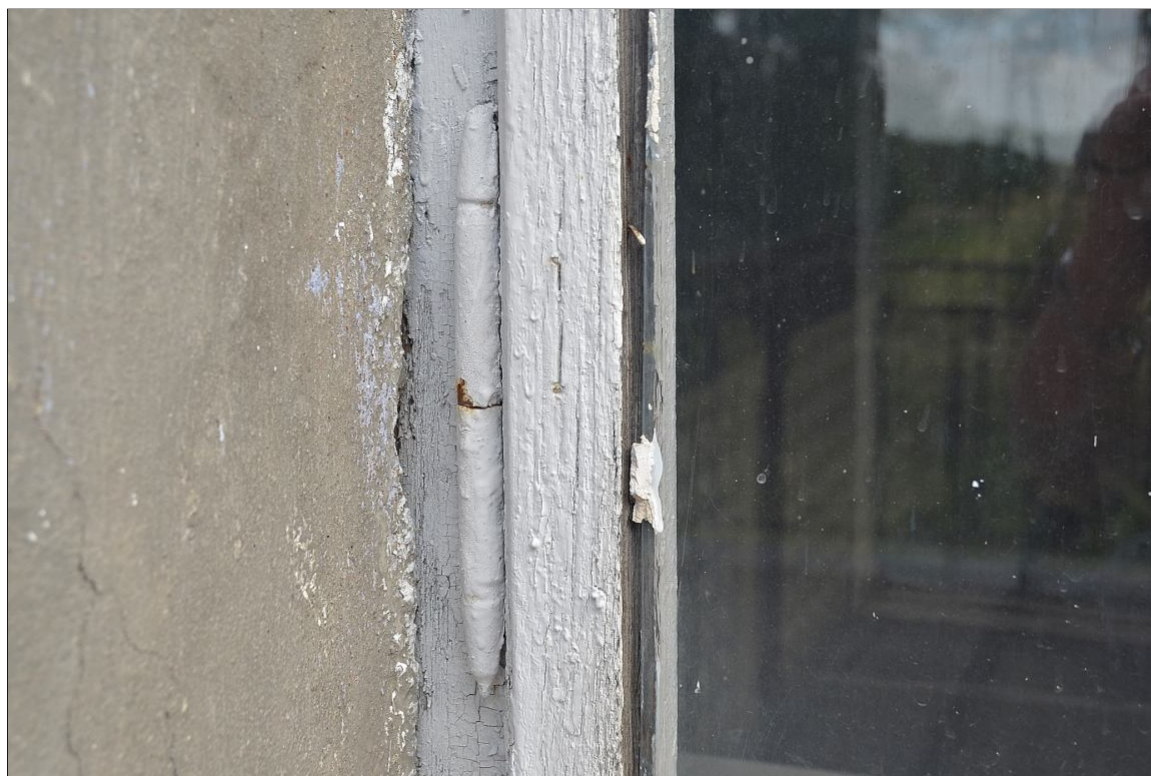
II. 35 Pławin, budynek dawnego dworu
