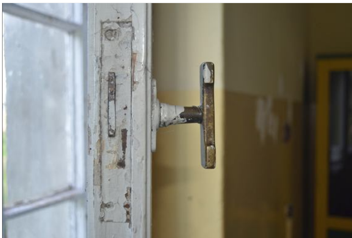
II. 26 Pławin, budynek dawnego dworu
