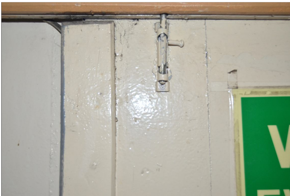
II. 77 Pławin, budynek dawnego dworu
