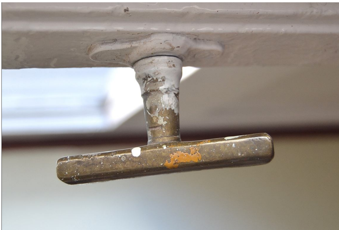
II. 54 Pławin, budynek dawnego dworu
