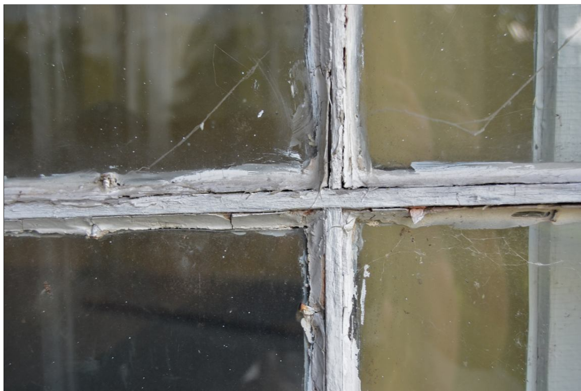
II. 19 Pławin, budynek dawnego dworu
