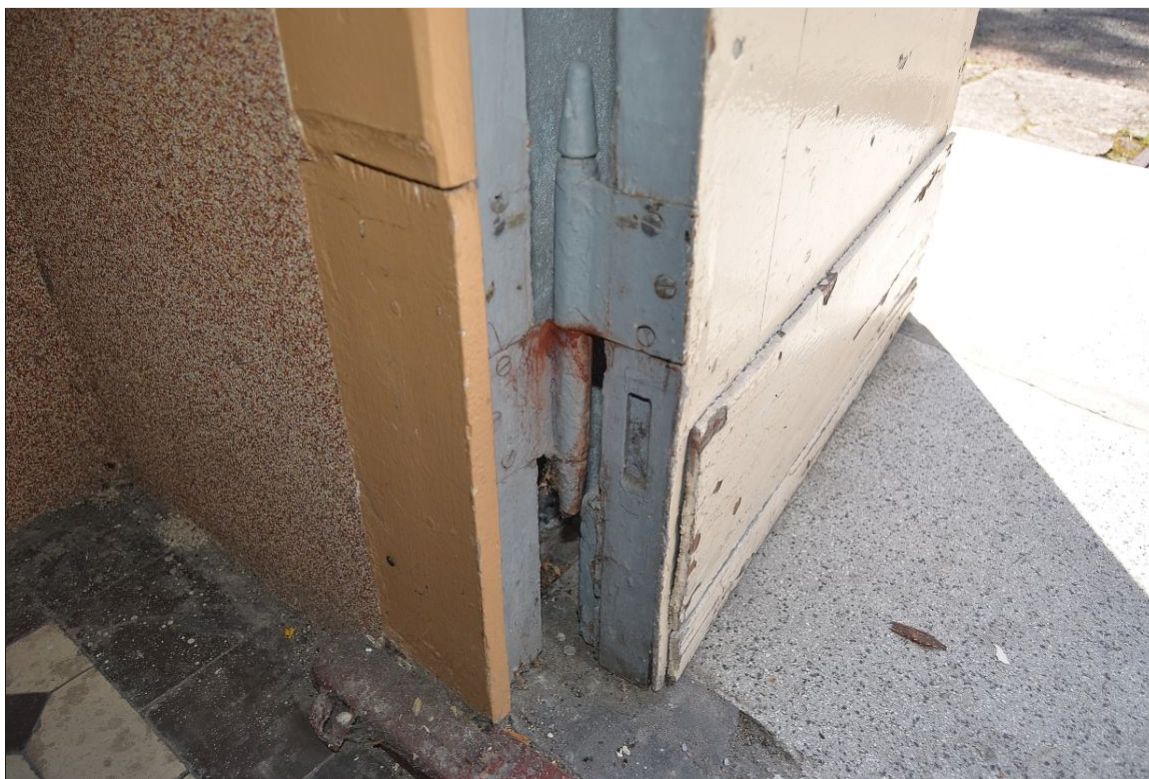
II. 70 Pławin, budynek dawnego dworu
