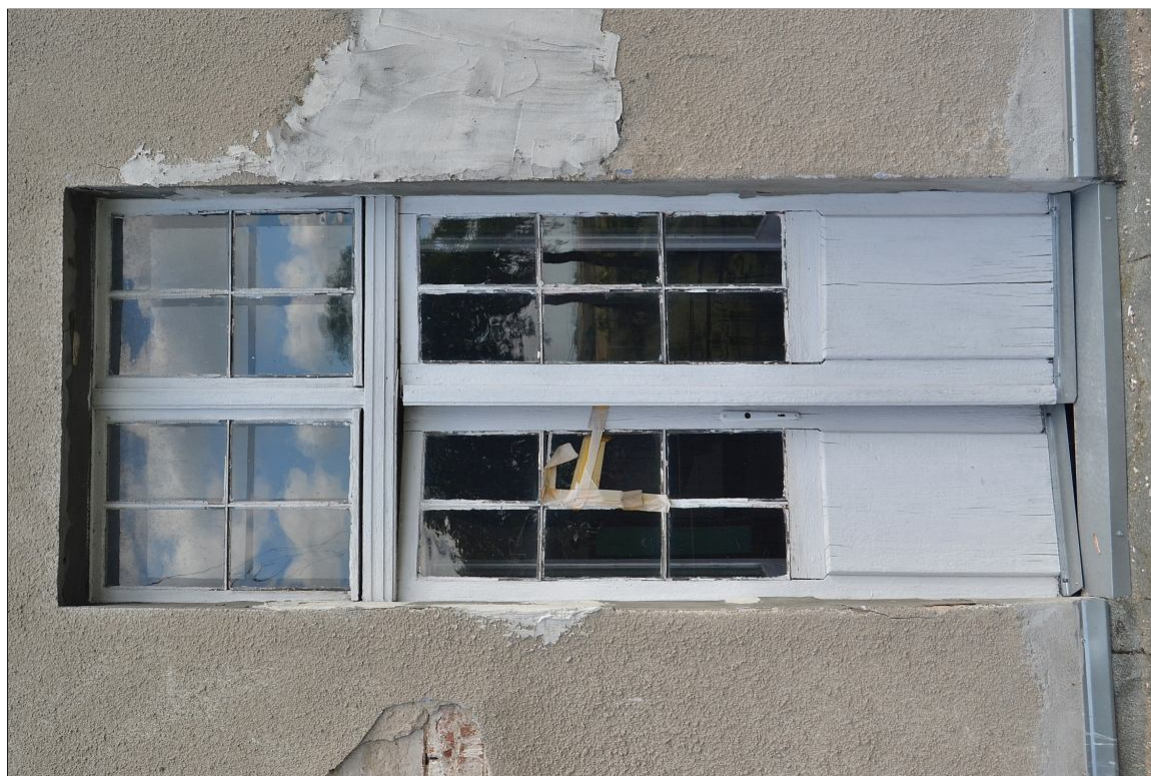
II. 37 Pławin, budynek dawnego dworu
