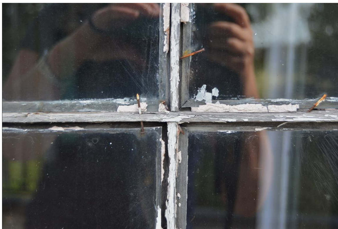
II. 46 Pławin, budynek dawnego dworu
