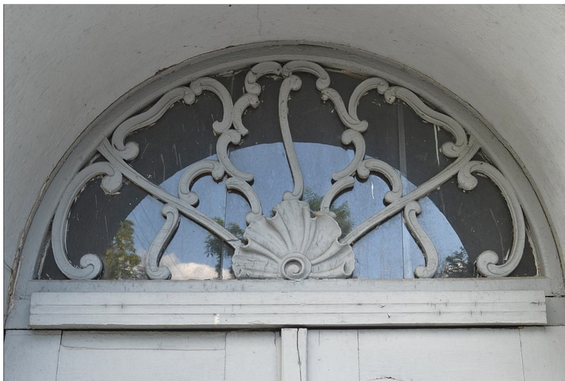
II. 57 Pławin, budynek dawnego dworu
