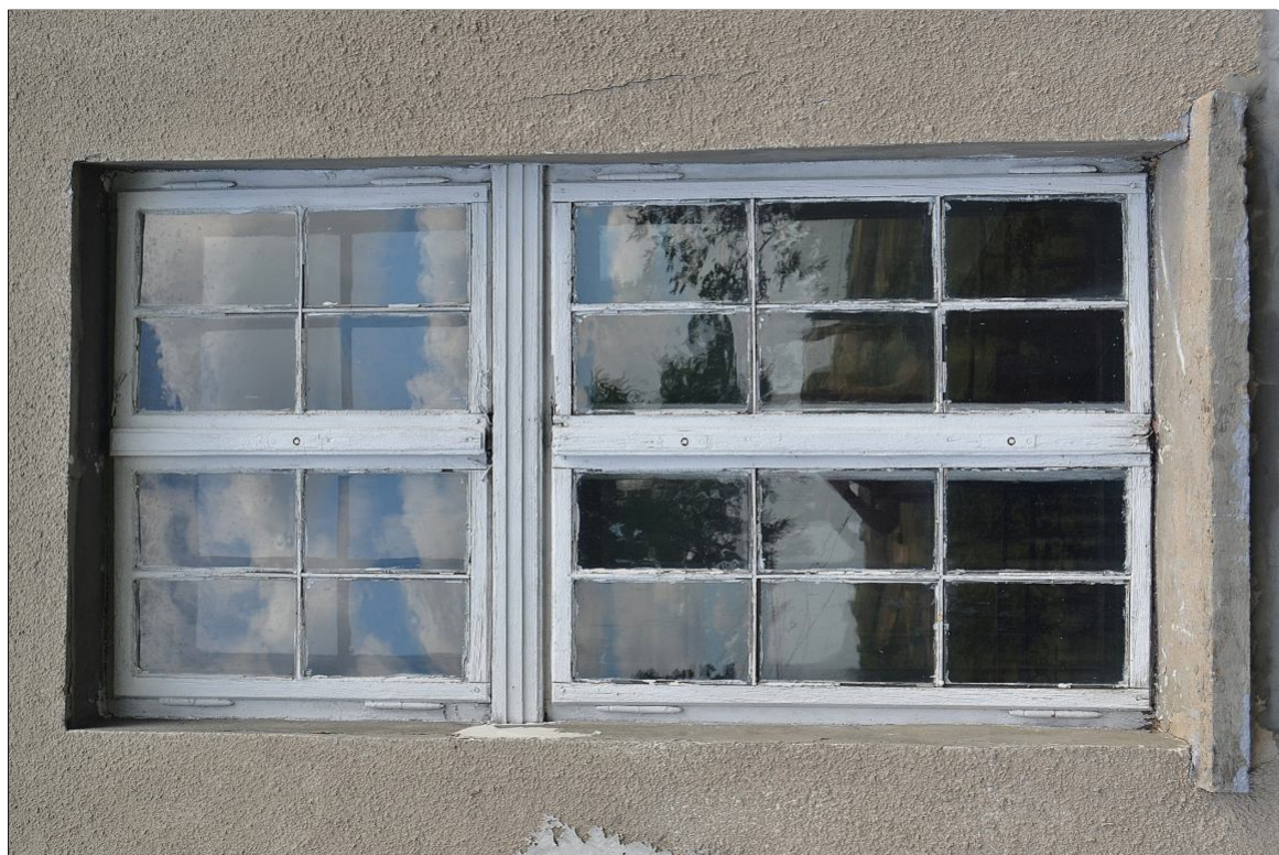
II. 27 Pławin, budynek dawnego dworu - okno TYP O/III – pierwotna stolarka okienna, awers
