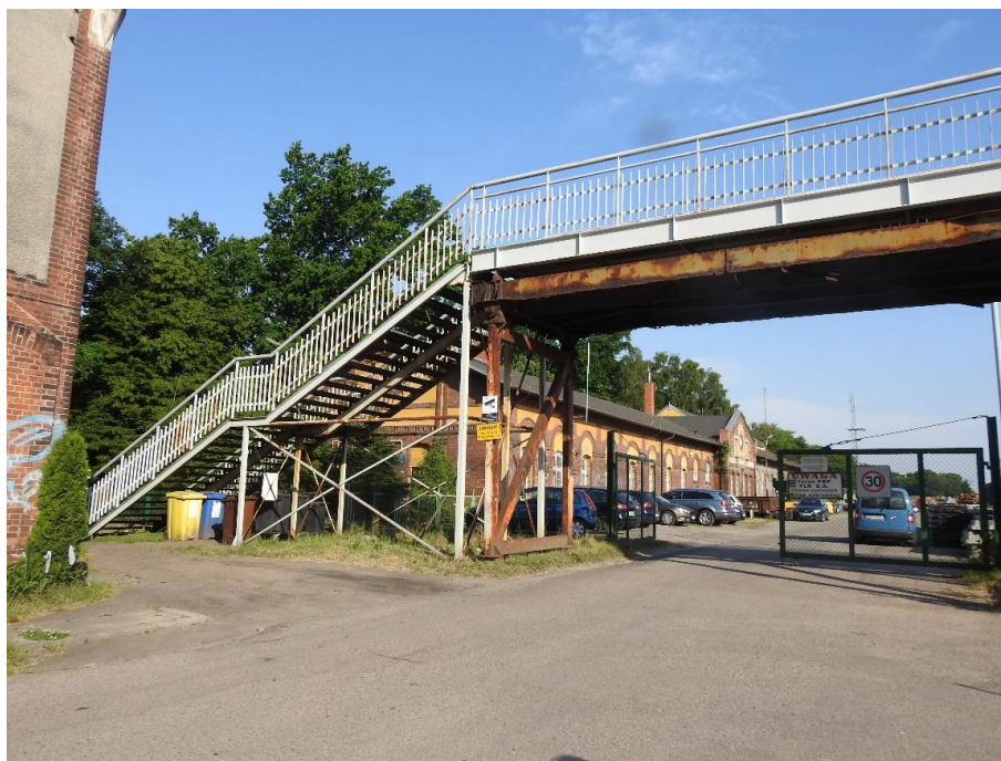
Fot. 2.2 Widok ogólny na konstrukcję kładki
