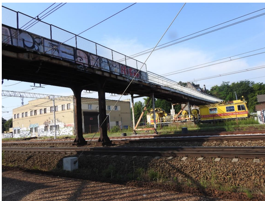
Fot. 2.4 Widok ogólny na konstrukcję kładki
