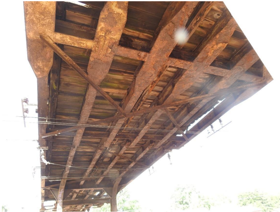
Fot. 2.5 Widok ogólny od spodu na konstrukcję kładki
