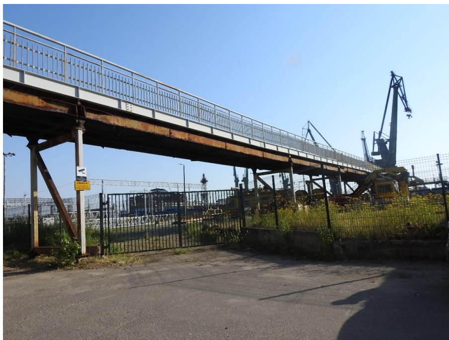
Fot. 1.3 Widok ogólny na konstrukcję kładki
