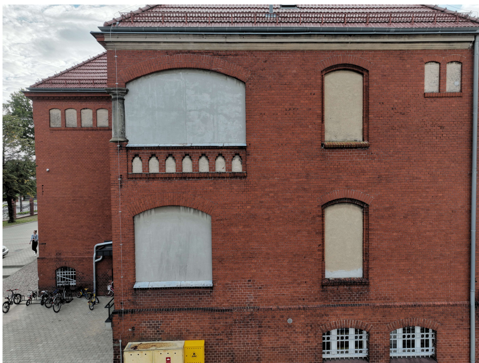
Zdj. 3 – widok na boczną elewację budynku- widoczne zabrudzenia na elewacji, występowanie ubytków w cegle, filar dekoracyjny wymagający oczyszczenia
