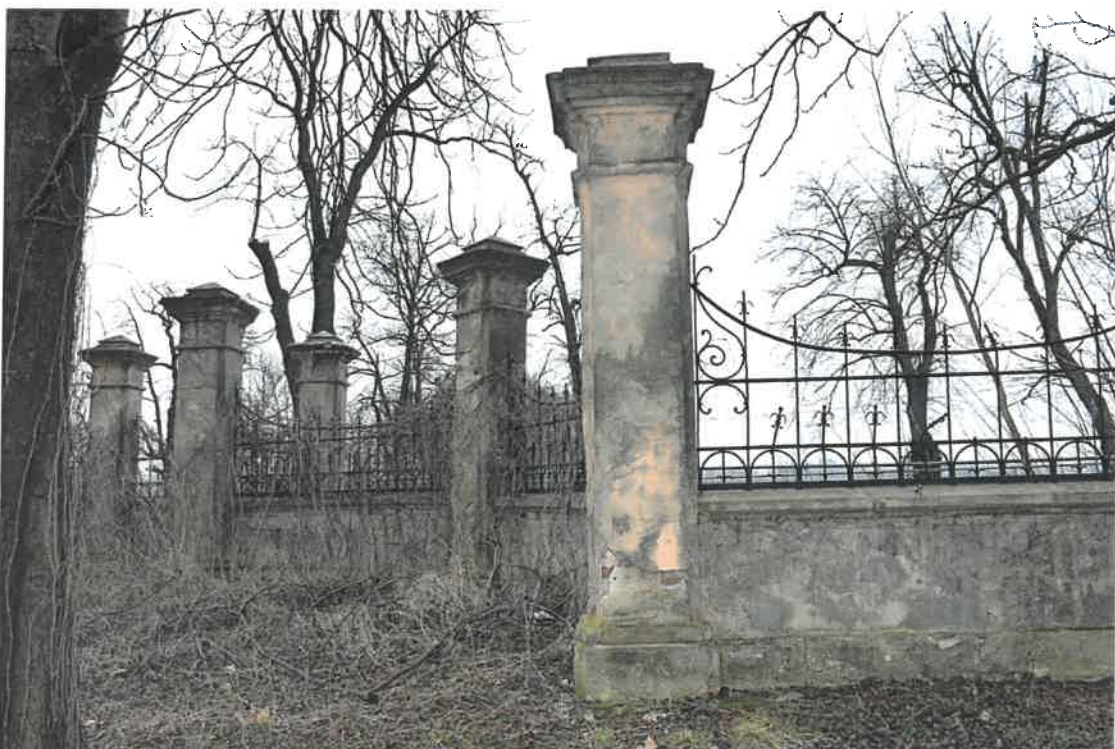
20. Reprezentacyjna brama wjazdowa prowadząca na teren barokowego ogrodu z 1890r. w BRNIU Stan przed remontem 2021 r. Zbliżenie słupów ogrodzenia z lewej strony, od strony północnej. Widoczne ubytki, złuszczenia tynków, przebarwienia, wypłukania przez wodę deszczową, roślinność na metalowym ogrodzeniu, glony.
