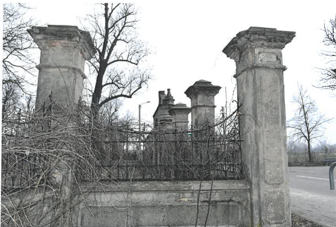
15. Reprezentacyjna brama wjazdowa prowadząca na teren barokowego ogrodu z 1890r. w BRNIU Stan przed remontem 2021 r. Zbliżenie słupów ogrodzenia z lewej strony od strony południowej. Widoczne ubytki, złuszczenia tynków, przebarwienia, wypłukania przez wodę deszczową, roślinność na metalowym ogrodzeniu.
