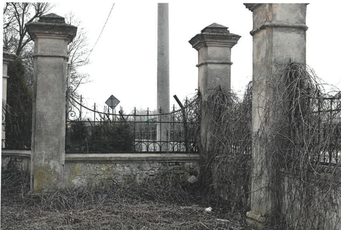
19. Reprezentacyjna brama wjazdowa prowadząca na teren barokowego ogrodu z 1890r. w BRNIU Stan przed remontem 2021 r. Zbliżenie słupów ogrodzenia z prawej strony, od strony północnej. Widoczne ubytki, złuszczenia tynków, przebarwienia, wypłukania przez wodę deszczową, roślinność na metalowym ogrodzeniu, glony.
