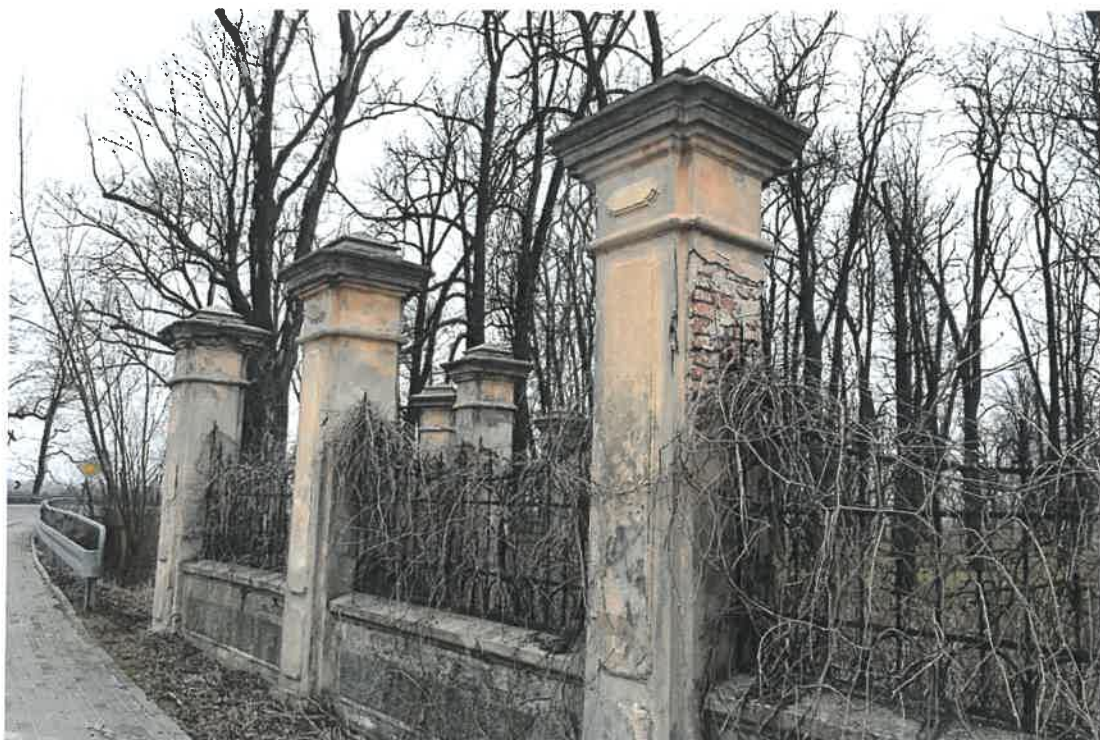
13. Reprezentacyjna brama wjazdowa prowadząca na teren barokowego ogrodu z 1890r. w BRNIU Stan przed remontem 2021 r. Zbliżenie słupów ogrodzenia z lewej strony od strony południowej. Widoczne ubytki, złuszczenia tynków, przebarwienia, wypłukania przez wodę deszczową, roślinność na metalowym ogrodzeniu.
