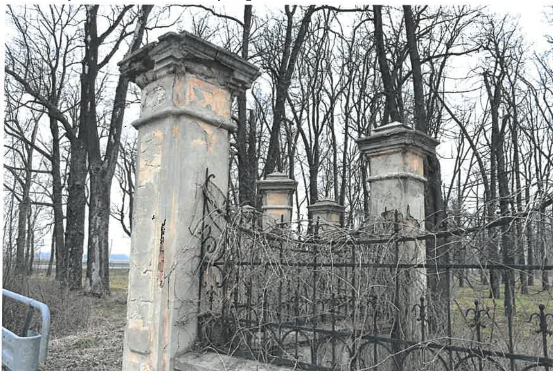
14. Reprezentacyjna brama wjazdowa prowadząca na teren barokowego ogrodu z 1890r. w BRNIU Stan przed remontem 2021 r. Zbliżenie słupów ogrodzenia z lewej strony od strony południowej. Widoczne ubytki, złuszczenia tynków, przebarwienia, wypłukania przez wodę deszczową, roślinność na metalowym ogrodzeniu.
