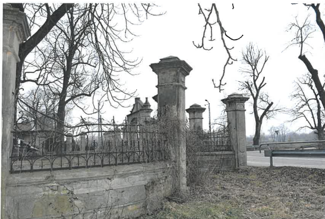
16. Reprezentacyjna brama wjazdowa prowadząca na teren barokowego ogrodu z 1890r. w BRNIU Stan przed remontem 2021 r. Zbliżenie słupów ogrodzenia z lewej strony od strony południowej. Widoczne ubytki, złuszczenia tynków, przebarwienia, wypłukania przez wodę deszczową, roślinność na metalowym ogrodzeniu.
