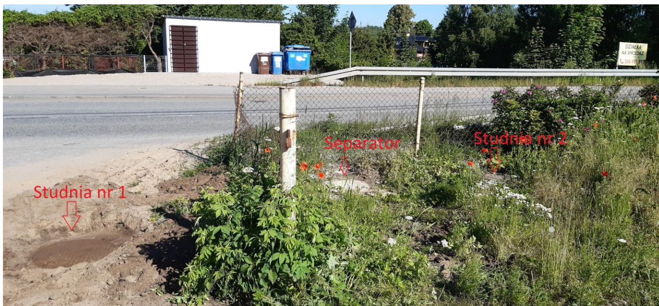
Lokalizacja urządzeń do czyszczenia DW 221 m. Jodłowno
