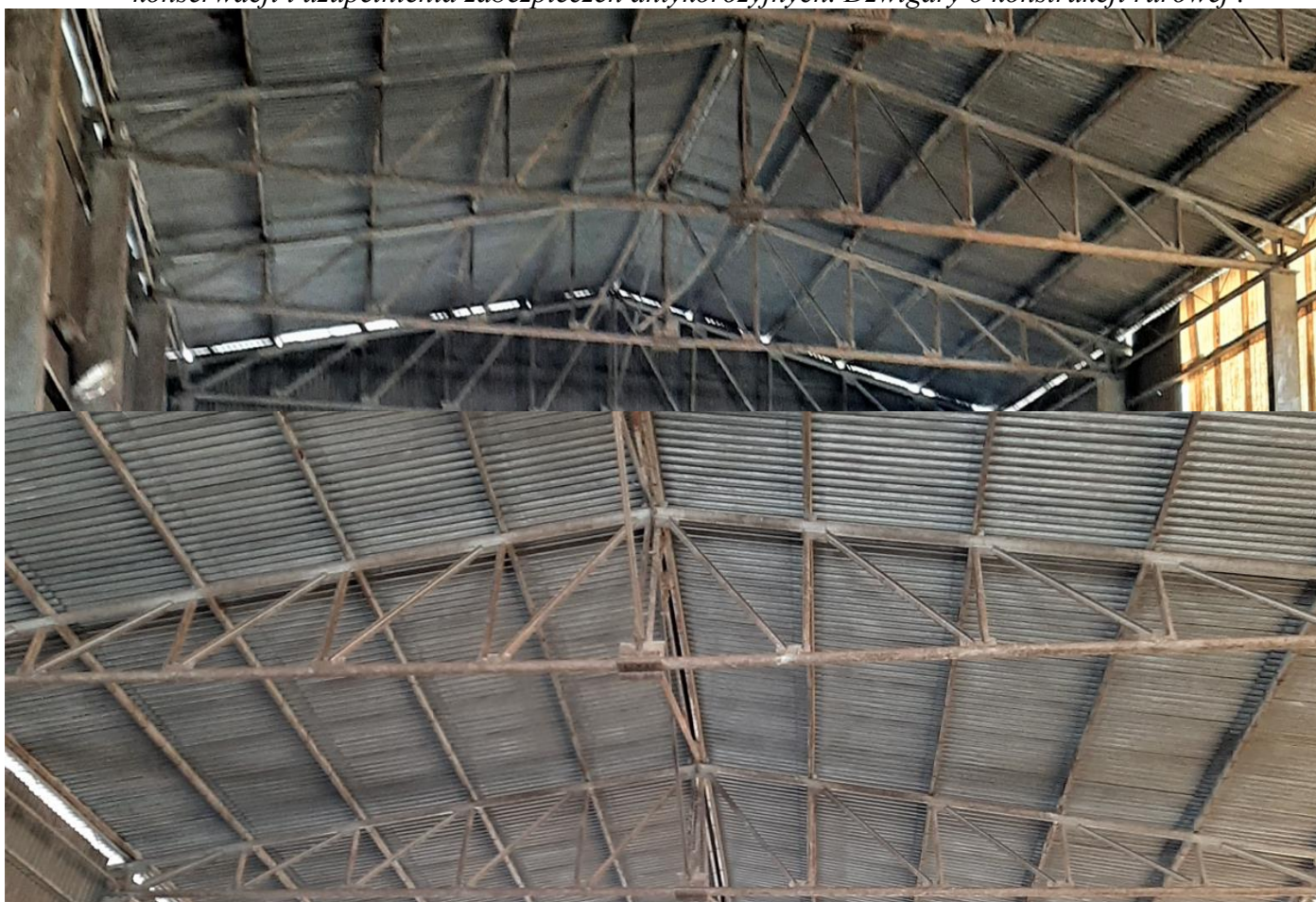
F . Widok konstrukcji i pokrycia dachu
