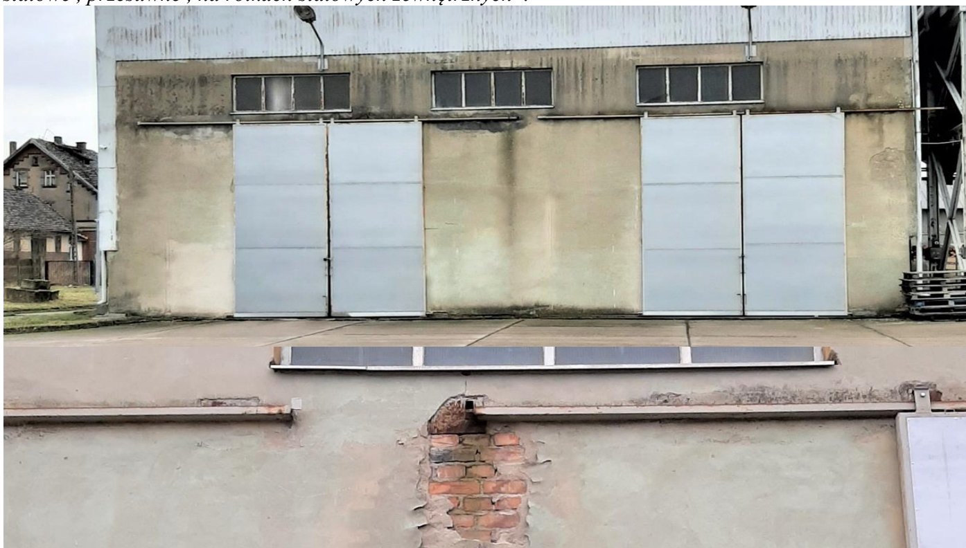
C. Widok ścian murowanych oraz stolarki stalowej ścian szczytowych
