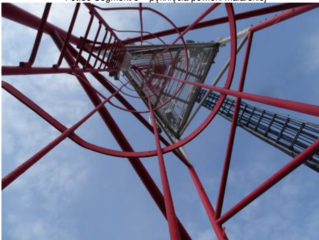
Fot.36 Segment 3 – drabina komunikacyjna
