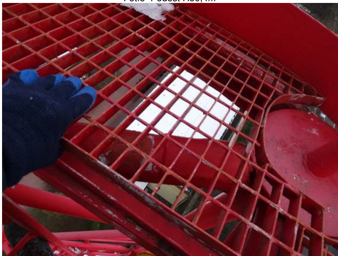
Fot.6 Podest H50,4m – brak zamocowania kraty
