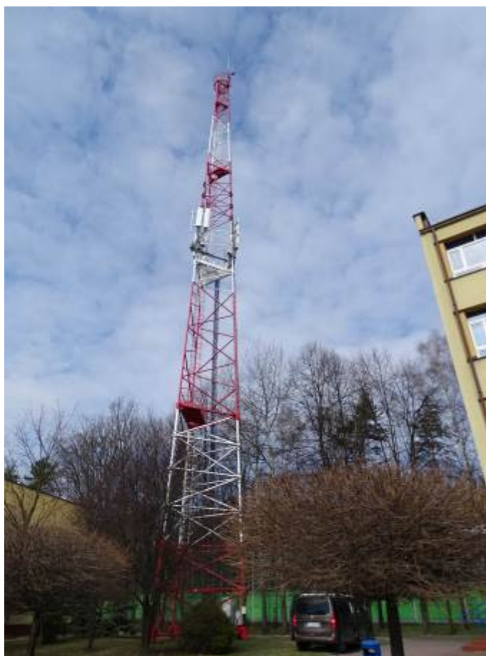
Fot.1 Widok ogólny
