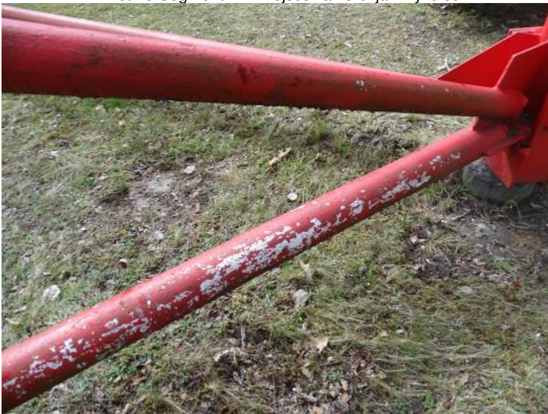
Fot.44 Segment 4 – łuszczenie powłoki malarskiej skratowań
