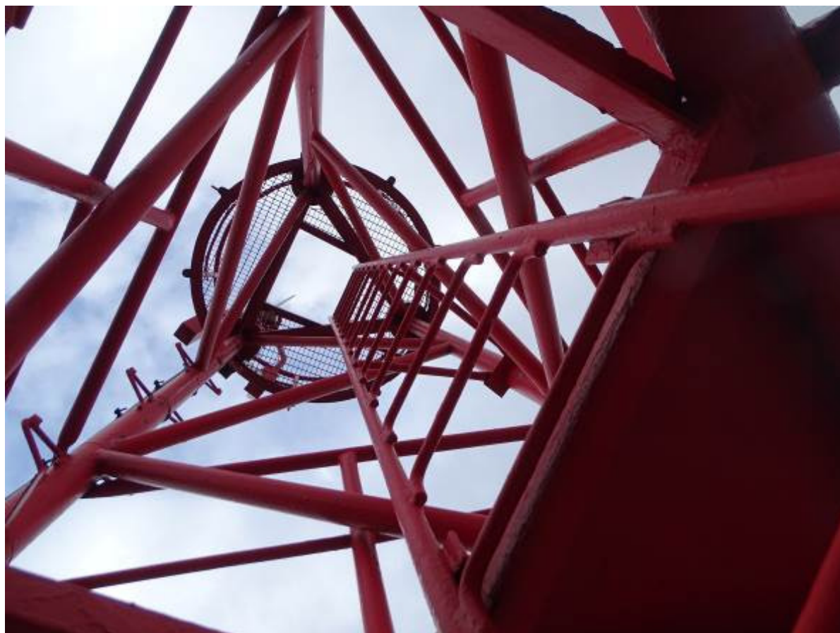
Fot.13 Segment 1 – drabina komunikacyjna
