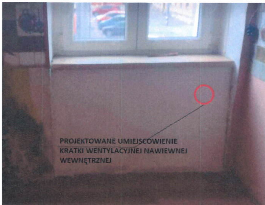
Fot. 1 Projektowane umiejscowienie nawiewu - kuchnia
