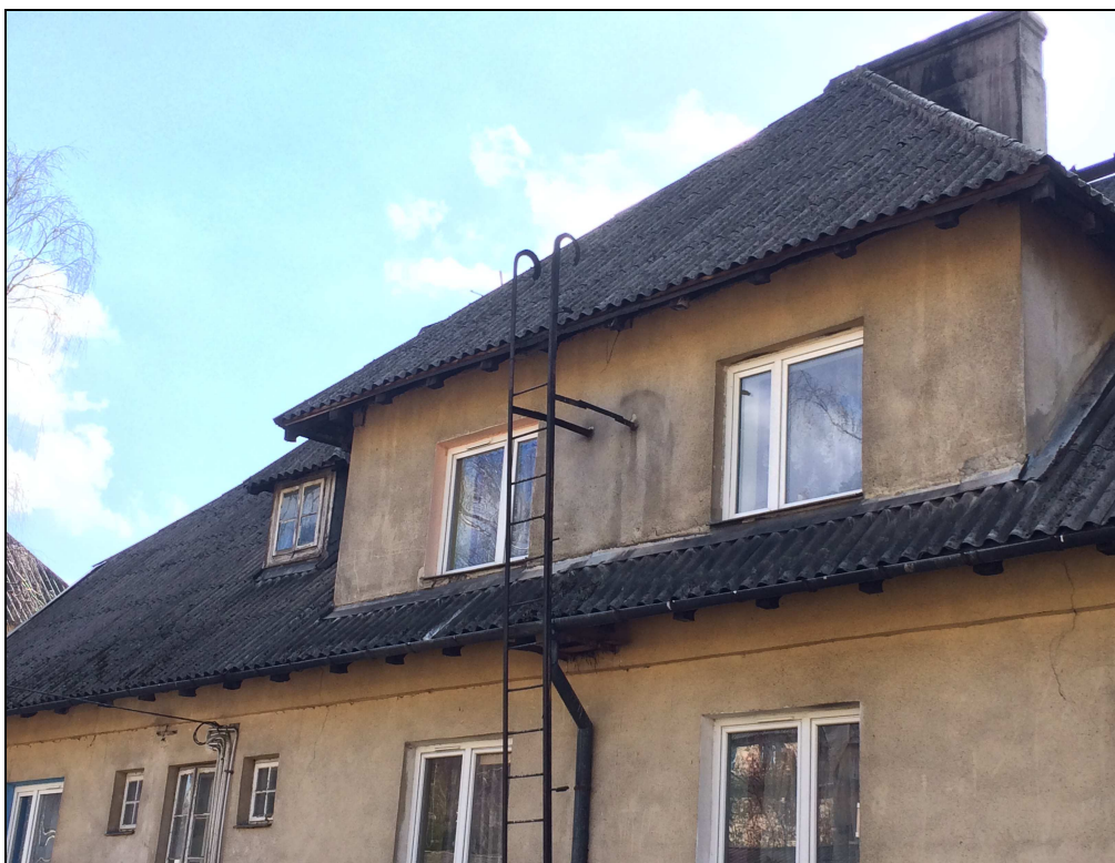
6. LUKARNA OD STRONY PÓŁNOCNEJ BUDYNKU
