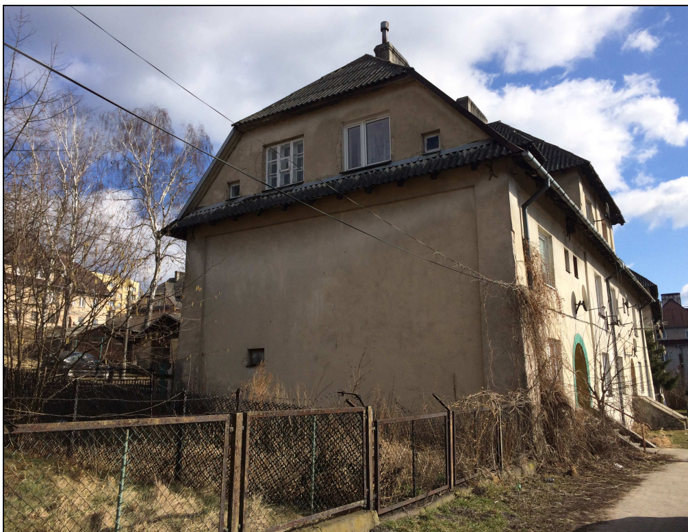
3. ELEWACJA BUDYNKU WIELORODZINNEGO PRZY UL. WIDOK 10 - OD STRONY ZACHODNIEJ
