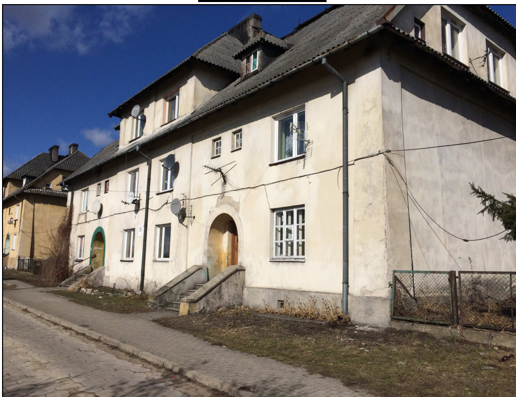
1. ELEWACJA BUDYNKU WIELORODZINNEGO PRZY UL. WIDOK 10 - OD STRONY POŁUDNIOWEJ
