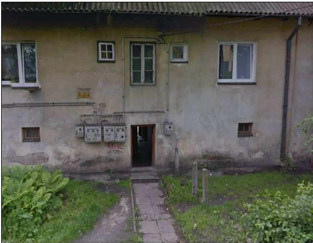
7. JEDNO Z WEJŚĆ (OD STRONY PÓŁNOCNEJ) DO KLATKI SCHODOWEJ
