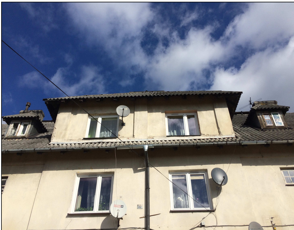
5. LUKARNA OD STRONY POŁUDNIOWEJ BUDYNKU
