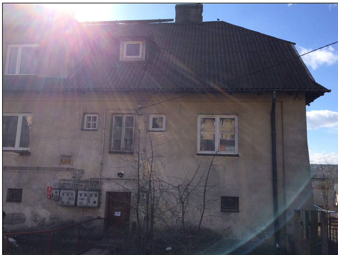
10. FRAGMENT ELEWACJI PÓŁNOCNEJ BUDYNKU
