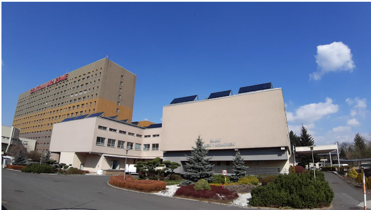
Fot. 1. Widok na budynek "J".
