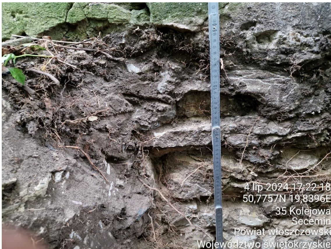
Fot. 5. Odkrywka nr 1. – pomiar głębokości posadowienia budynku Motorowni – 65 cm.
