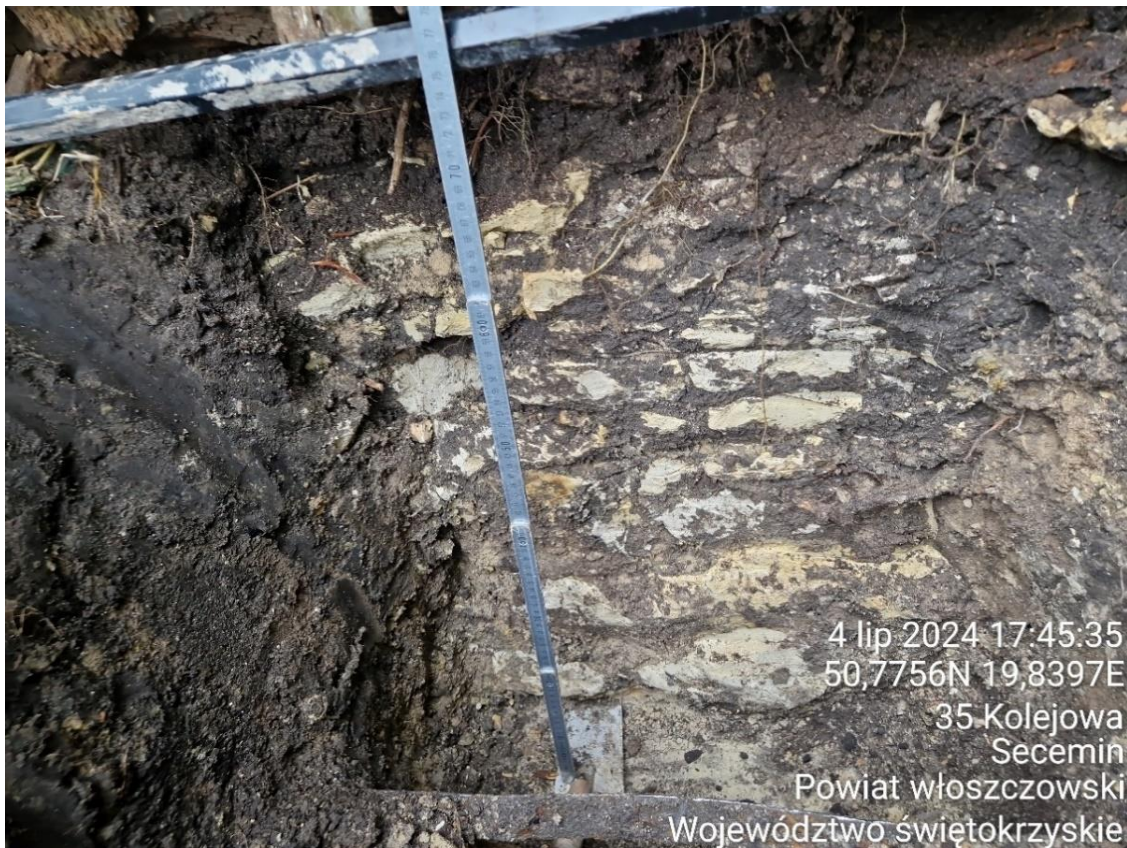
Fot. 6. Odkrywka nr 2. – pomiar głębokości posadowienia budynku Młyna – 75 cm.
