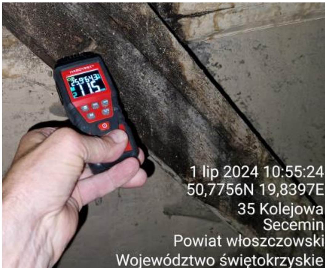
Fot.2. Pomiar wilgotności elementów konstrukcyjnych miernikiem wilgotności.
