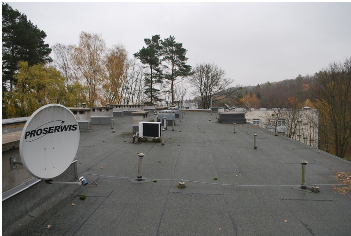
Widok w kierunku wschodnim.
