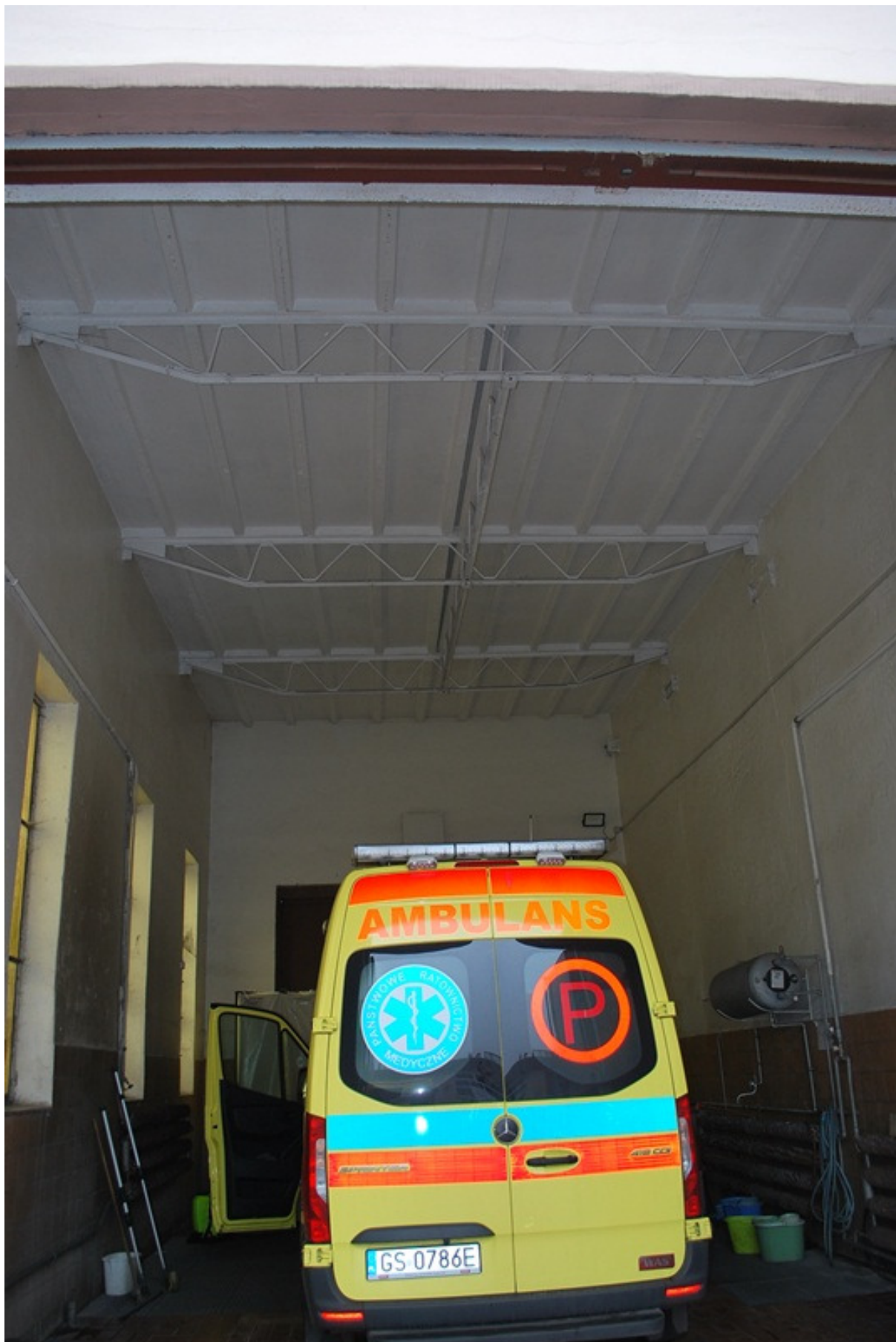
Widok konstrukcji dachu.
