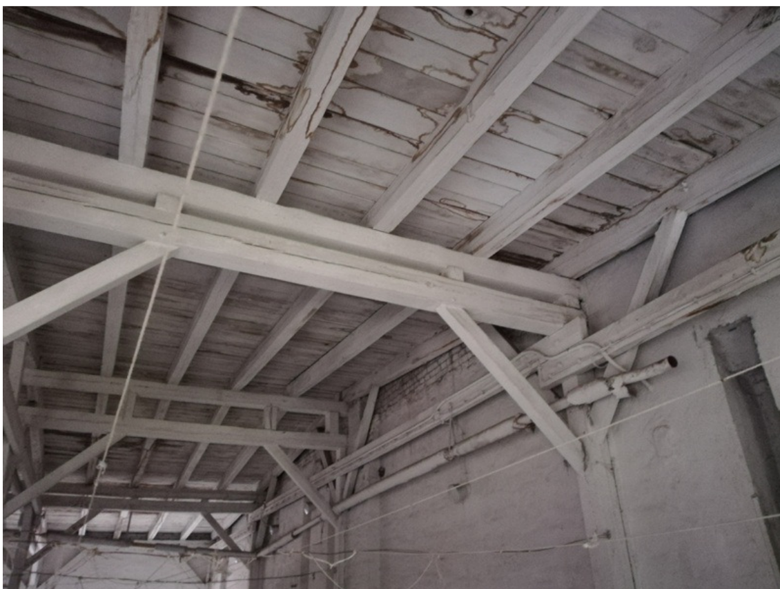
Widok konstrukcji dachu
