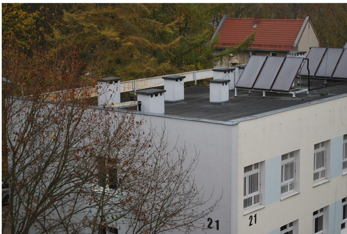
Widok z budynku nr 20 c.d.
