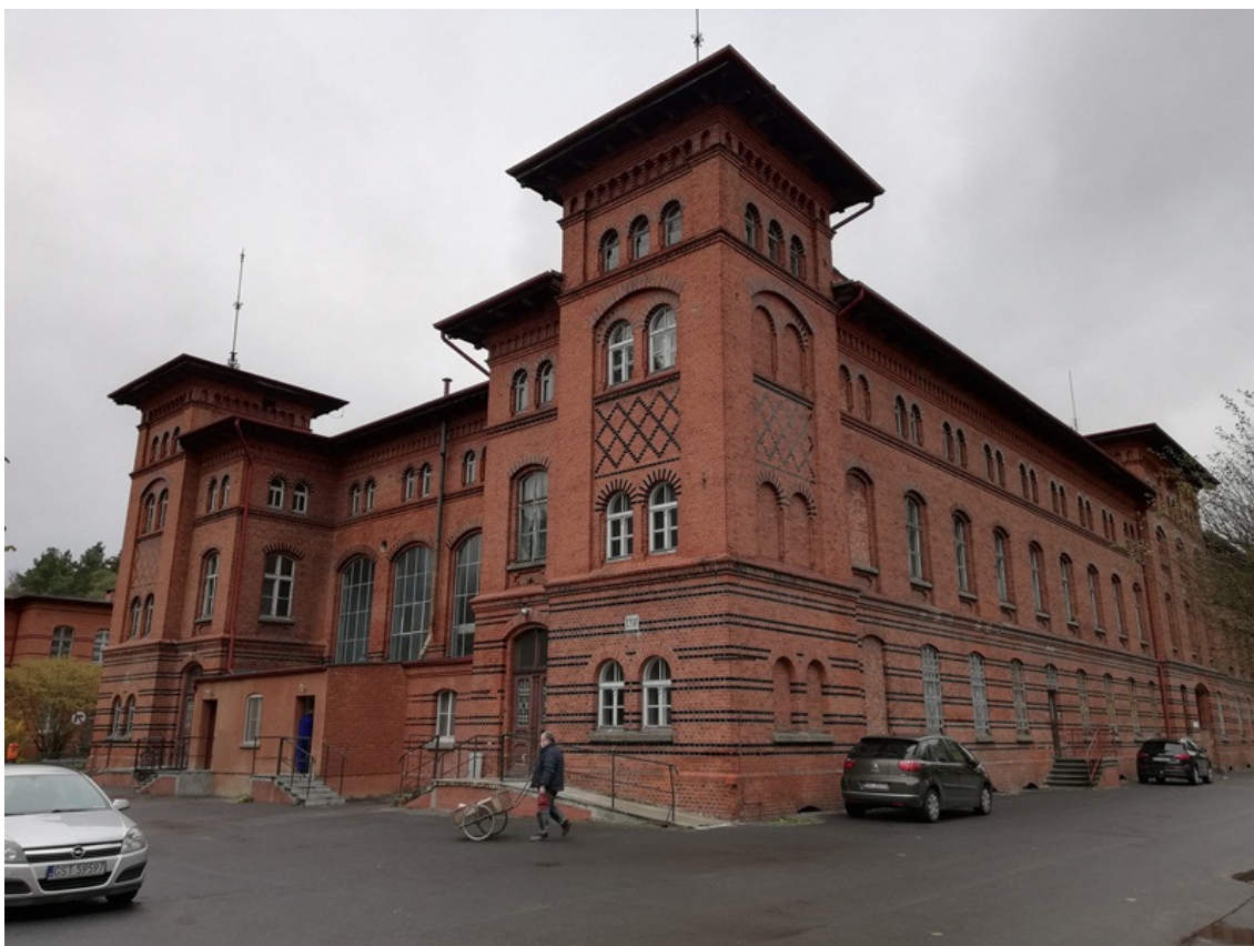
Budynek nr 26 – widok od południa
