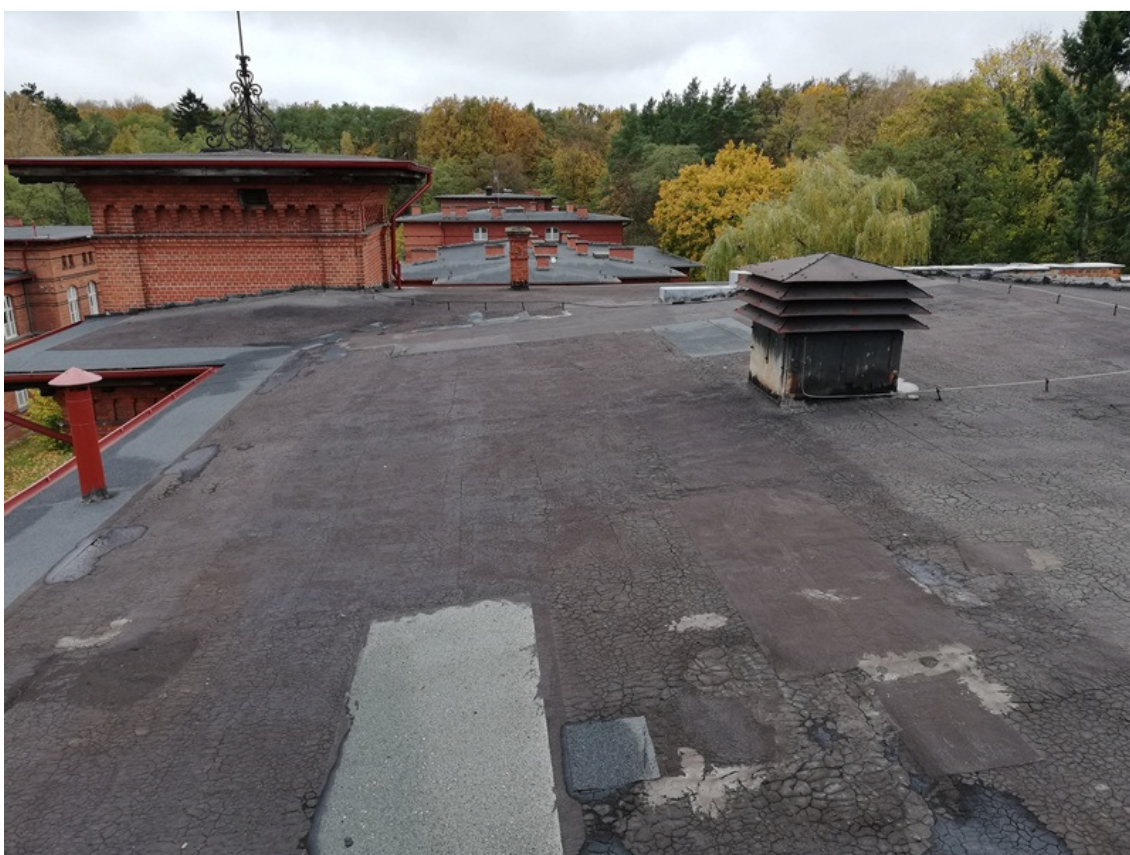
Pokrycie dachowe w części dachu przeznaczony pod instalację PV
