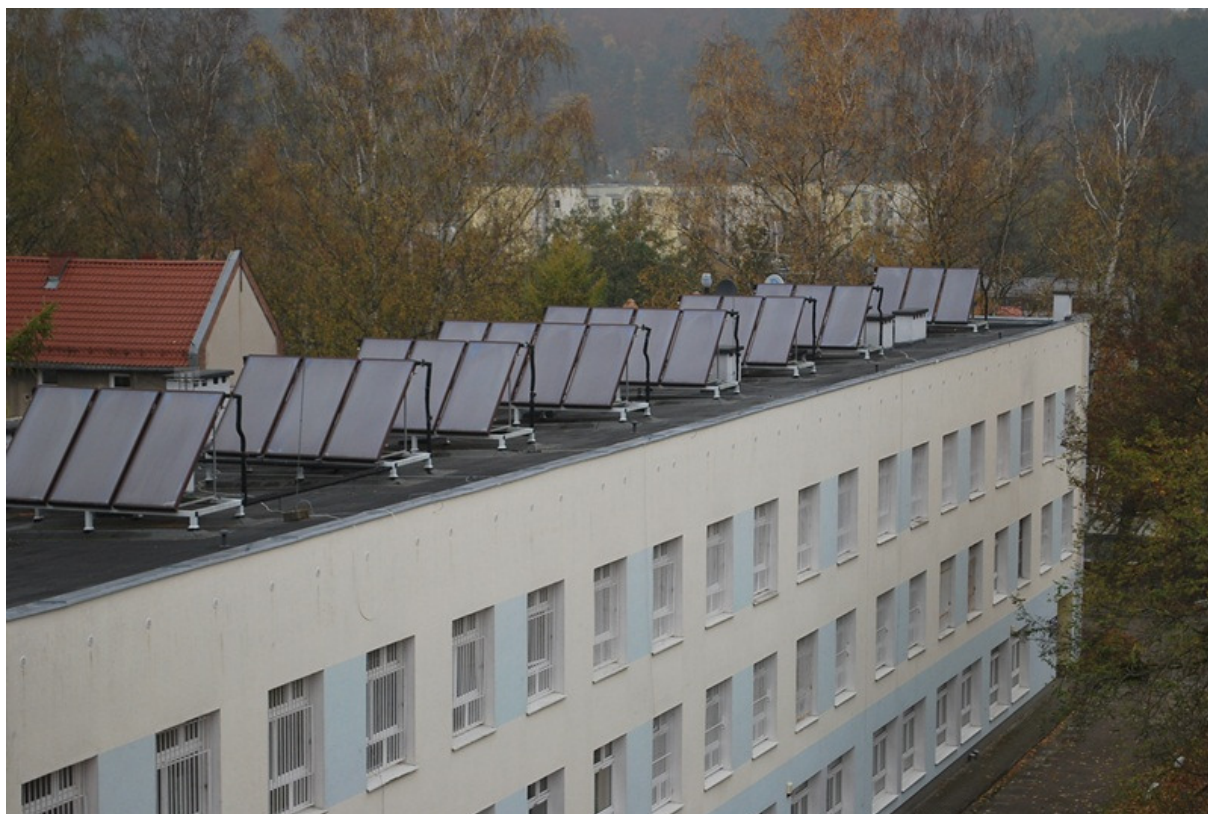
Widok z budynku nr 20 c.d.
