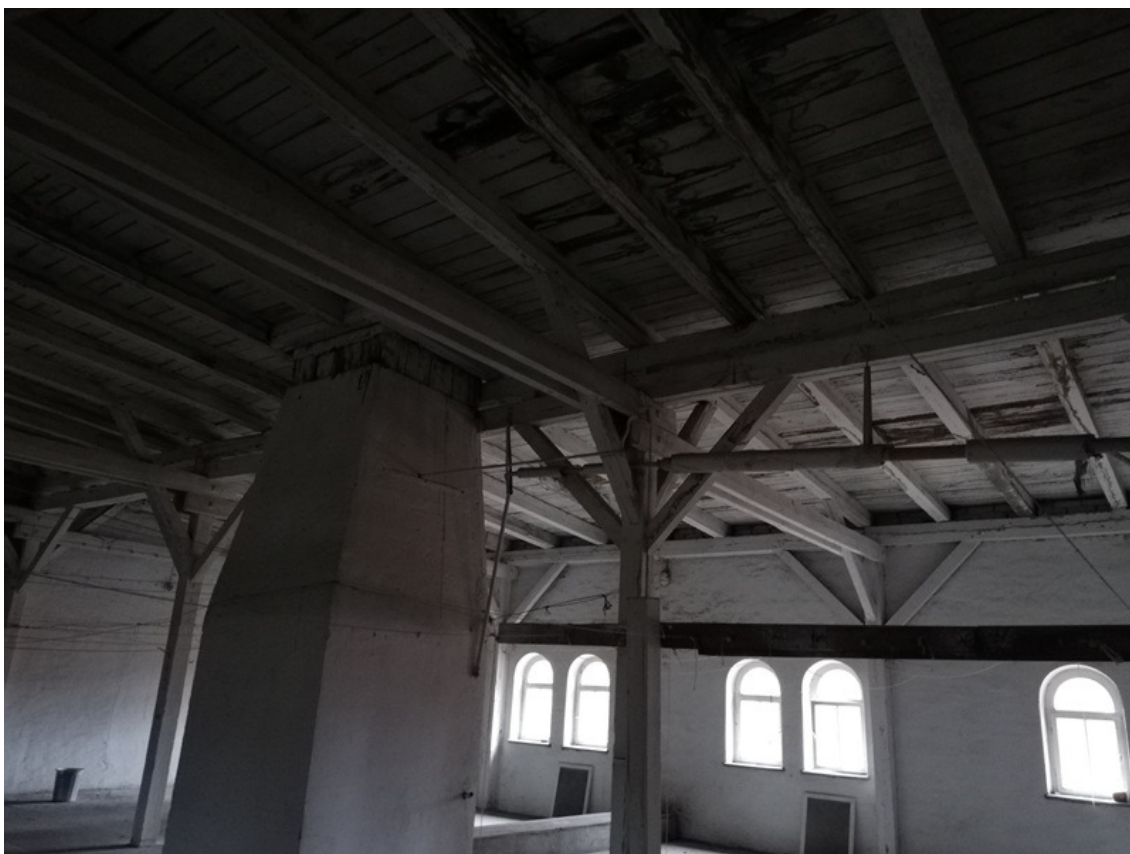
Widok konstrukcji dachu c.d.
