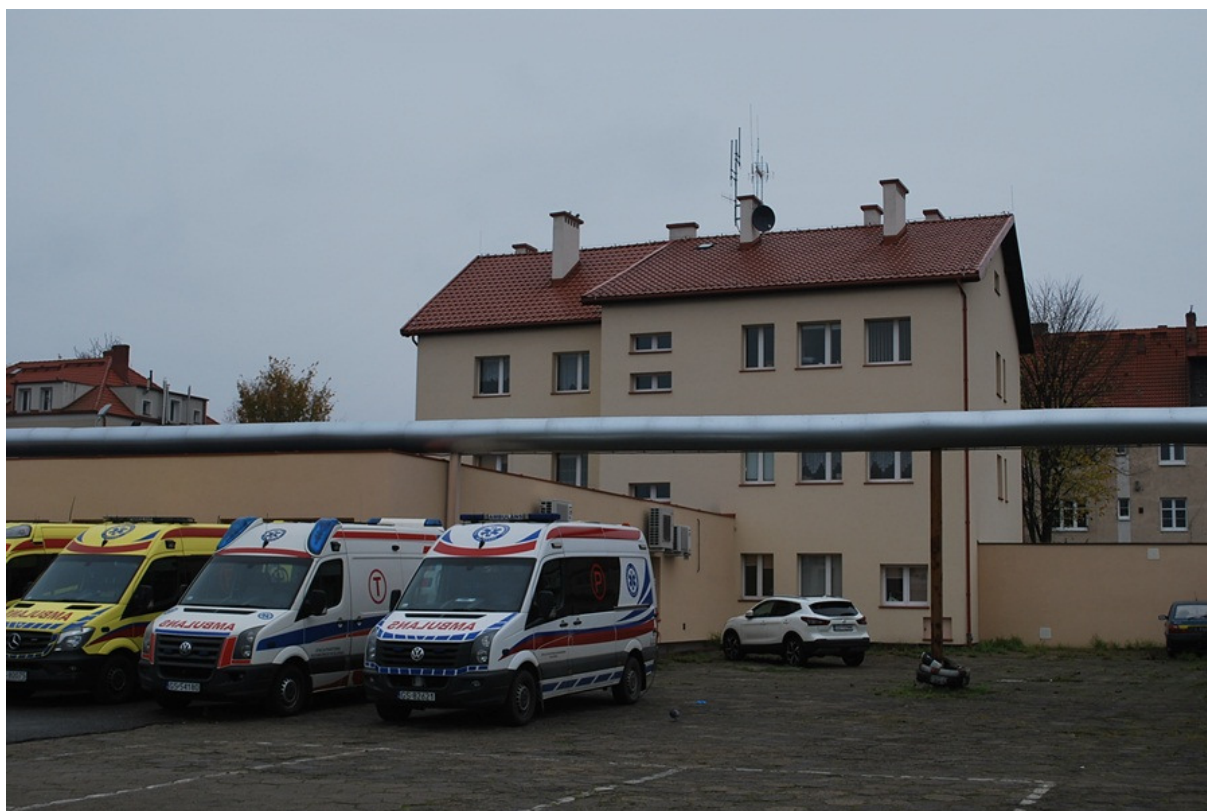
Budynek biurowo socjalny nr 12 – widok od południowego zachodu.
