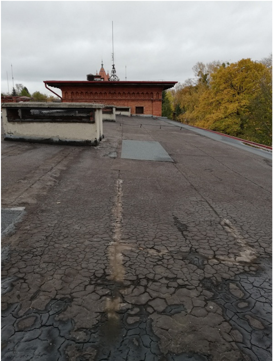
Pokrycie dachowe w części dachu przeznaczony pod instalację PV
