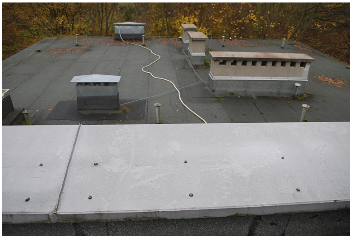
Widok na niższy dach na zachodzie.
