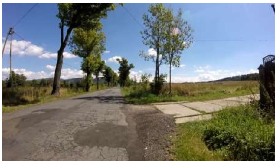
Zdj. nr 2 Początkowy odcinek drogi
