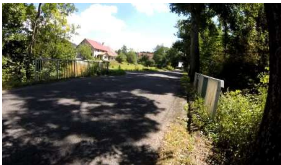
Zdj. nr 5 Koniec projektowanego odcinka
