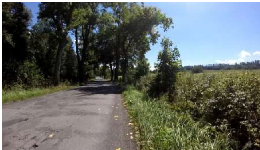
Zdj. nr 3 Środkowa część projektowanego odcinka
