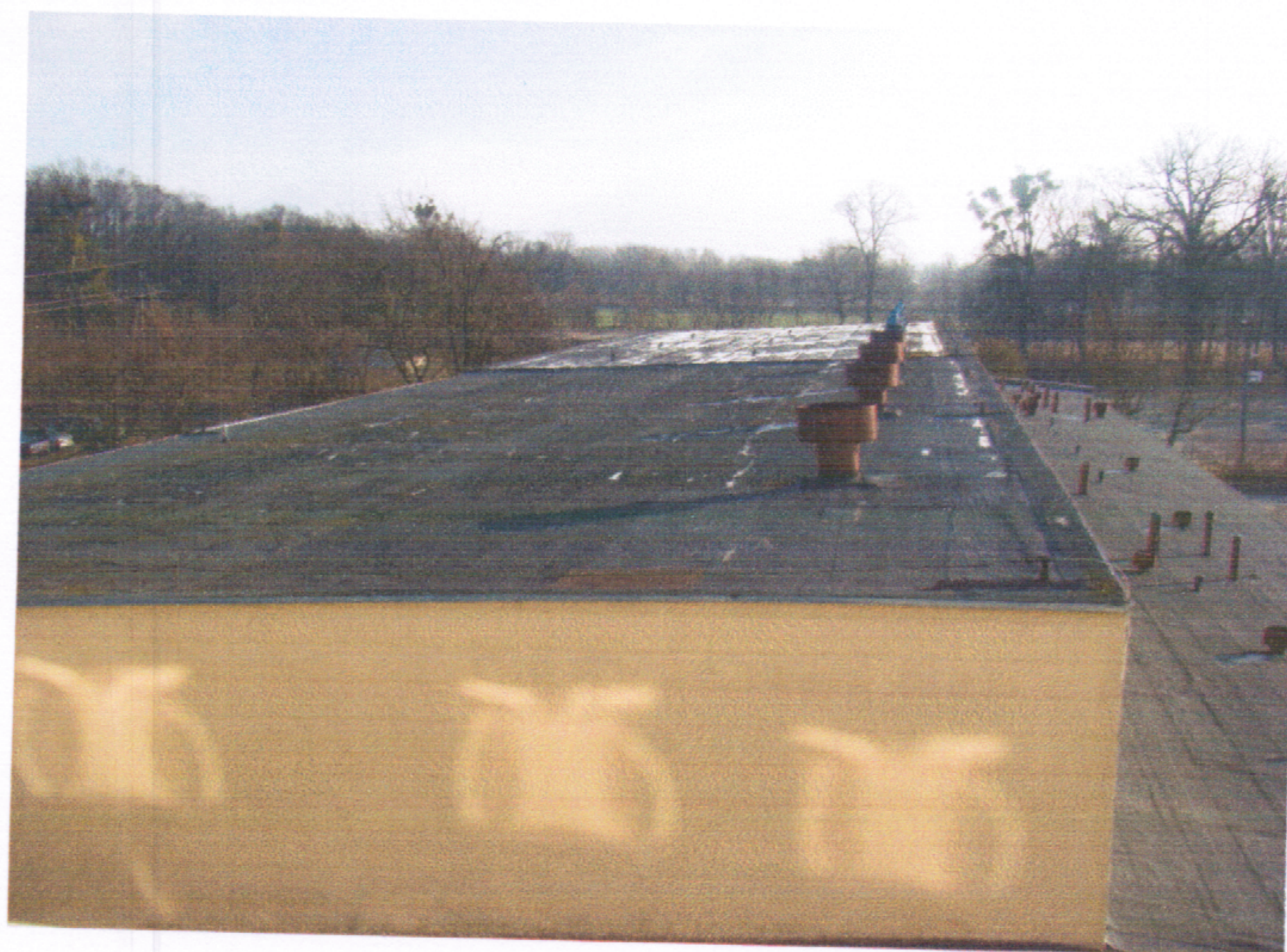
Widok dachu sali od strony zachodniej
