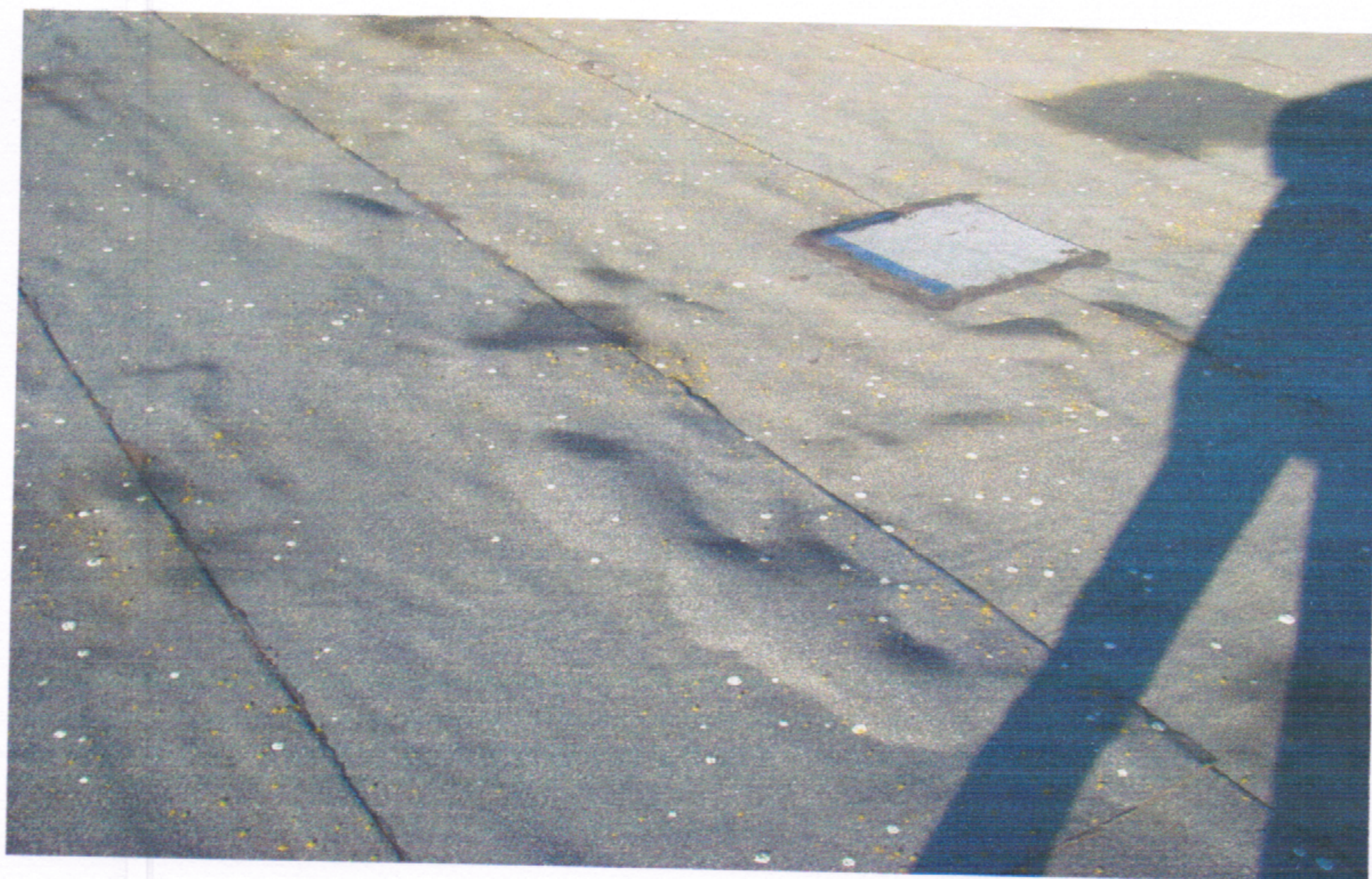
Widok pokrycia dachowego
