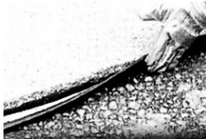
Rys. 2. Dociśnięcie taśmy topliwej dłonią w rękawicy poprzez papier przekładkowy, stroną z klejem zwróconą do powierzchni uszczelnianej
