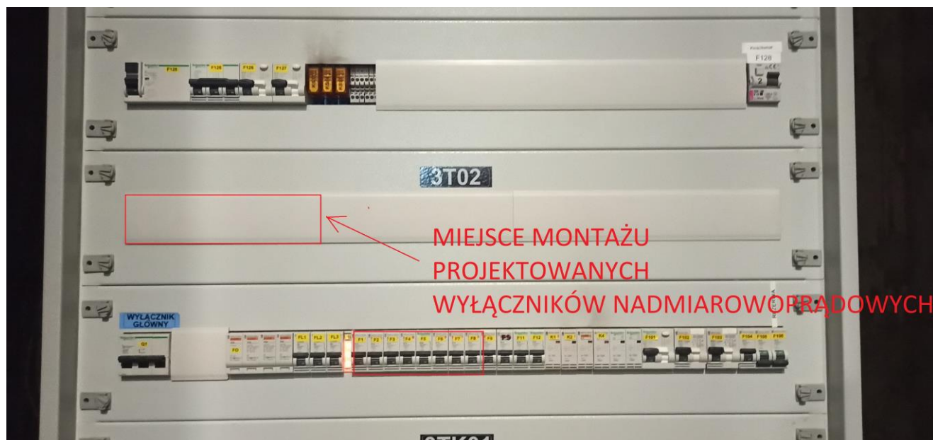
Rys 2. Projektowana zabudowa aparatów w rozdzielnicy 3T02 (zabezpieczenie urządzeń instalacji klimatyzacji)
