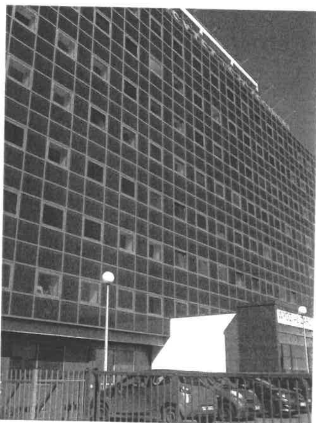
Fot. nr 3 Fragment elewacji frontowej budynku „A”
