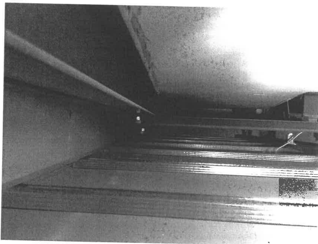
Fot. nr 2 Istniejąca konstrukcja do podwieszenia fasady elewacyjnej.
