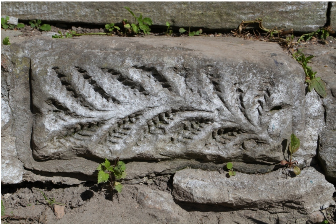
Fot. 16. Stopień schodów z piaskowca, elewacja zachodnia budynku przy ul. Spichrzowej 21 w Grudziądzu (fot. Karolina Witkowska).
