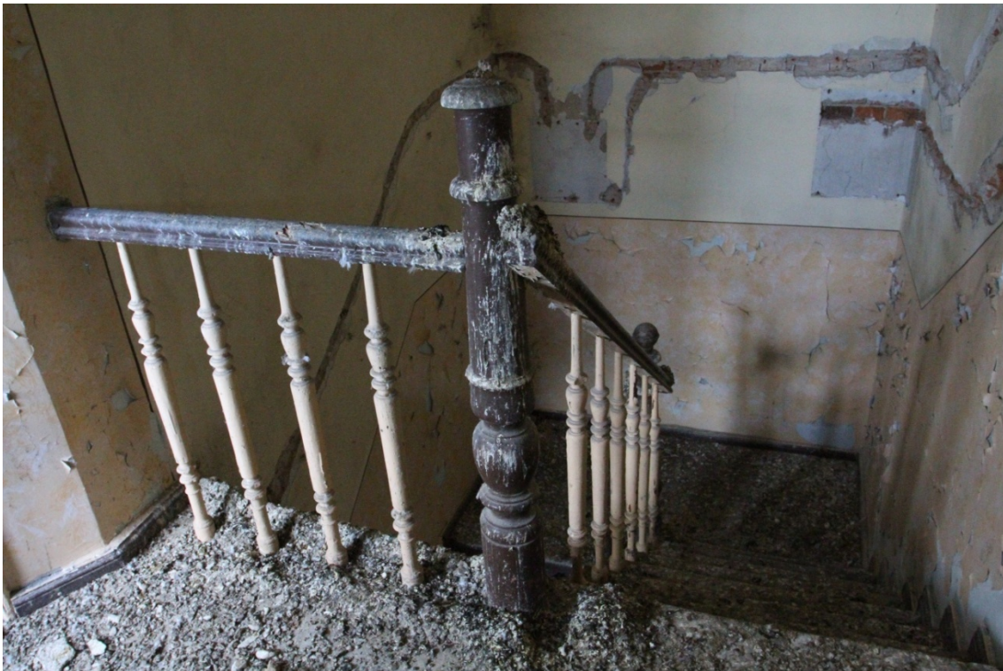
Fot. 38. Klatka schodowa budynków przy ul. Spichrzowej 21-23 w Grudziądzu (VI kondygnacja od zachodu, ulokowana w bryle budynku 23) (fot. Karolina Witkowska).
