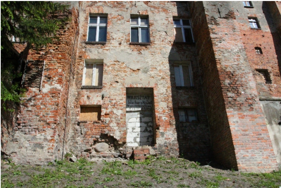
Fot. 13. Elewacja zachodnia budynku przy ul. Spichrzowej 23 w Grudziądzu (fot. Karolina Witkowska).
