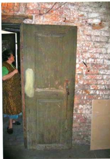
30. Drzwi pomiędzy pralnią a poddaszem (strychem).
