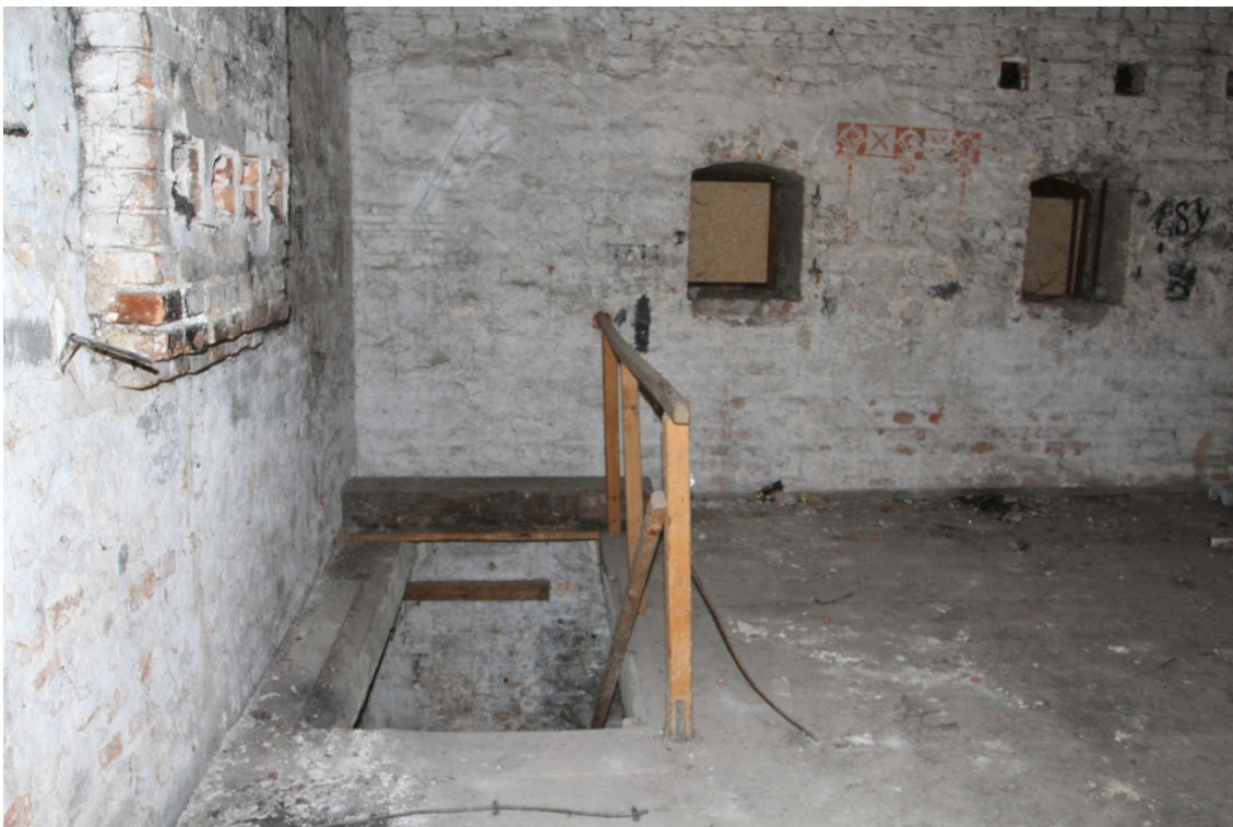
Fot. 21. Parter budynku przy ul. Spichrzowej 21 w Grudziądzu (fot. Karolina Witkowska).
