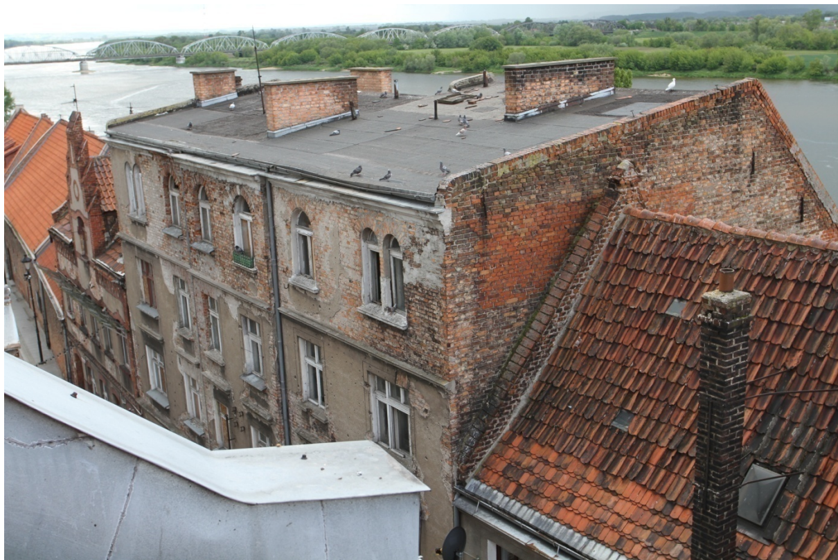
Fot. 48. Widok na dachy z kamienicy pod nr 34 (fot. Karolina Witkowska).
