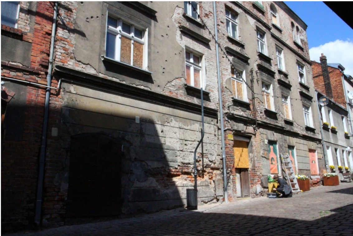
Fot. 2. Elewacja wschodnia budynków przy ul. Spichrzowej 21-23 w Grudziądzu (fot. Karolina Witkowska).
