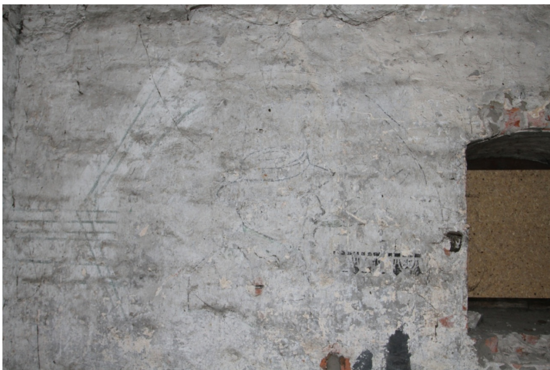
Fot. 23. Parter budynku przy ul. Spichrzowej 21 w Grudziądzu (fot. Karolina Witkowska).
