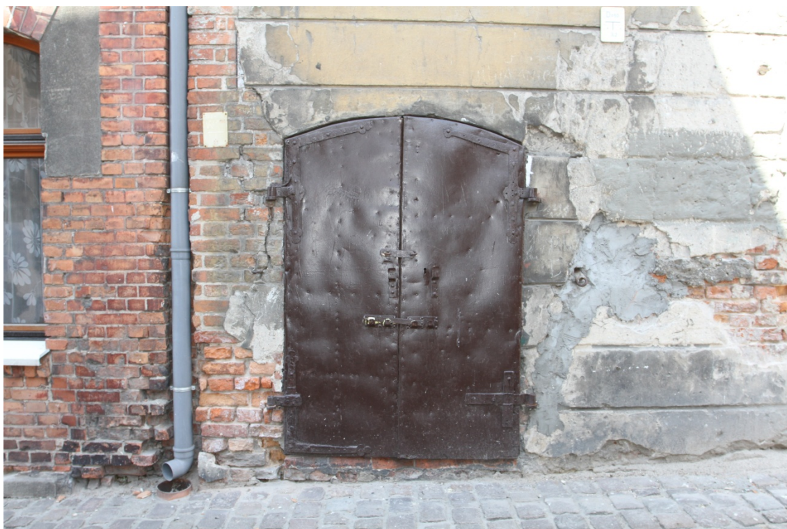
Fot. 4. Drzwi wejściowe do budynku nr 21, elewacja wschodnia (fot. Karolina Witkowska).
