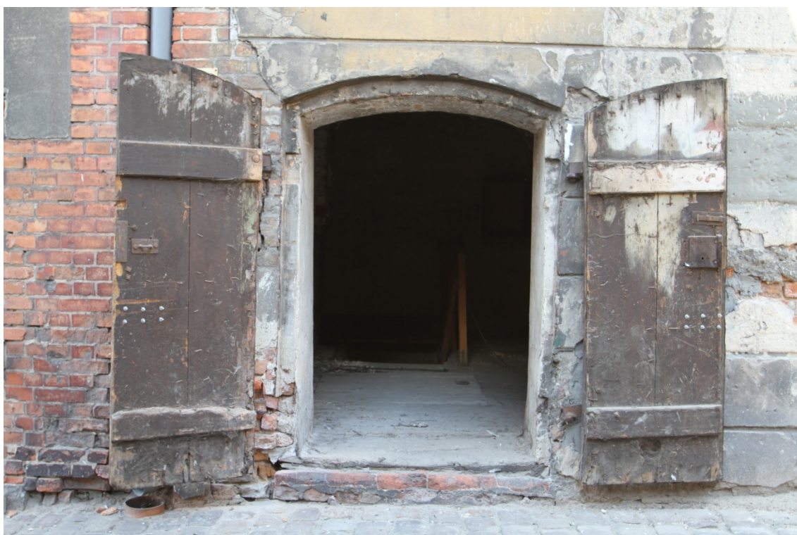
Fot. 5. Drzwi wejściowe do budynku nr 21, elewacja wschodnia (fot. Karolina Witkowska).
