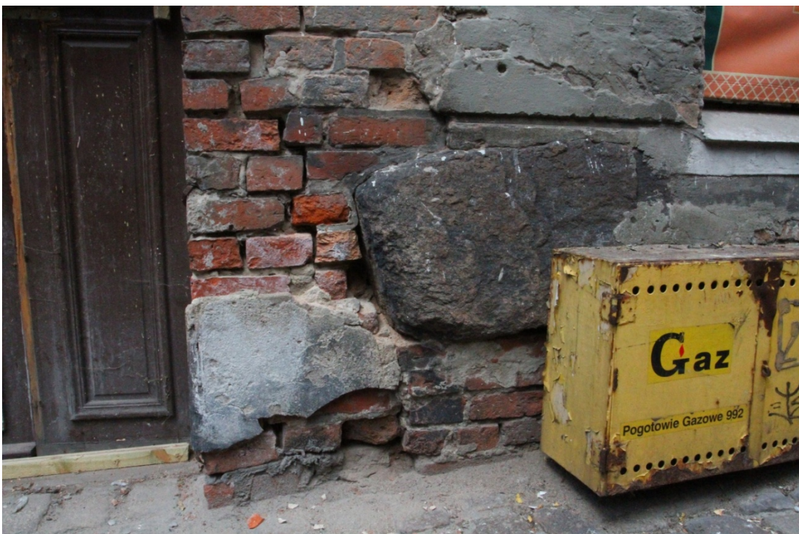
Fot. 3. Kamienie w przyziemiu, elewacja wschodnia budynków przy ul. Spichrzowej 21-23 w Grudziądzu (fot. Karolina Witkowska).
