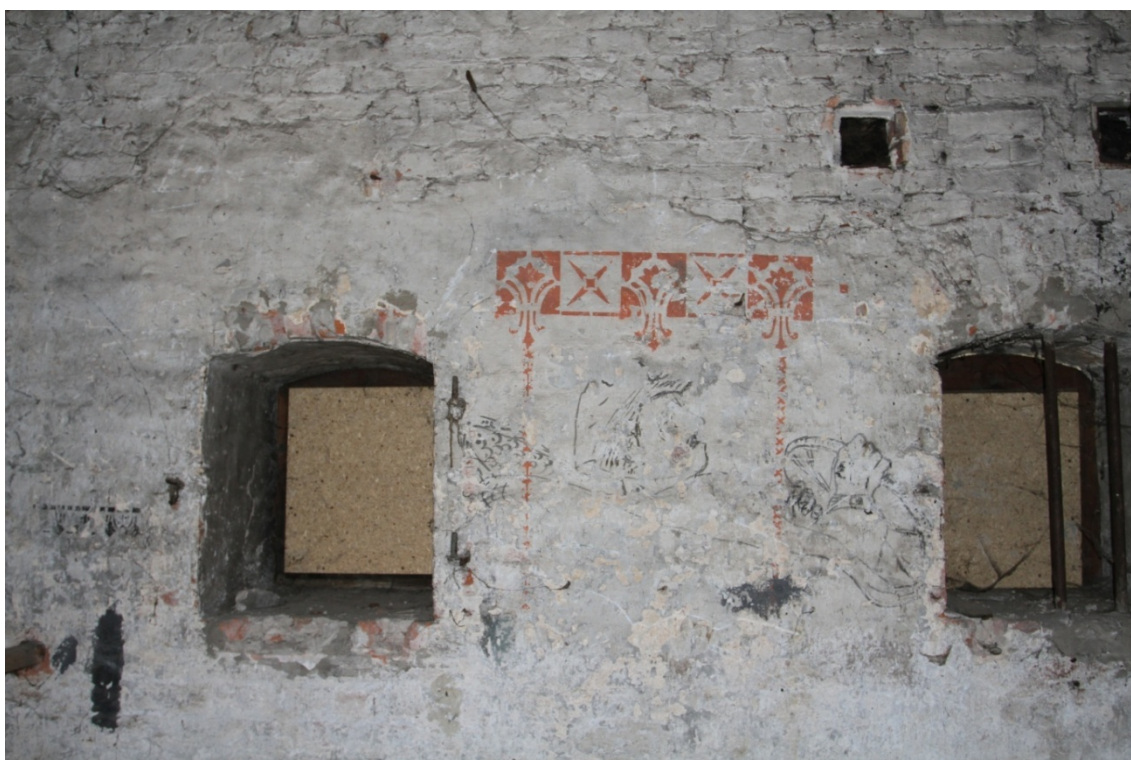
Fot. 24. Parter budynku przy ul. Spichrzowej 21 w Grudziądzu (fot. Karolina Witkowska).
