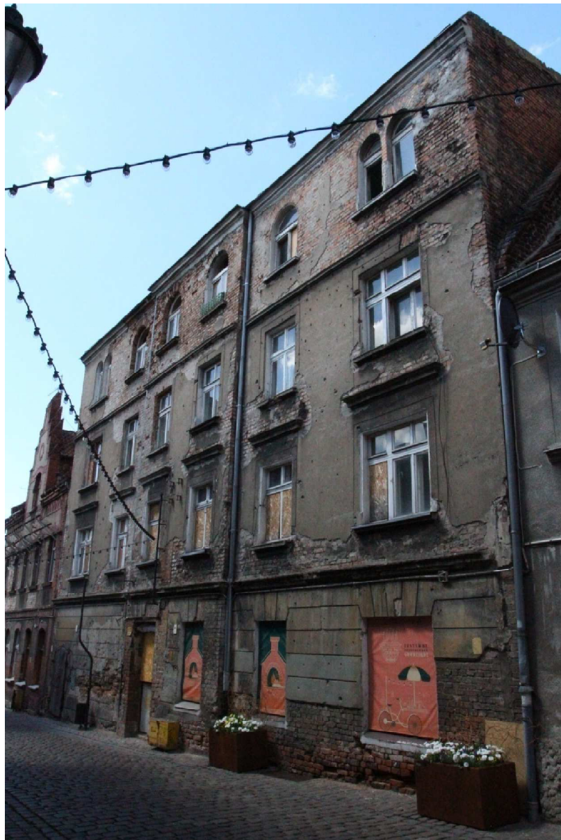
Fot. 1. Elewacja wschodnia budynków przy ul. Spichrzowej 21-23 w Grudziądzu (fot. Karolina Witkowska).
