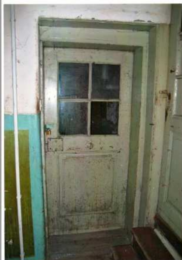
29. Drzwi do pomieszczeń piwnicznych.
