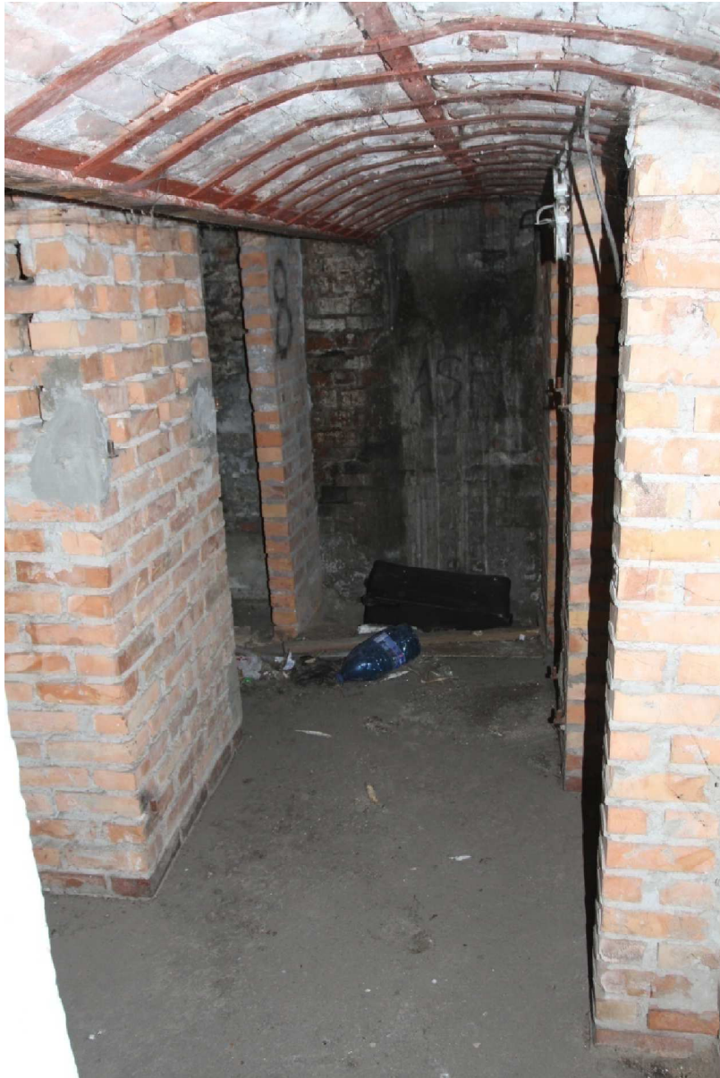
Fot. 30. Wtórne ścianki i wzmocnienia kolebek, piwnica budynku przy ul. Spichrzowej 23 w Grudziądzu (I kondygnacja od zachodu) (fot. Karolina Witkowska).
