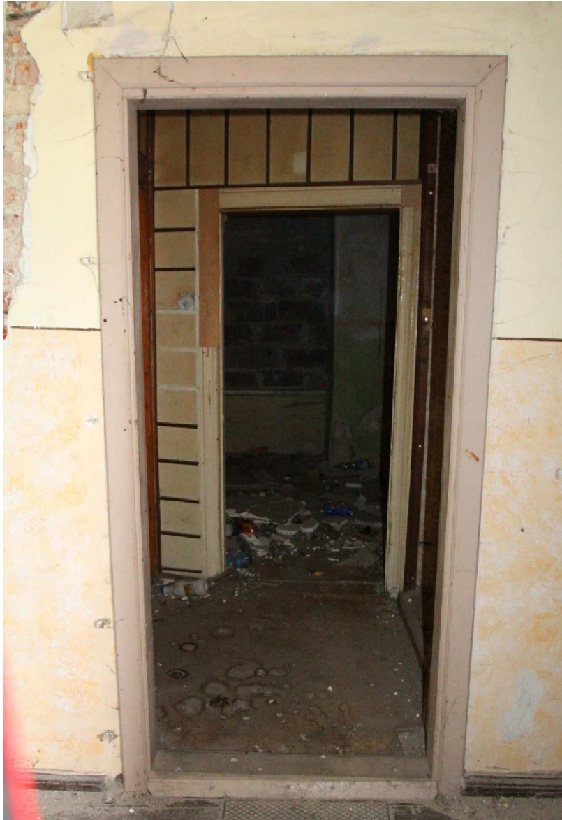
Fot. 40. Wejście do mieszkania w budynku 21-23 w Grudziądzu (II kondygnacja od zachodu, ulokowane w bryle budynku 23) (fot. Karolina Witkowska).
