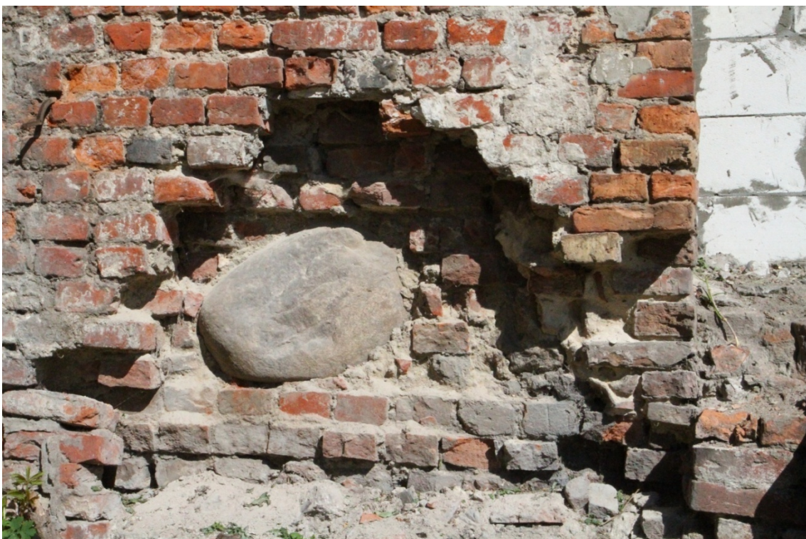
Fot. 14. Elewacja zachodnia budynku przy ul. Spichrzowej 23 w Grudziądzu (fot. Karolina Witkowska).
