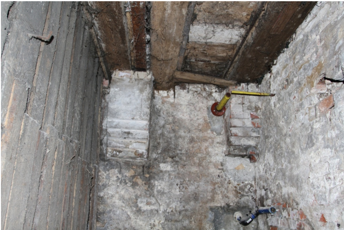
Fot. 33. Wsporniki kostkowe, piwnica budynku przy ul. Spichrzowej 23 w Grudziądzu (II kondygnacja od zachodu) (fot. Karolina Witkowska).
