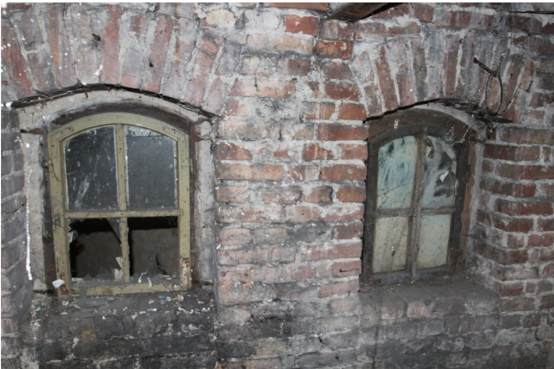
Fot. 28. Okienka między traktem wschodnim i zachodnim, piwnica budynku przy ul. Spichrzowej 23 w Grudziądzu (I kondygnacja od zachodu) (fot. Karolina Witkowska).
