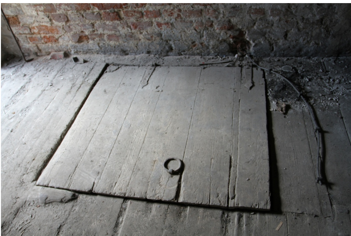
Fot. 22. Parter budynku przy ul. Spichrzowej 21 w Grudziądzu (fot. Karolina Witkowska).
