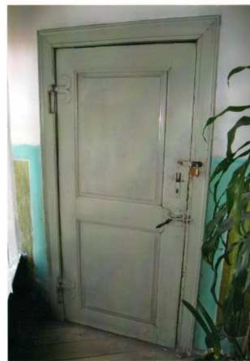
31. Drzwi do pralni i strychu w poddaszu.
