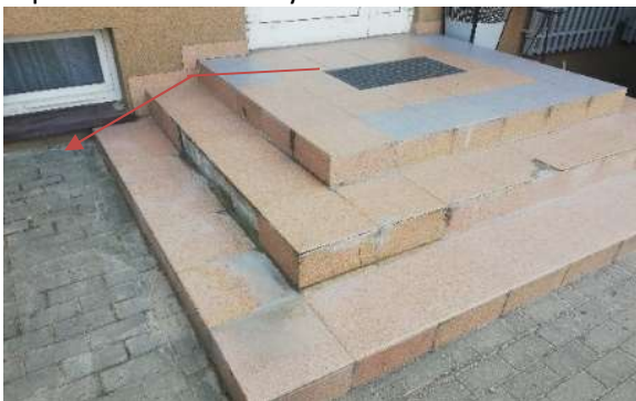
schody nr 1 – trasa nowego odwodnienia
