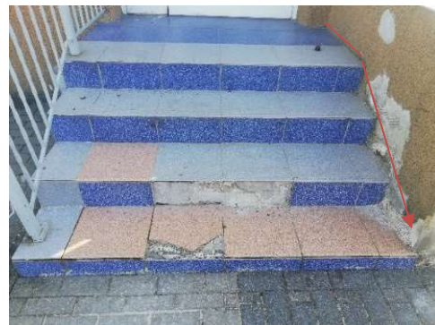
schody nr 2 – trasa nowego cokołu wys.15cm.
