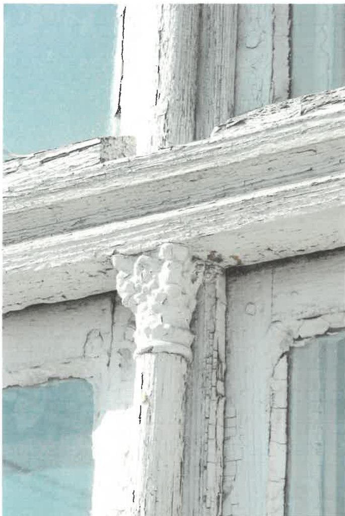
Fragment oryginalnego okna. Zaznaczono miejsce pobrania próbki.
