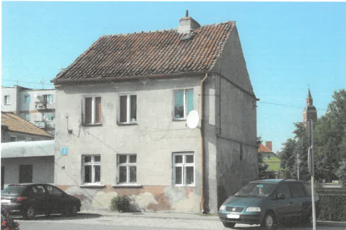
Widok ogólny elewacji frontowej.
