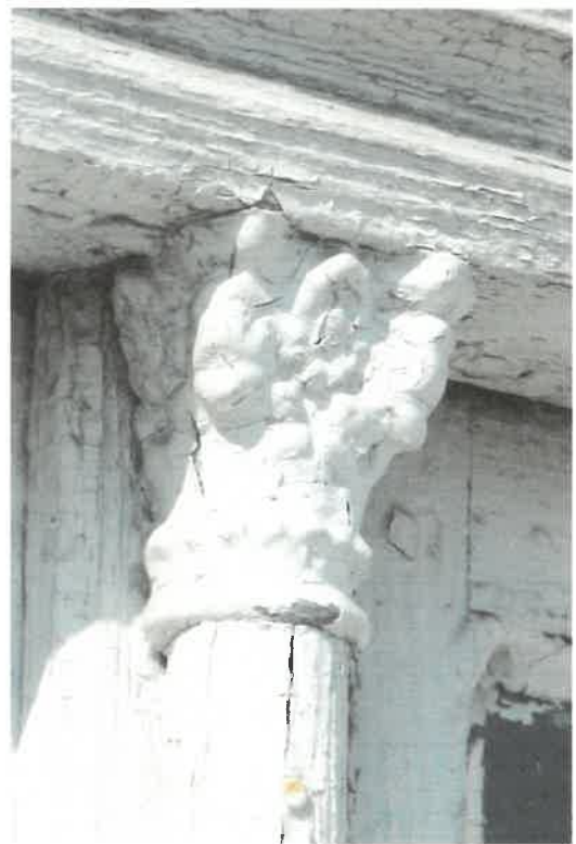
Oryginalne okno wyposażone jest w półwałki na listwach przymykowych, cynowe kapitele i profilowane ślęmię.
