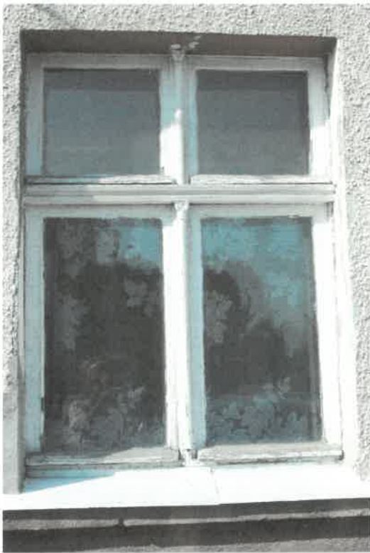
Oryginalne okno wyposażone jest w półwałki na listwach przymykowych, cynowe kapitele i profilowane ślęmię.
