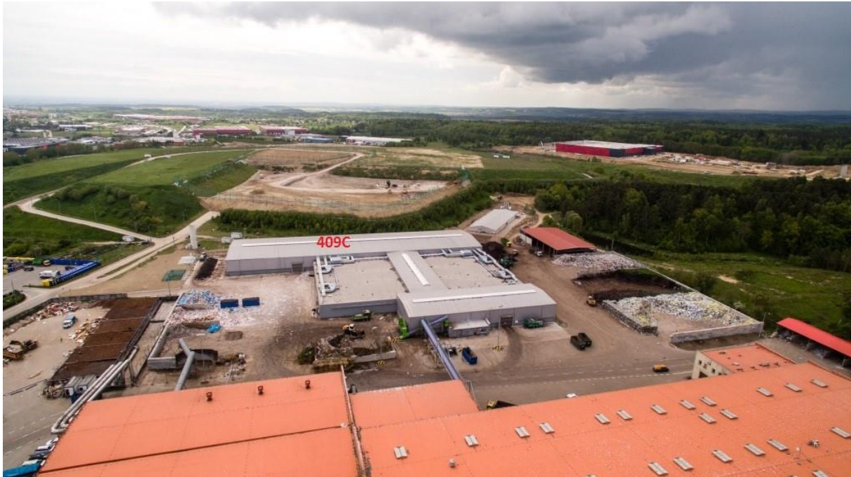
Zdj.3 Widok obiektu od strony północnej
