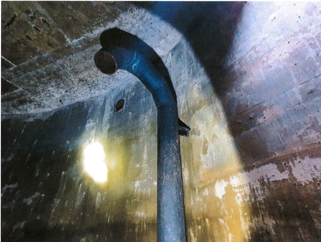
Zdjęcie 7. Płyta stropowa oraz ściana zewnętrzna
