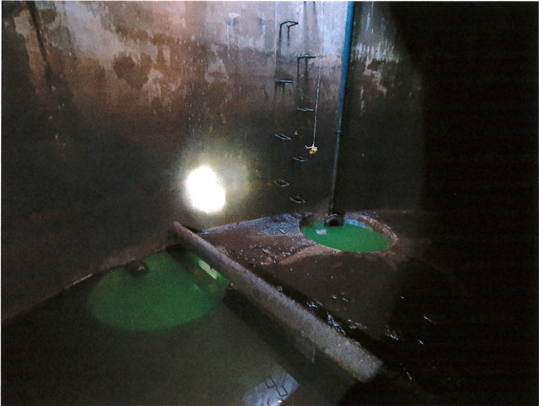
Zdjęcie 5. Płyta denna oraz ściana zewnętrzna
