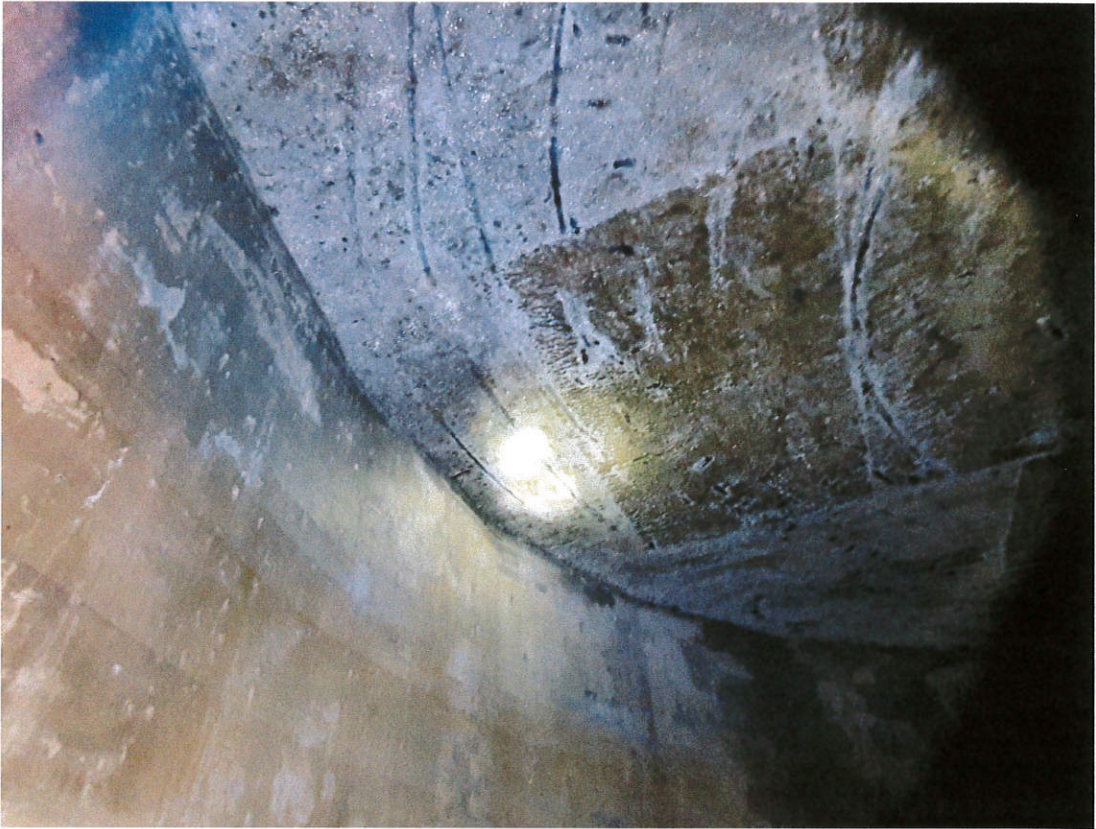
Zdjęcie 3. Płyta stropowa – widoczne zbrojenie
