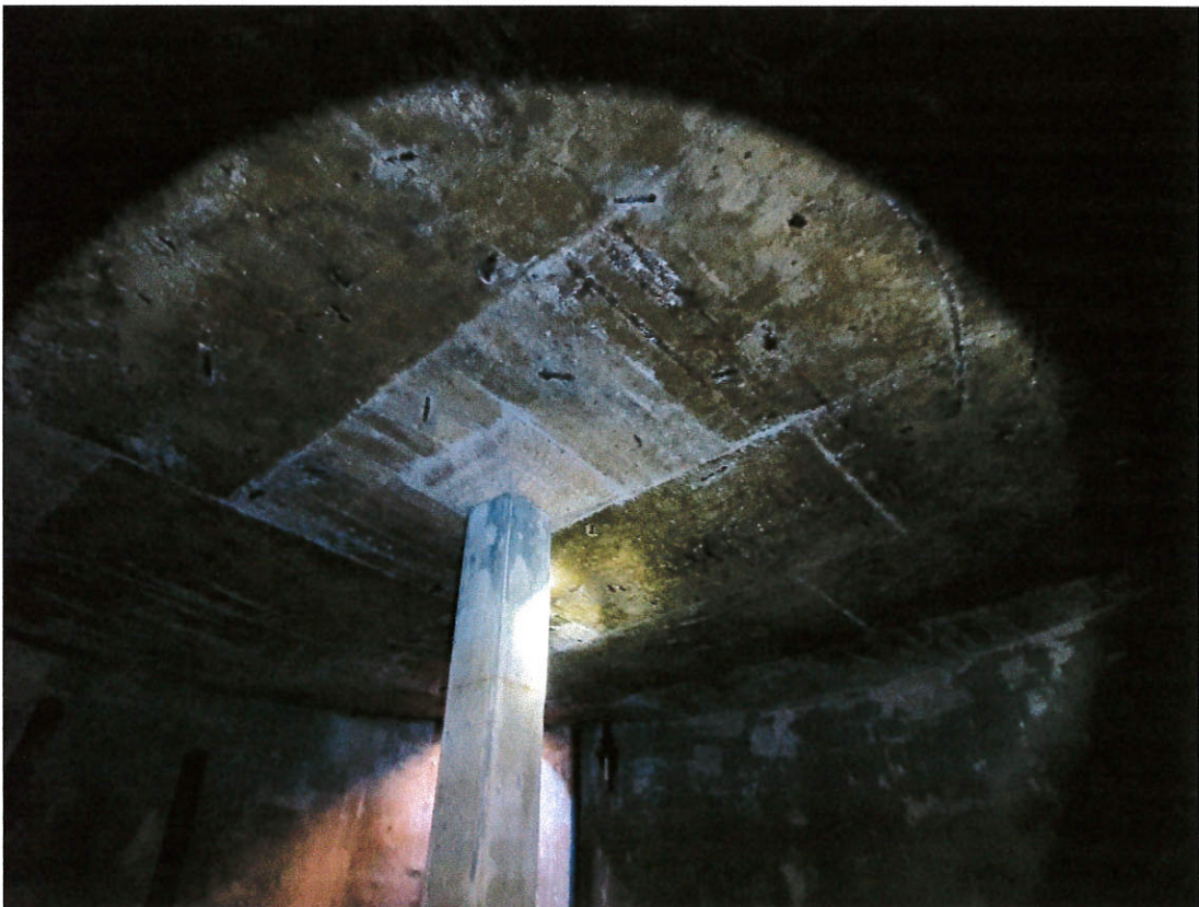
Zdjęcie 8. Płyta stropowa oraz słup
