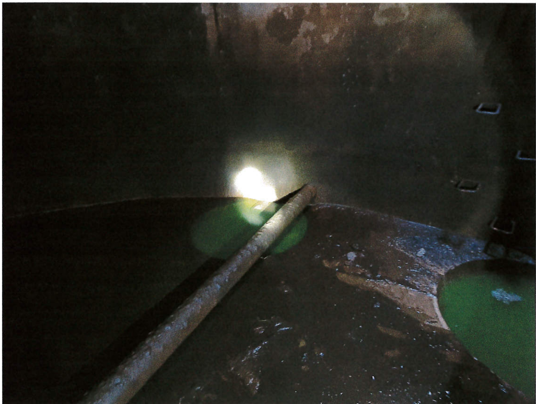
Zdjęcie 6. Płyta denna oraz ściana zewnętrzna
