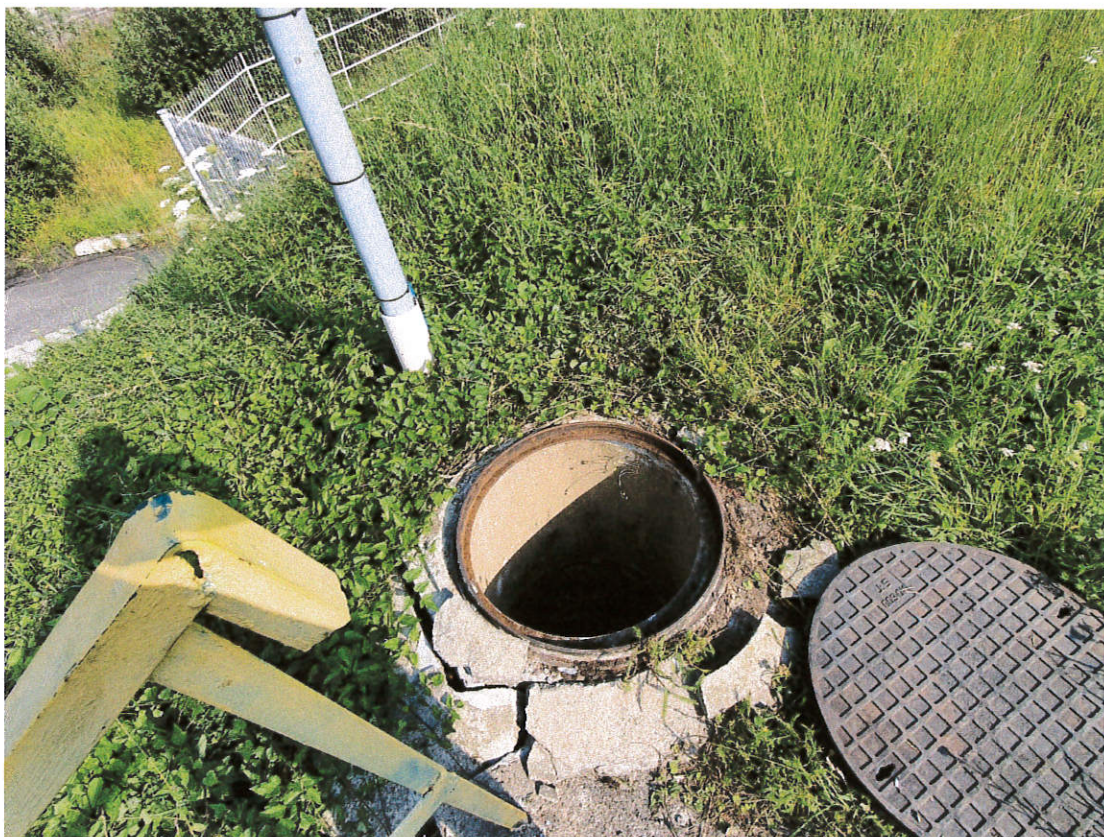
Zdjęcie 2. Właz do zbiornika
