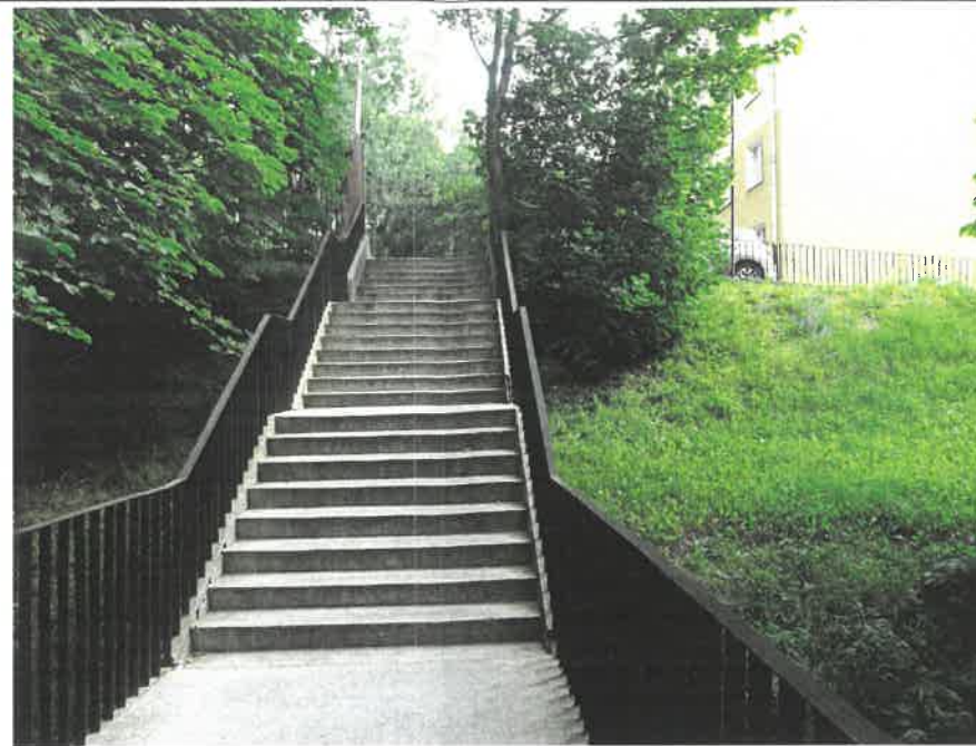
Fot. 2 Widok z kładki na 3 biegi schodów z obustronną balustradą z płaskownika stalowego
