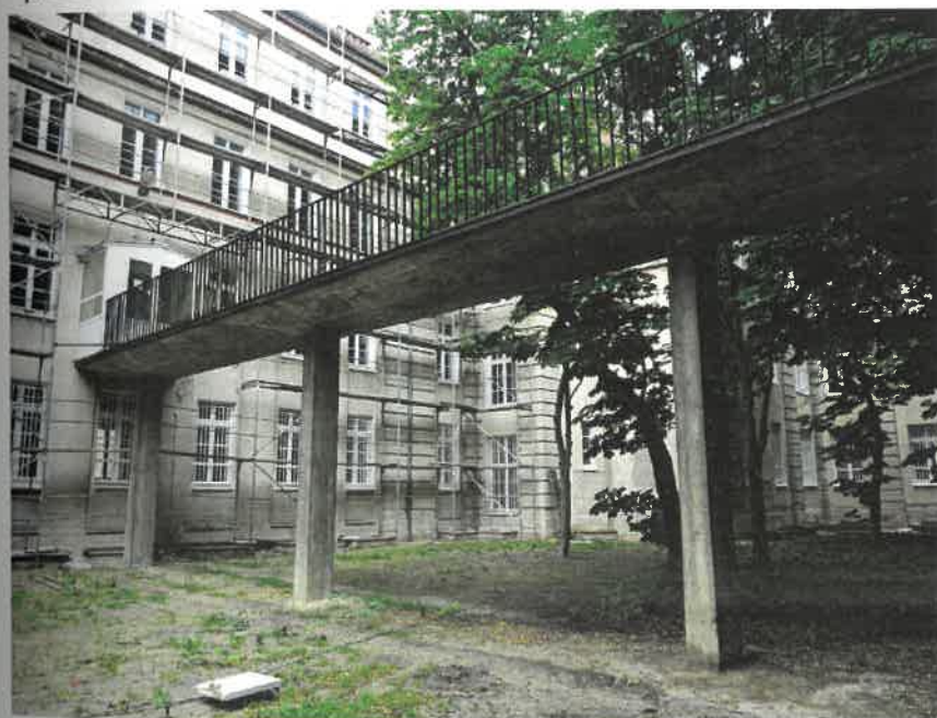
Fot. 4 Część południowych przęseł kładki z żelbetowymi słupami w widoku na centralną część elewacji północnej budynku nr 9 z wejściem do przedsionka
