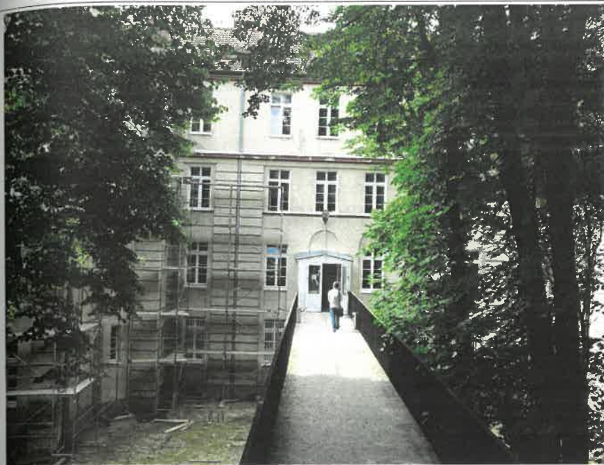
Fot. 1 Widok ze schodów terenowych na kładkę i w głębi przedsionek wejścia na tle elewacji północnej bud. nr 9
