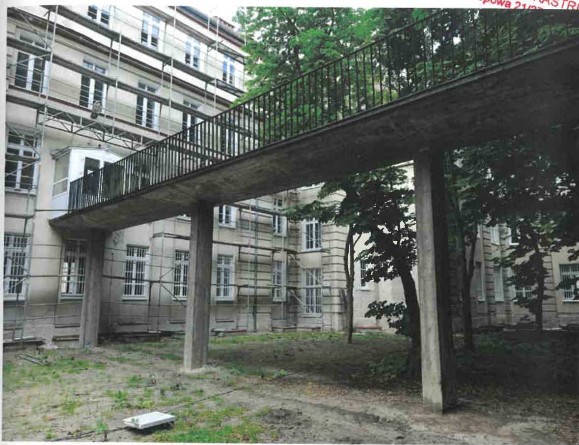
Fot. 1 Widok z boku na kładkę w kierunku budynku nr 9 AMW
