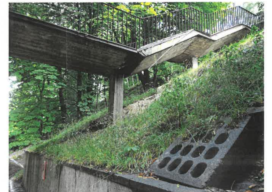
Fot. 6 Styk z dylatacją kładki i schodów po skarpie na osiowym układzie żelbetowych słupów
