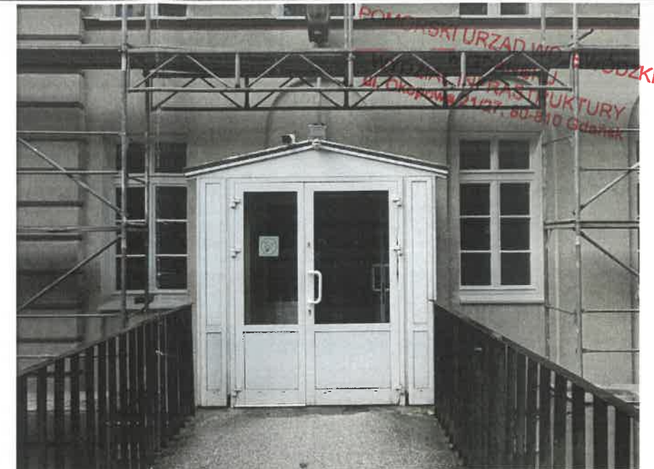
Fot. 3 Przedsionek - wejście do budynku nr 9 w elewacji północnej
