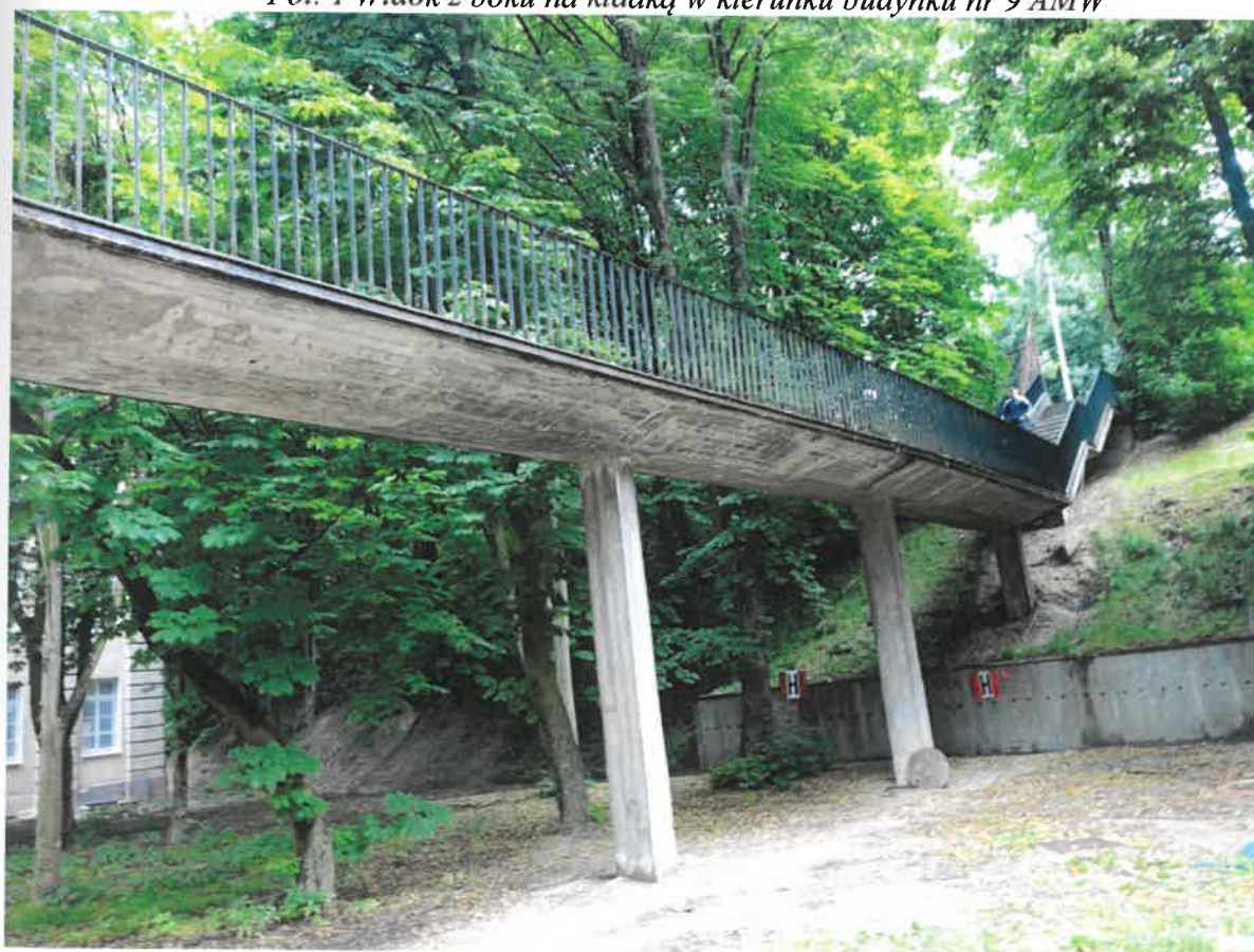
Fot. 2 Widok z boku na kładkę w kierunku schodów wejściowych
