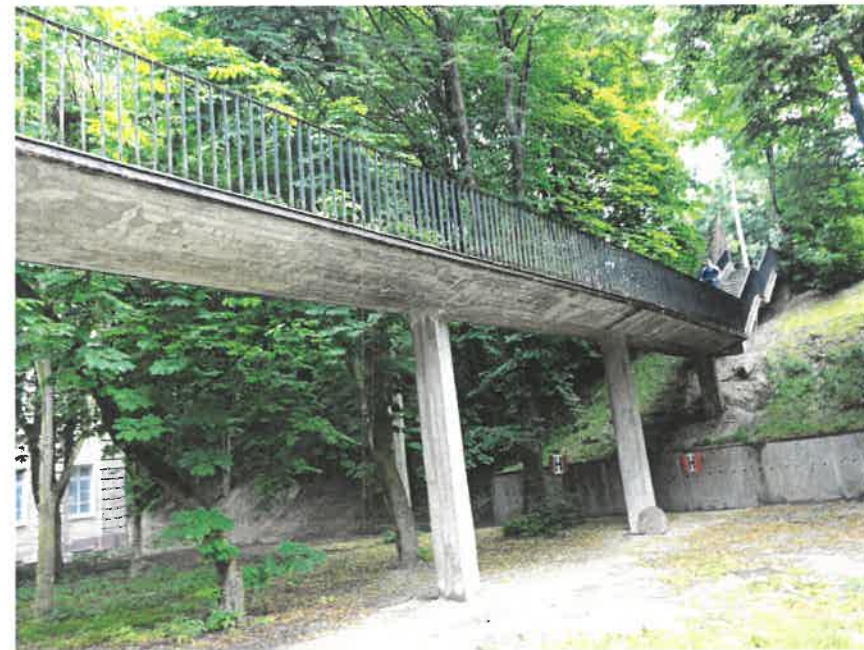
Fot. 5 Część północna przęseł kładki z widokiem na skarpe ze schodami żelbetowymi na słupach
