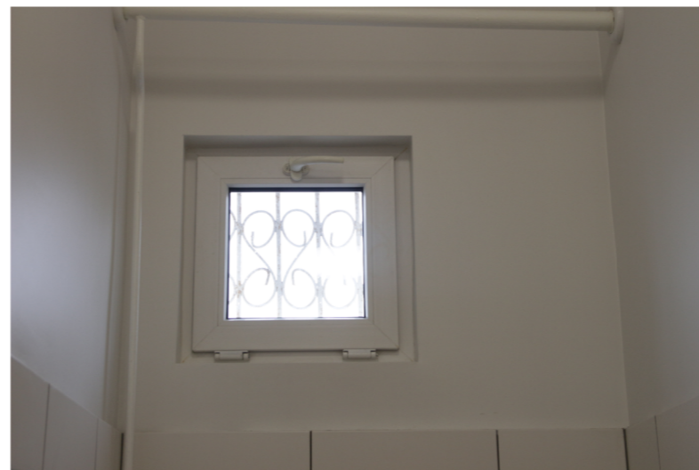
WIDOK MNIEJSZEGO OKNA OD WNĘTRZA
