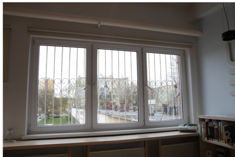
WIDOK WIĘKSZEGO OKNA OD WNĘTRZA
