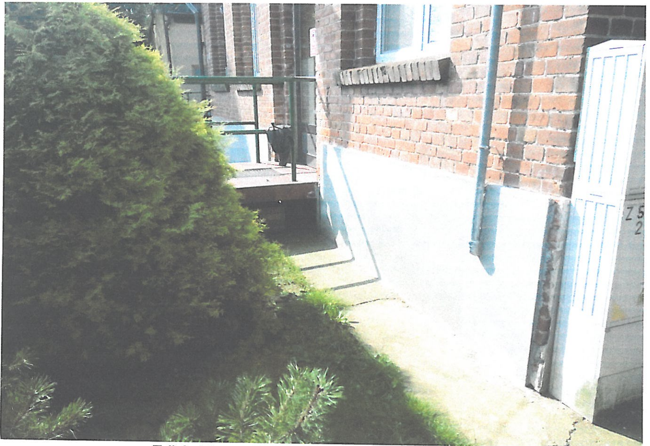
Zdj.8. Elewacja frontowa – schody wejściowe
