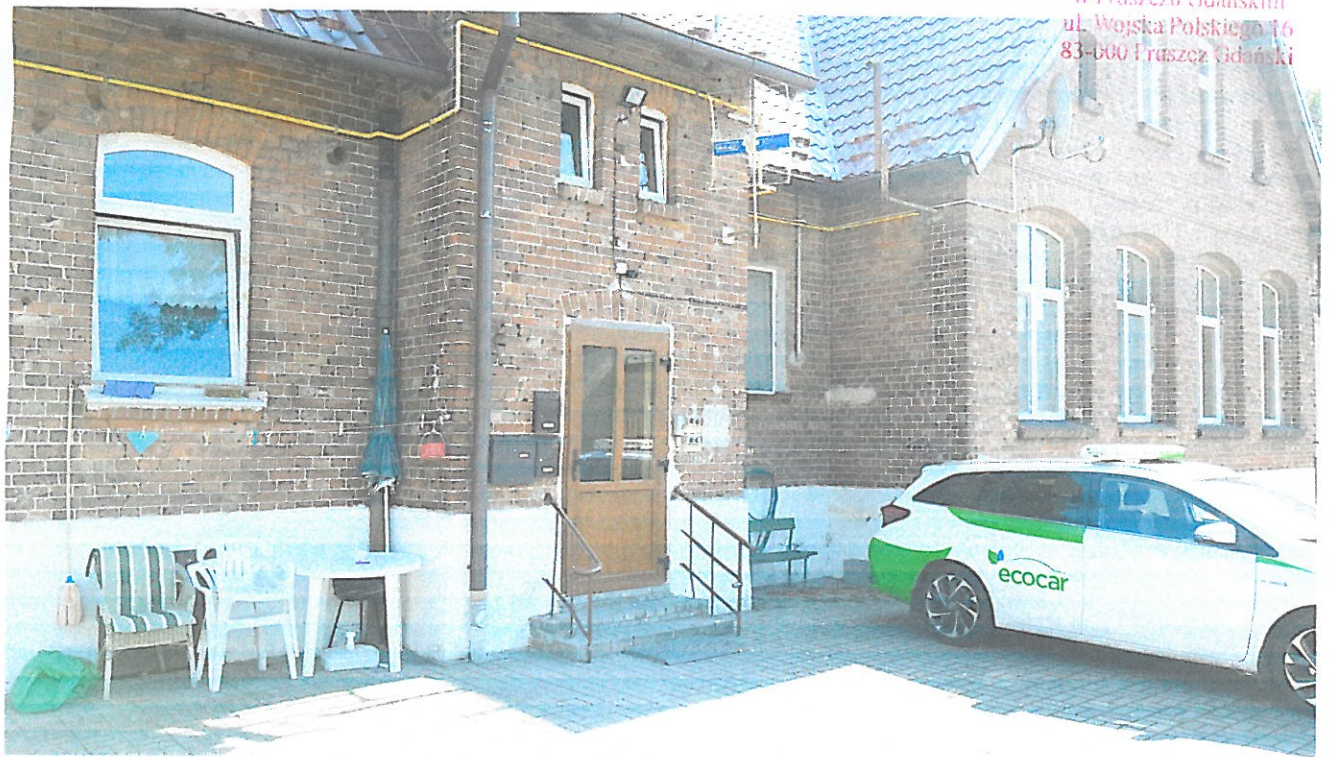
Zdj.3. Elewacja podwórza – wejście do budynku – część mieszkalna
