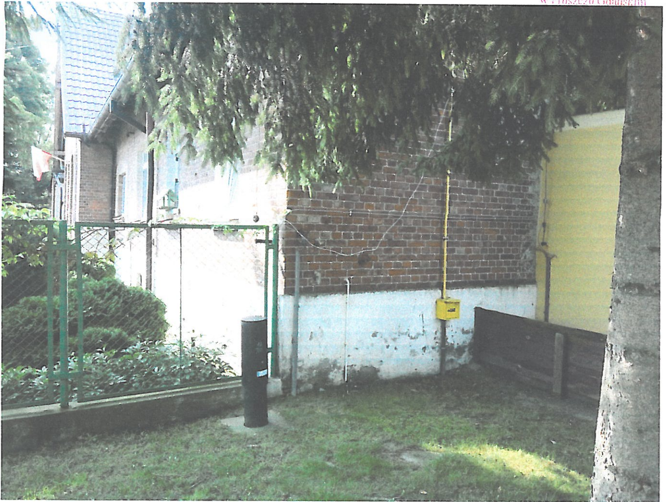
Zdj.11.Elewacja boczna - widok na stan elewacji
