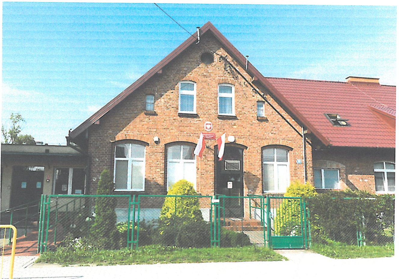
Zdj.6. Elewacja frontowa – wejście, widok z ulicy
