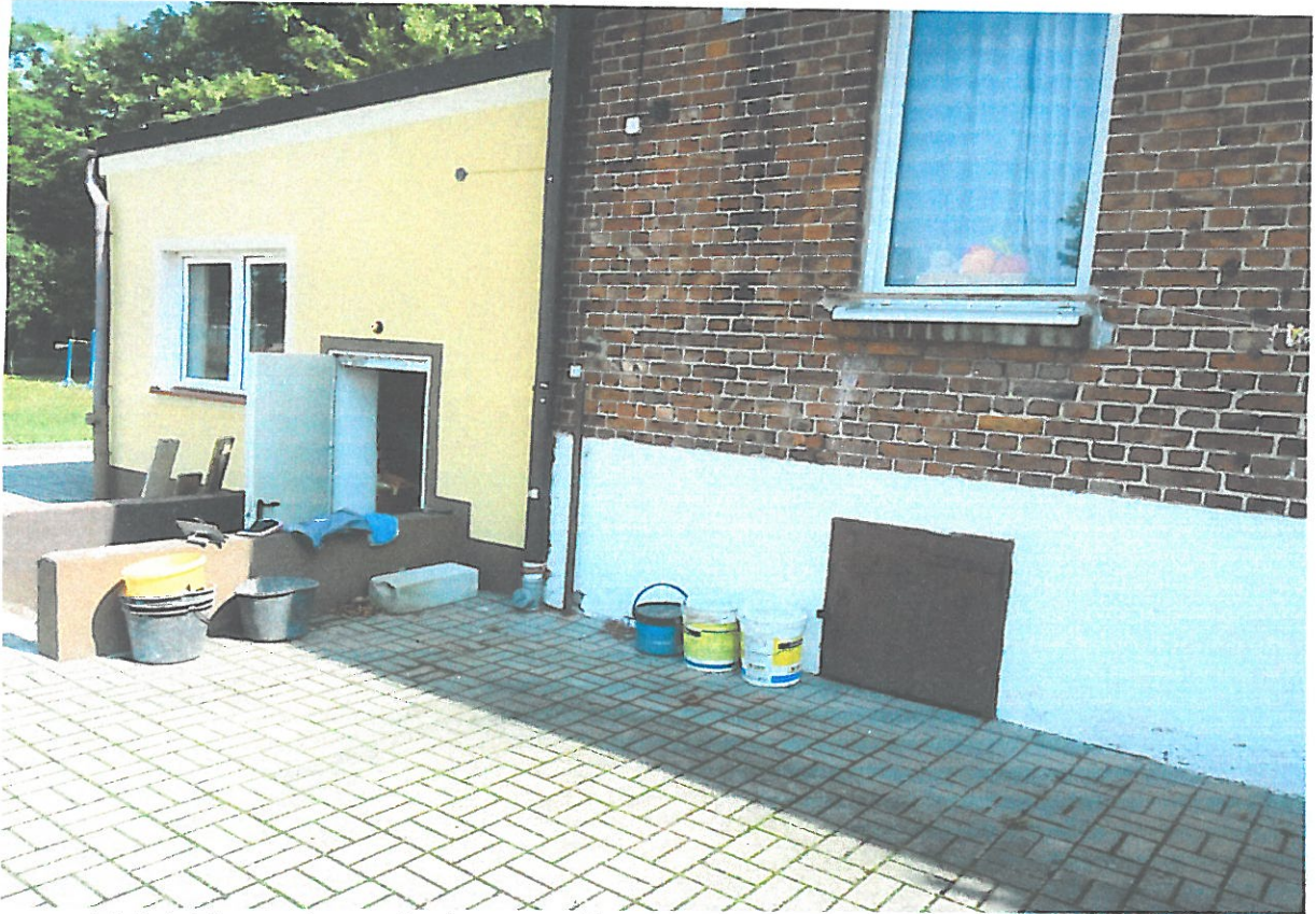
Zdj.1.Elewacja podwórza – połączenie budynku starego z kotłownią
