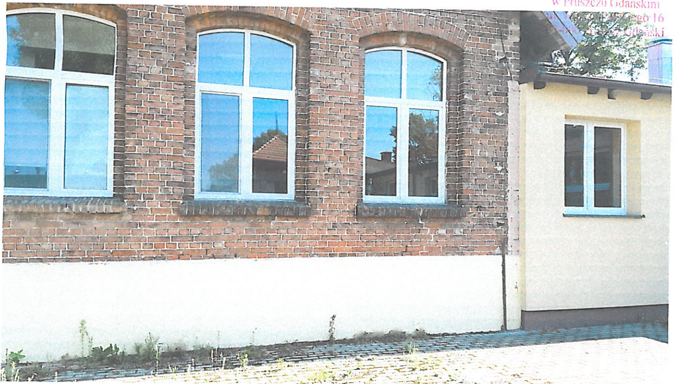
Zdj.5. Elewacja podwórza – połączenie z nową częścią
