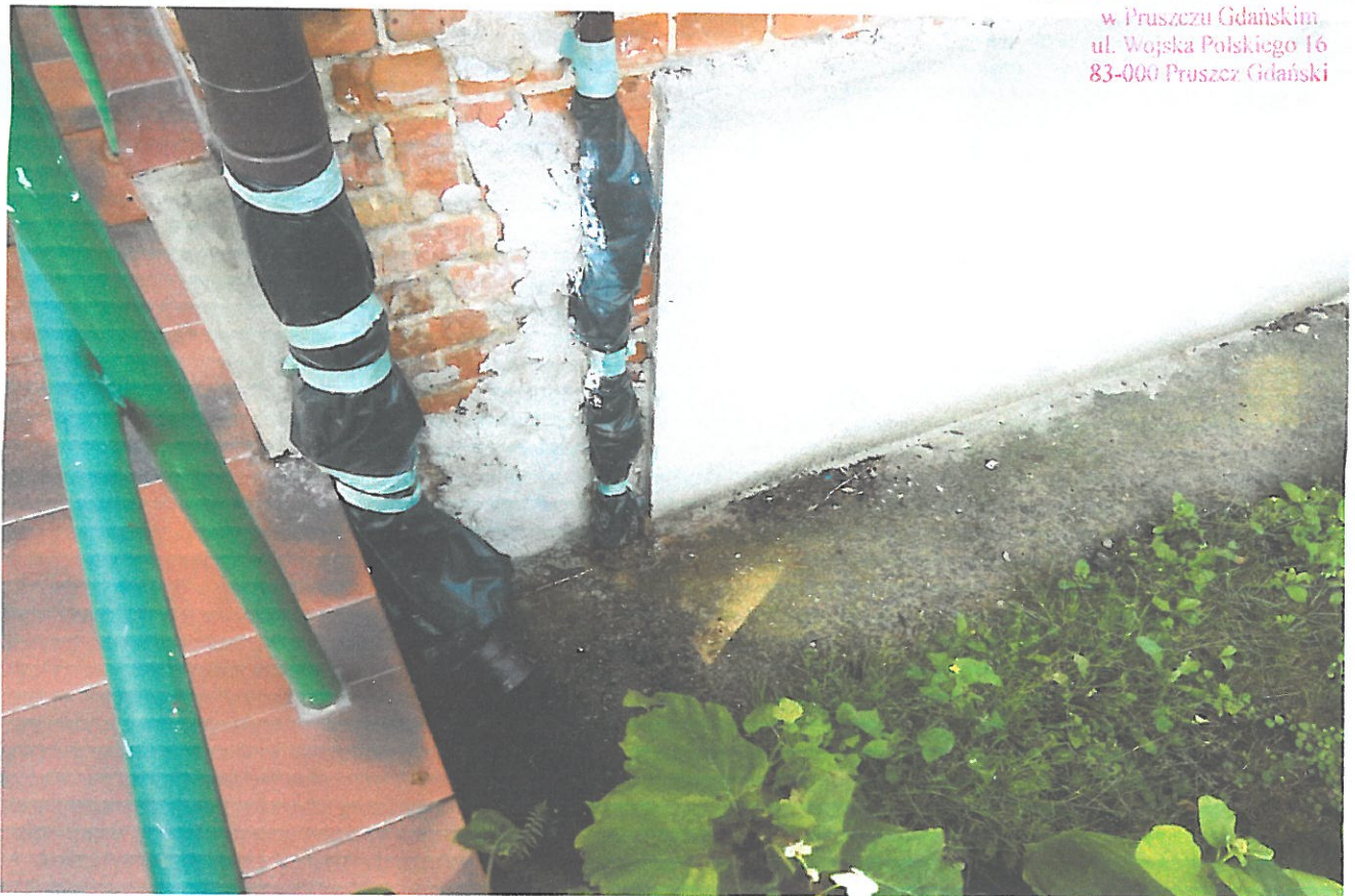
Zdj.7. Elewacja frontowa – detal istniejącego cokołu
