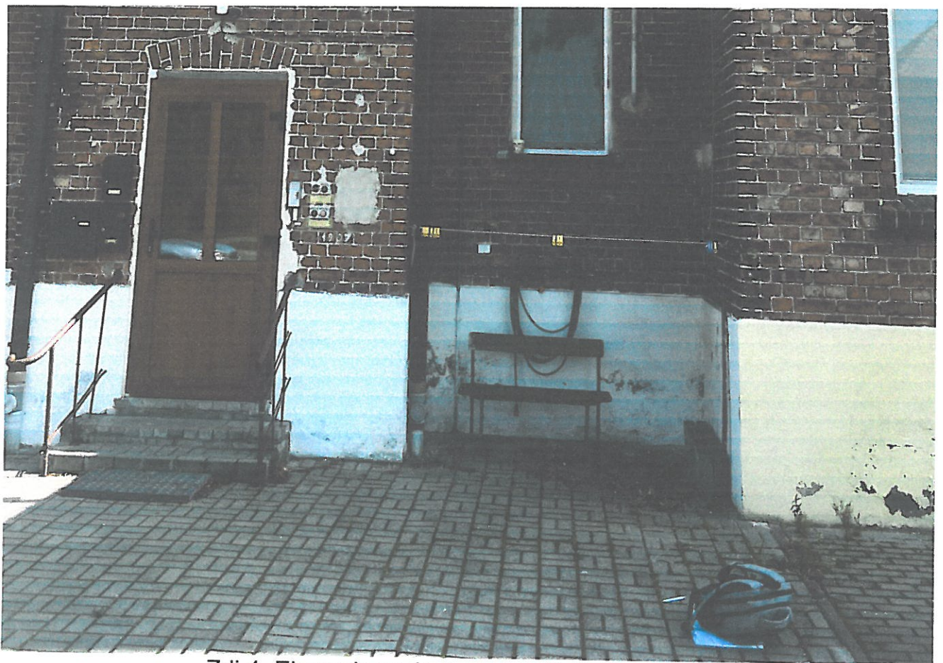
Zdj.4. Elewacja podwórza – wejście do budynku
