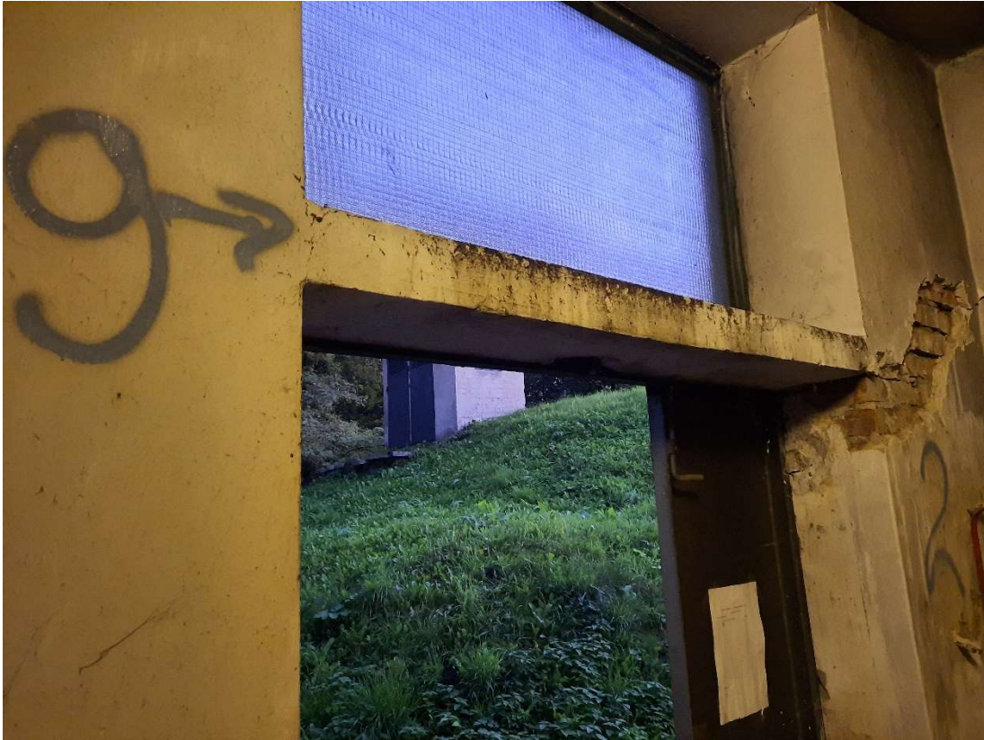
Rysunek 514. Odkrywka 9 - Nadproże nad wejściem do pomieszczenia przy osi 1-A (od wewnątrz).
