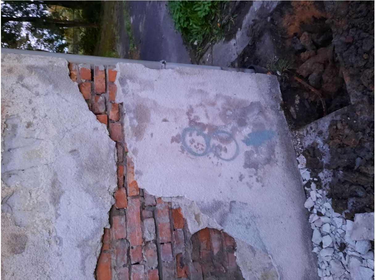
Rysunek 615. Odkrywka 8 - Odkrywka fundamentów.
